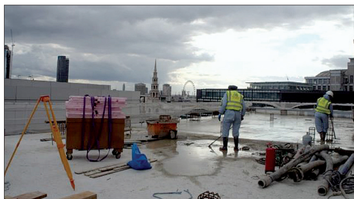
Na streche 20 Farringdon, počas betonáže strechy.
