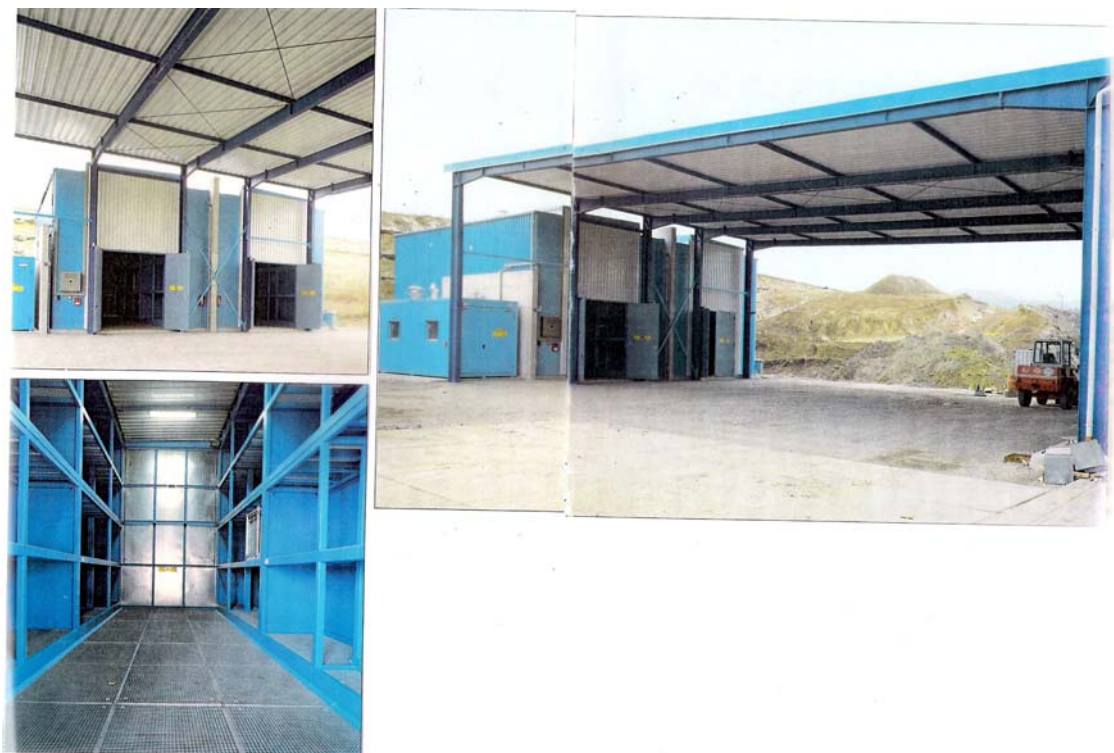
Obr.5.22 Pohľad na preberaciu plochu, na regály a roštovú podlahu v sklade
