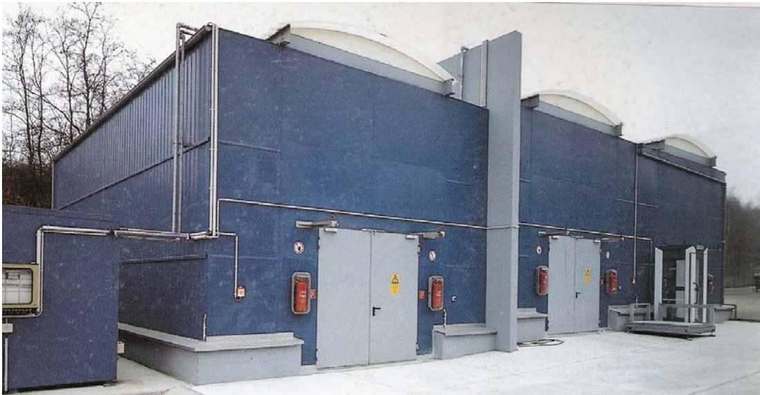
Obr.5.23 Celkový pohľad na haly stanovišťa
