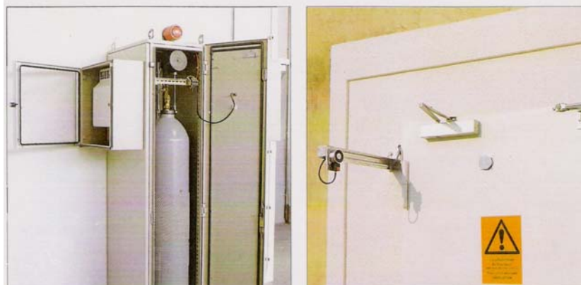
Obr.5.26 Požiarne zabezpečenie stanovišťa NO – fľaša s CO 2 – magnetické zachytenie dverí
