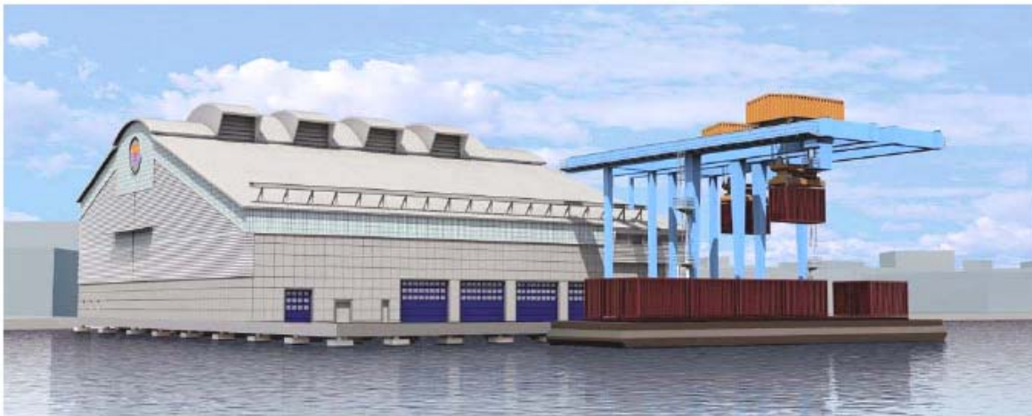
Obr. 7.27 Prekladacia stanica na lode s prekladáním kontajnérov pomocou žeriava
