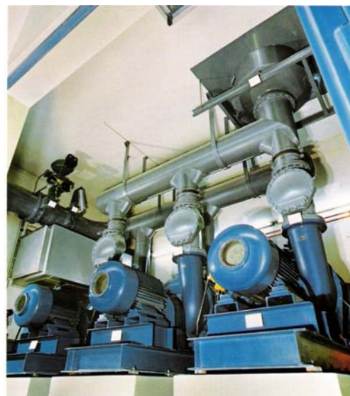
Obr.4.19 Pohľad na ventil zhadzovacej šachty s ovládaním a vývevy systému
