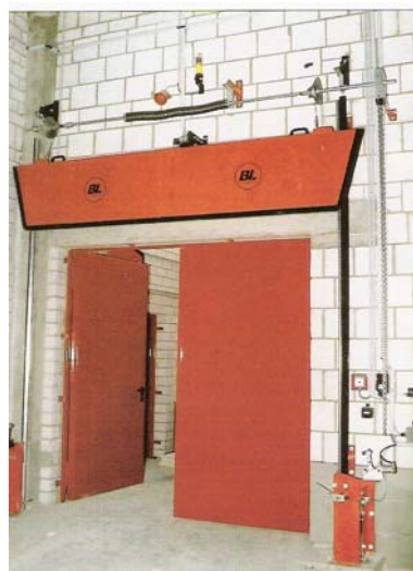
Obr.5.25 Požiarna závora – na zachytávanie vody z hasenia
