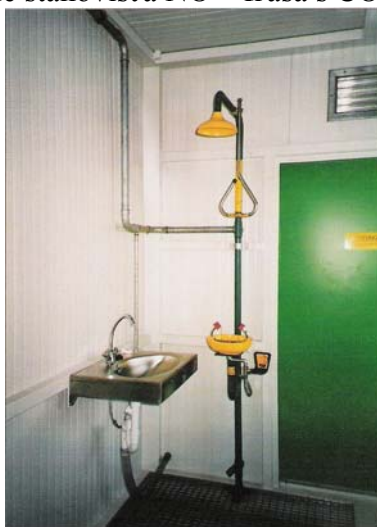
Obr. 5.27 Hygienické opatrenia -sprcha a dýzy na výplach očí
