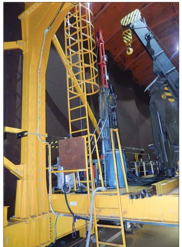
Pohľad na strednú skruž a vrtnú súpravu
