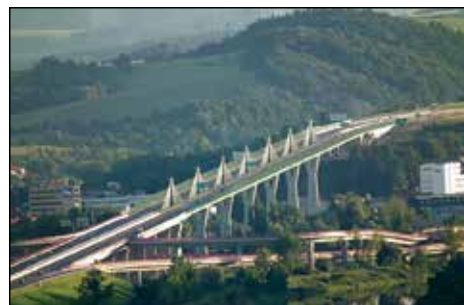
Mestská estakáda v Považskej Bystrici (2010) – 1. miesto v kategórii Inžinierska stavba
