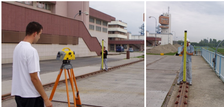
Obr. 7.16. Meranie výškového priebehu koľajnicových pásov geometrickou niveláciou
