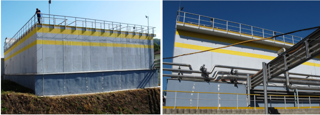
Obr. 5.27. Steny aktivačnej nádrže č. 1 ČOV
