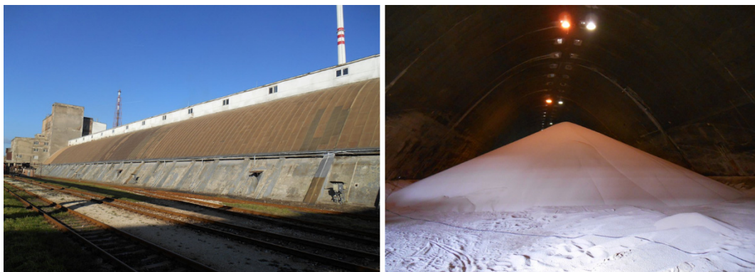
Obr. 5.25. Konštrukcia skladu umelého hnojiva, Duslo a.s. Šaľa
