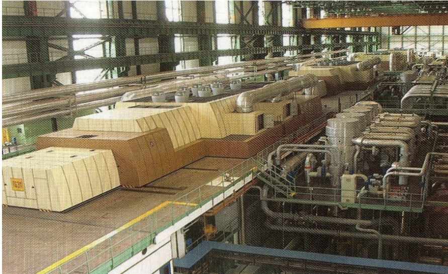
Obr. 9.6. Pohľad na štvoricu turbogenerátorov v strojovni HVB
