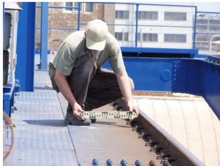
Obr. 7.14. Použitie vodorovného meradla
