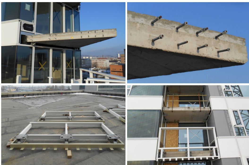
Obr. 5.21. Kotevné vložky na balkóne juhovýchodnej steny a konštrukcia zábradlia
