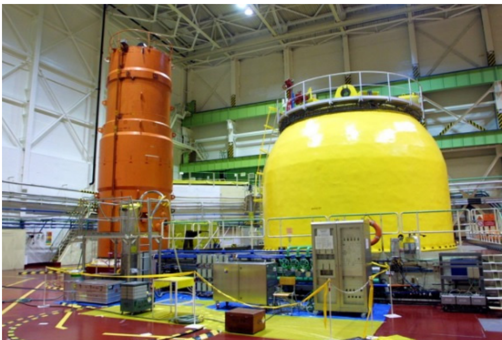
Obr. 9.5. Pohľad do reaktorovej sály na vrchnú časť reaktora
