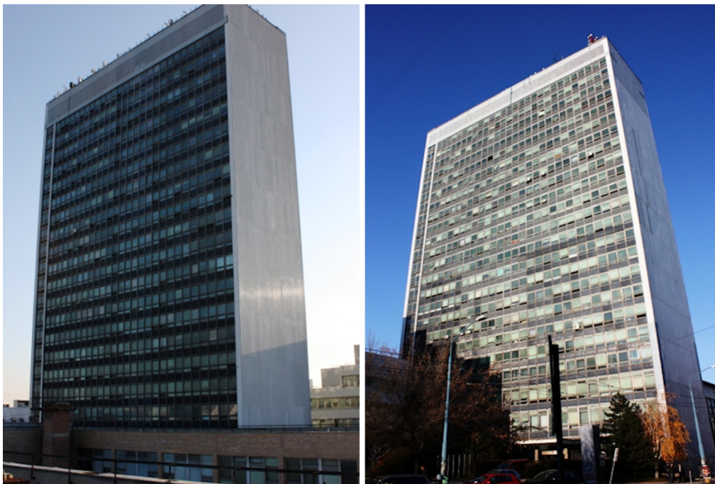
Obr. 5.23. Pôvodné opláštenie budovy Stavebnej fakulty STU v Bratislave – blok C severovýchodný (vľavo) a juhozápadný pohľad (vpravo)
