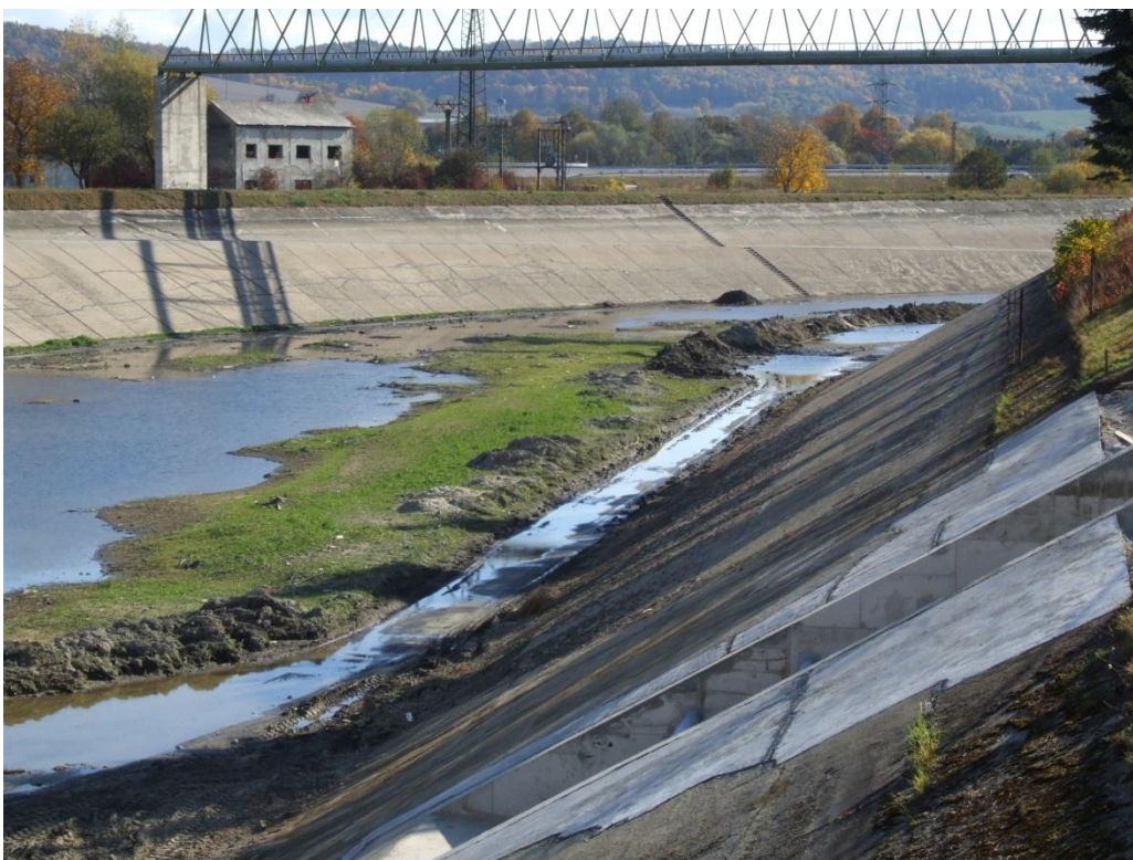
Obr. 5.3. Lokálne nánosy sedimentov v prívodnom kanáli k VE
