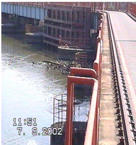
Obr. 3.11. Odtrhnutie hrubých nečistôt od hrablic spätnou vlnou – hať Drahovce
