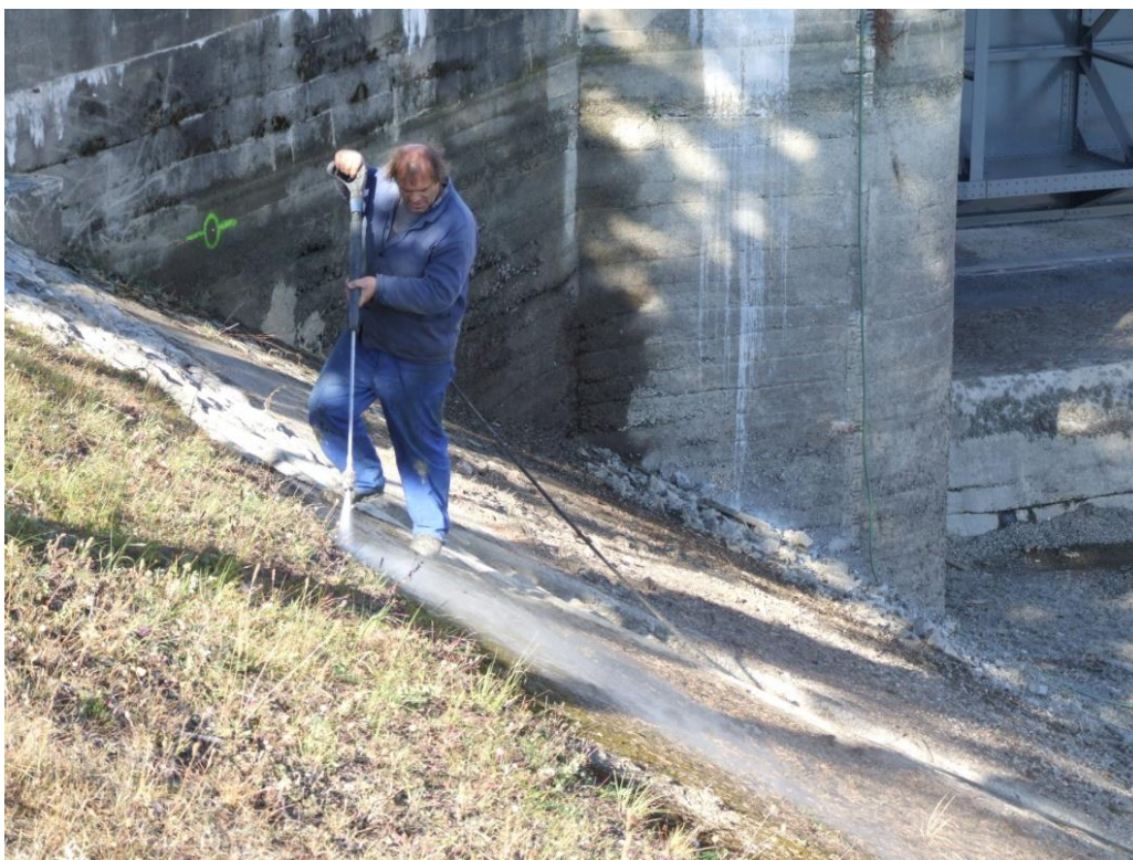
Obr. 5.9. Odstraňovanie ulitníka z betónového tesnenia kanála tlakovou vodnou pištoľou
