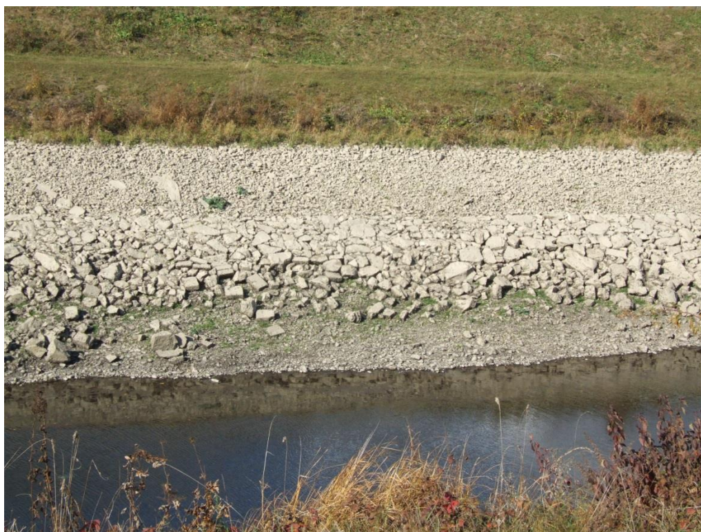
Obr. 5.4. Lokálne rozobrané kamenné opevnenie brehu
