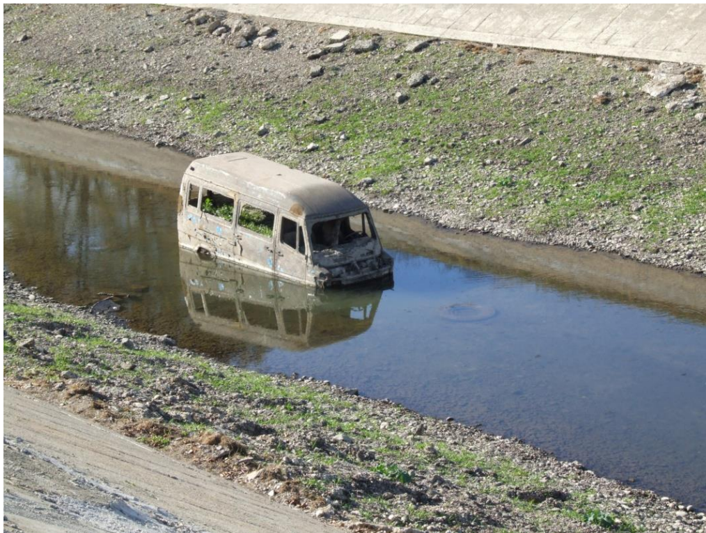
Obr. 5.2. Prekážka (mikrobus) v odpadovom kanáli – zvýšené lokálne straty
