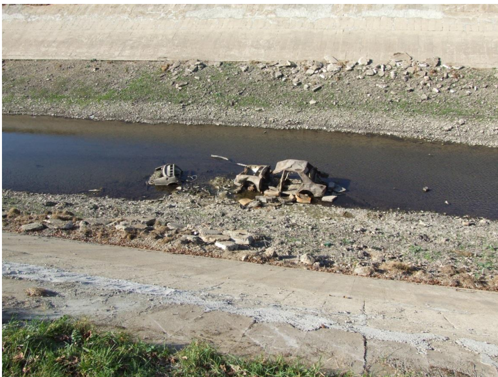
Obr. 5.1. Prekážka (automobil) v odpadovom kanáli – zvýšené lokálne straty
