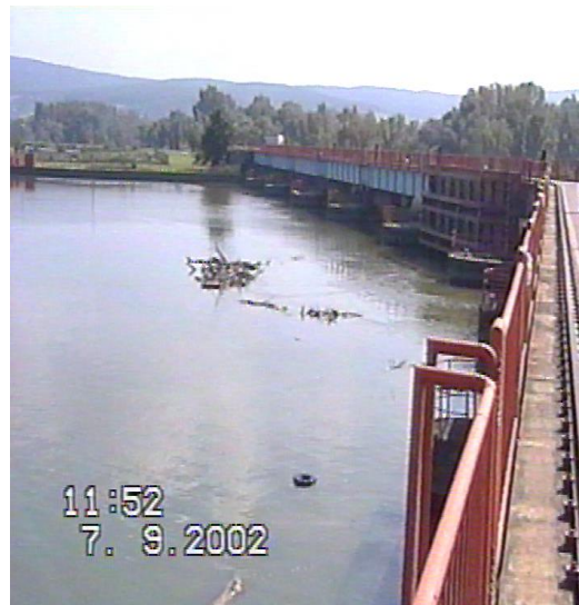
Obr. 3.11. Odtrhnutie hrubých nečistôt od hrablic spätnou vlnou – hať Drahovce
