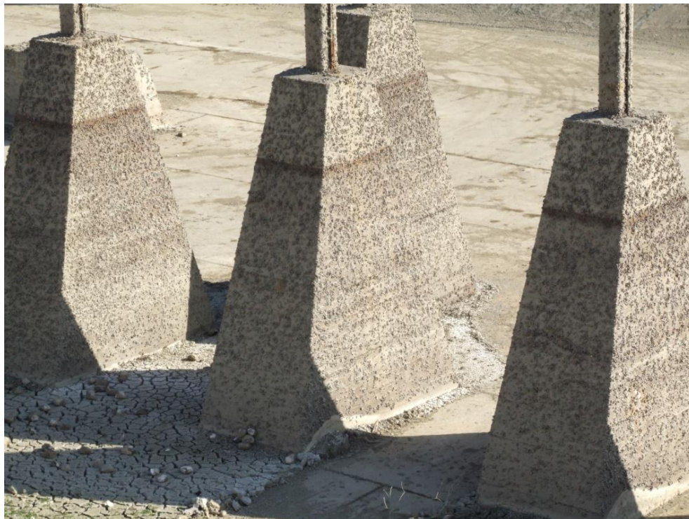
Obr. 5.8. Ukážka pokrytia betónových konštrukcií ulitníkom (nedobudovaná časť plavebnej komory nad VE)
