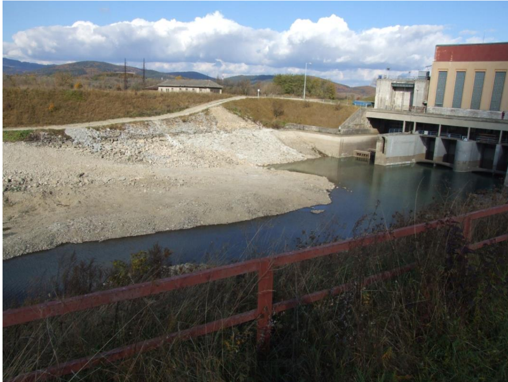
Obr. 5.5. Zníženie prietocnej kapacity a transformačného účinku dolnej zdrže VE
