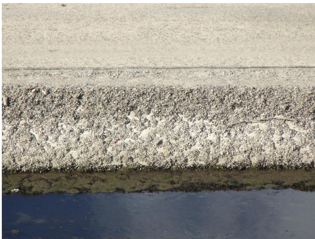
Obr. 5.10. Neodstránené kopýtko z odvodňovacej drážky veľkého PK
