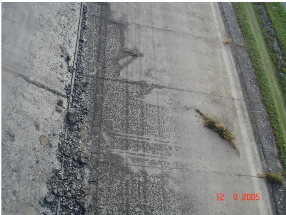
Obr. 5.6. Poškodenie tesnenia betónového povrchu PK
