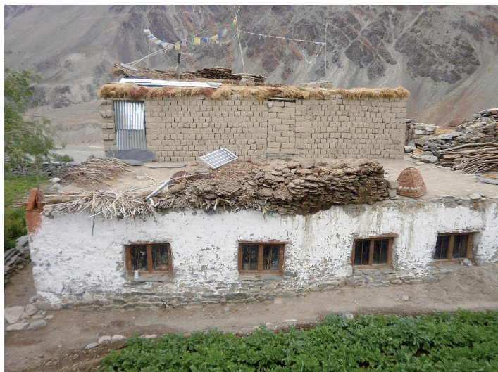
Typický himalájsky domček z nepálenej hliny, s fotovoltaickým článkom a sušeným jačím trusom
