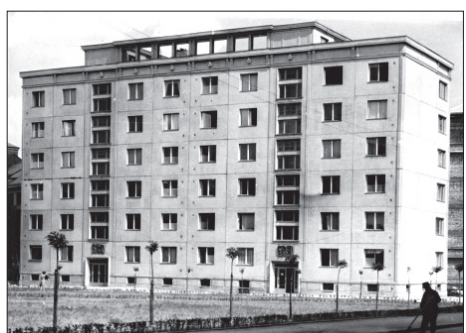
Prvá panelová budova (1956) bola postavená v Bratislave
