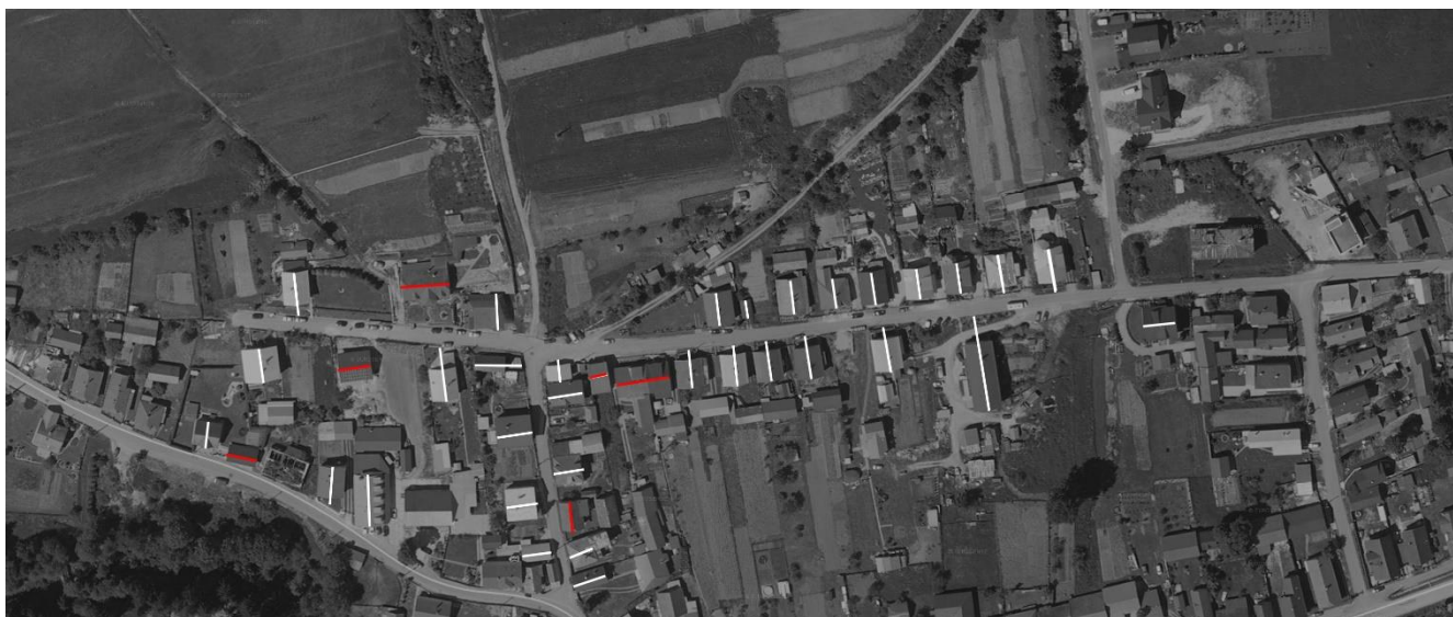
Nevhodná orientácia rodinných domov (vyznačenie červenou farbou) v rámci zástavby ktorá nerešpektuje vernakulárny princíp zástavby Hornej Oravy kolmej na komunikáciu v modelovej obci
