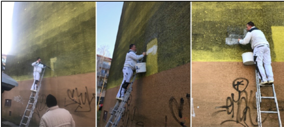
Obr. 3: Príprava podkladu pred osadením izolačných dosiek [autor]
