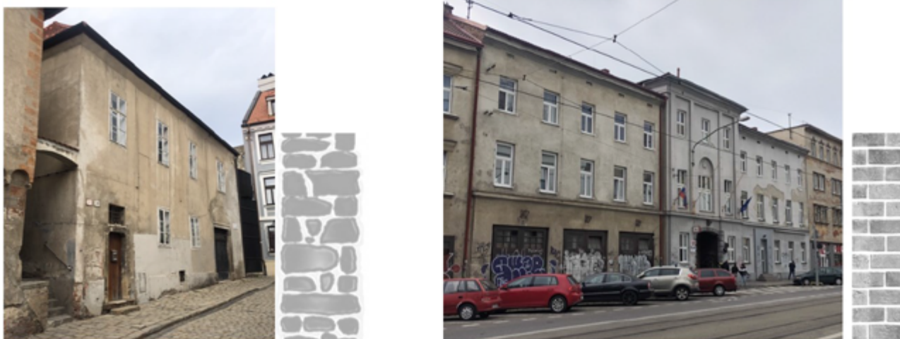
Obr. 1: Vľavo typický gotický meštiansky dom z pieskovcových murív obvodového plášťa. Vpravo objekt z prelomu 19. a 20. storočia postavený zo 450 mm hrubých tehlových múrov.
