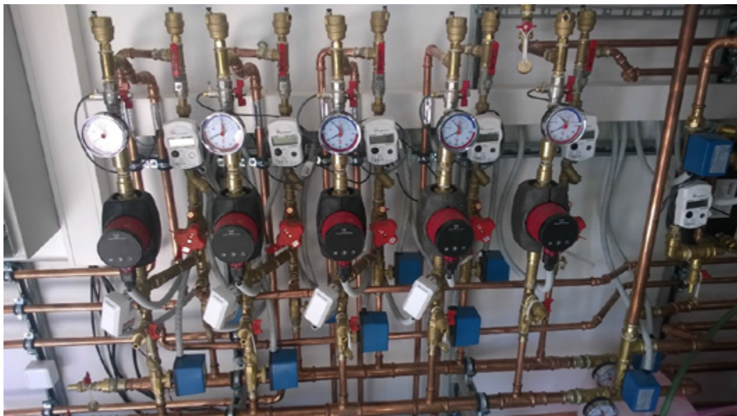
Obrázok 4: Rozdeľovač a zberač s meracími prístrojmi na strane odovzdávania tepla [Autor: Matej Kubica]
