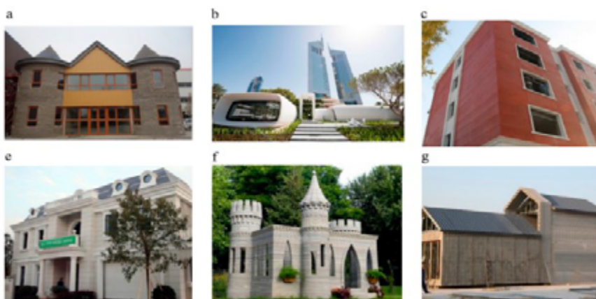
Obr. 1: Konštrukcie vytvorené technológiou kontúrovania [1]
