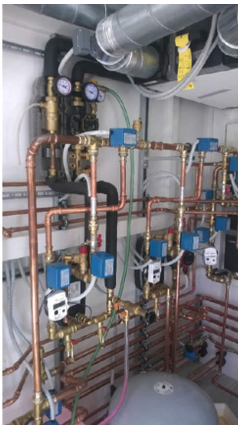
Obrázok 5: Rozdeľovač a zberač s meracími prístrojmi na strane zdrojov tepla [Autor: Matej Kubica]
