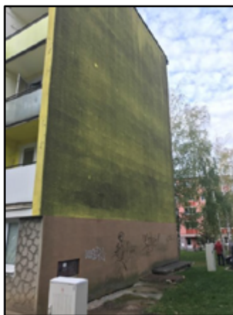
Obr. 2: Detail znečistenia fasády [autor]
