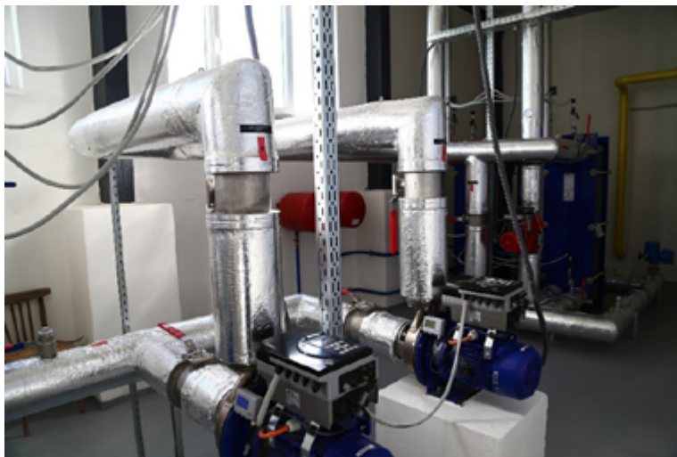
Obr. 6: Pohľad na výmenníky tepla VT1 a VT2 [9].
