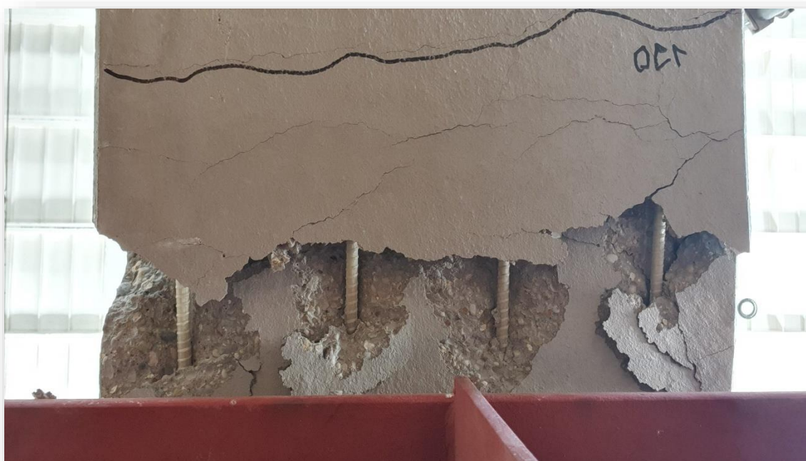
Obr. 4.5 Porušenie prvku S1 pri podpere – spodný povrch
