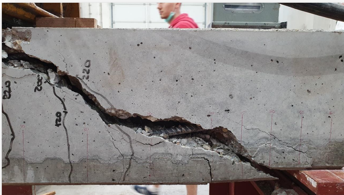
Obr. 4.8 Detail porušenia prvku S2 – zadná strana
