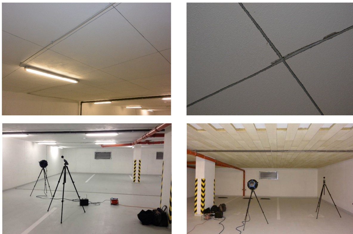
Obr. 14 Pohľady na rozrezanú plochu ETICS a stav pred úpravou a po úprave skladby zateplenia BD Bratislava Kramáre
