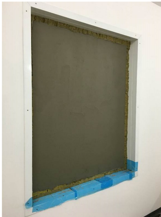
Obr. 7 Postup realizácie kontaktného zatepl'ovacieho systému s izoláciou EPS Baunit hr. 160 mm
