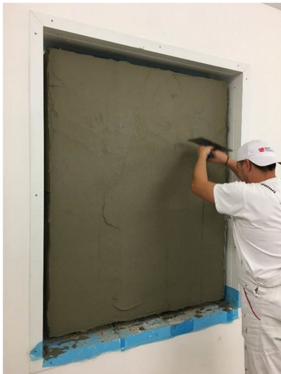
Obr. 8 Postup realizácie kontaktného zateplňovacieho systému s izoláciou MV hr. 160 mm
