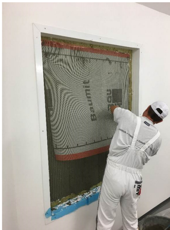
Obr. 6 Postup realizácie kontaktného zatepl'ovacieho systému s izoláciou EPS Baumit Open hr. 160 mm
