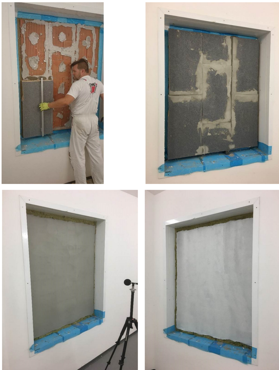
Obr. 9 Postup realizácie kontaktného zatepľovacieho systému s izoláciou Resol hr. 80 mm
