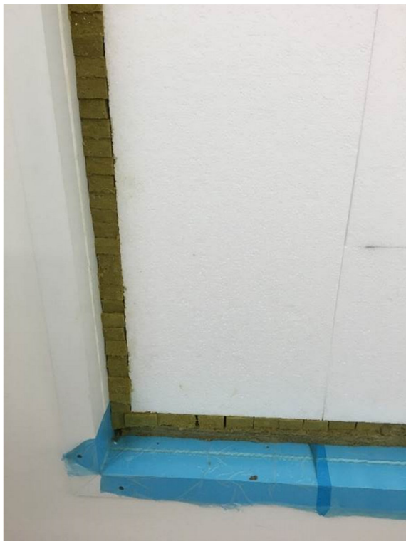
Obr. 7 Postup realizácie kontaktného zatepl'ovacieho systému s izoláciou EPS Baunit hr. 160 mm
