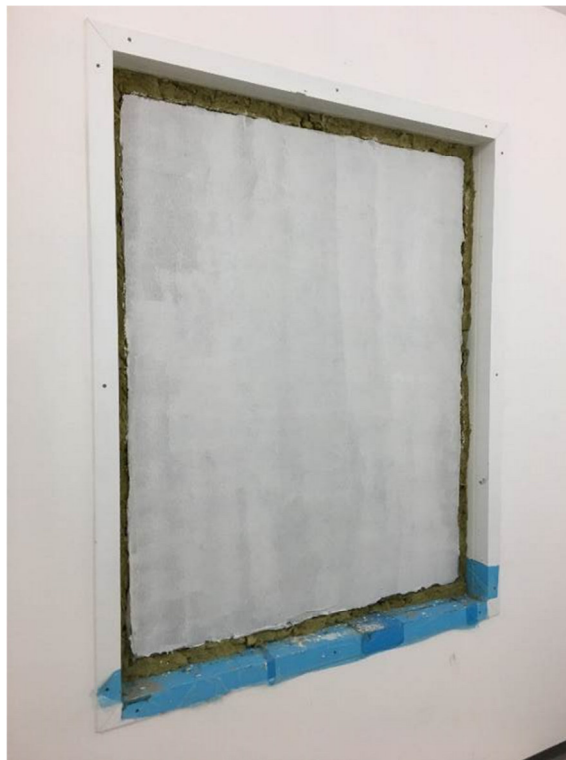
Obr. 8 Postup realizácie kontaktného zateplňovacieho systému s izoláciou MV hr. 160 mm
