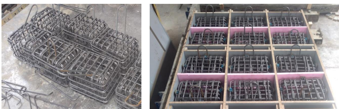
Obr. 5.2 Výstužný kôš pripojených blokov a príprava betonáže vzoriek 2. série
