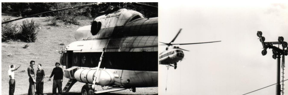
Obr. 1.1: Výstavba sedačkovej lanovej dráhy Turecká - Krížna pomocou vrtuľníka Mi-8 (archív p. Martina Vajsa)
