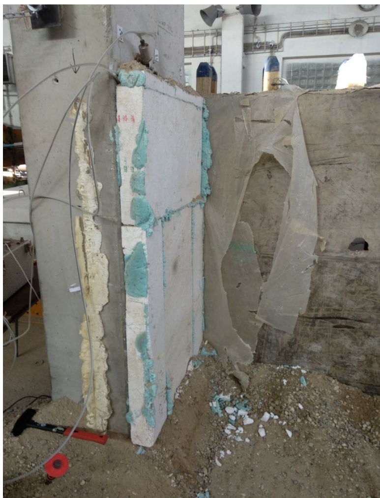
Obr. č. 5.7 - Vrstva polystyrénu po odstránení zemného telesa - po sérii č. 3
