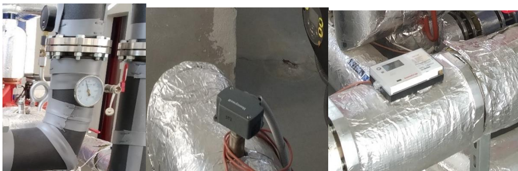
Obr. 4.1 Zabudované meracie prístroje v potrubíach
