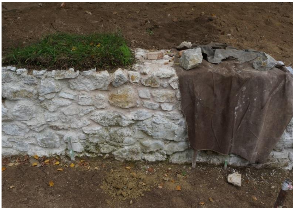
Obrázok 3: Konzervované bloky muriva s aplikovaným rôznym spôsobom ošetrovania koruny, október 2015. foto: autor
