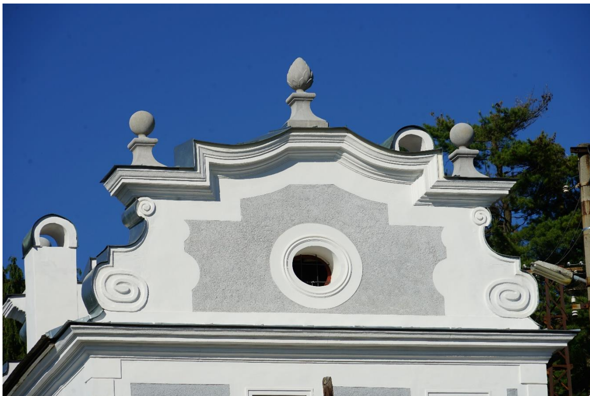
Obrázok 5 Použitie vápenných mált pri obnove barokovej Piargskej brány. Údaje sú zahrnuté v databáze objektov. 2021. foto: autor
