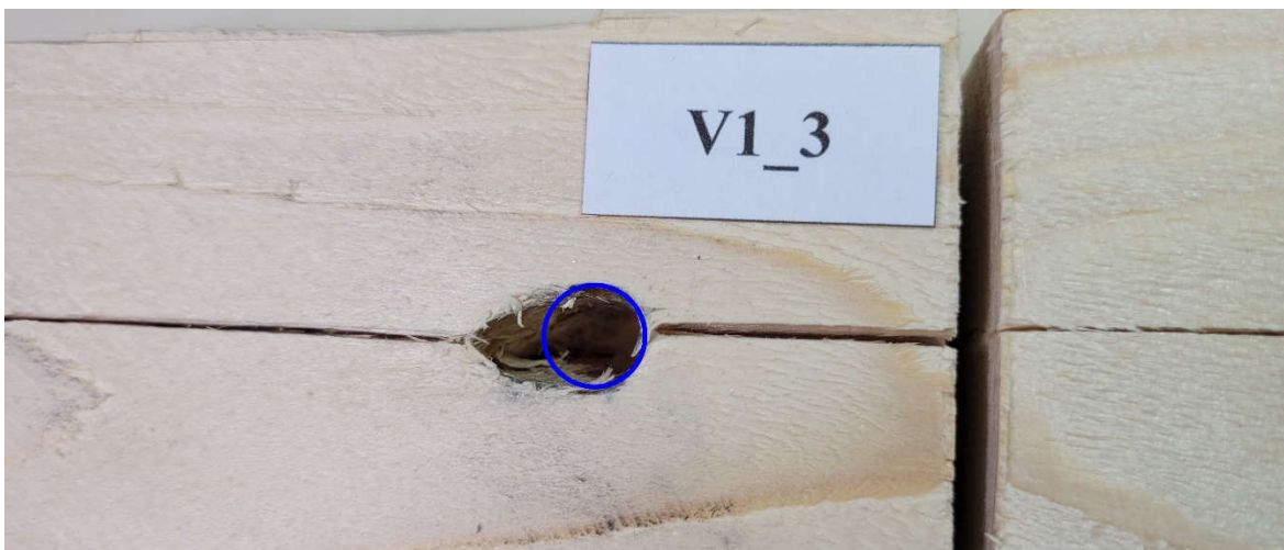
Obr. 4.2 Zdeformovaný otvor po odrezaní konca KVH konzoly
