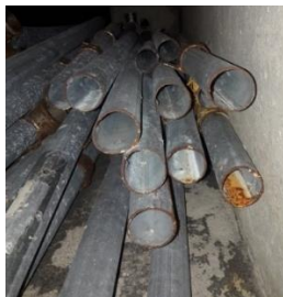
Obr.2.1: Potrubie vodovodu v budove základnej školy [autorka] a) pôvodné pozinkované potrubie, b) nové potrubie z ušľachtilej ocele, c) izolácia potrubia
