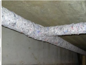
Obr.2.1: Potrubie vodovodu v budove základnej školy [autorka] a) pôvodné pozinkované potrubie, b) nové potrubie z ušľachtilej ocele, c) izolácia potrubia
