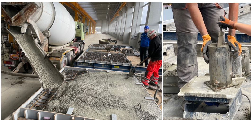
Obrázok 1.7 Proces betonáže skúšobných vzoriek
