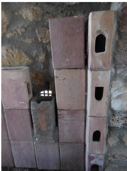
Obr. 4-3-4. Bočný pohľad na zvláštne dutinové tehly s dvojsmerne priebežnými dutinami používané na vykurovanie stien.
