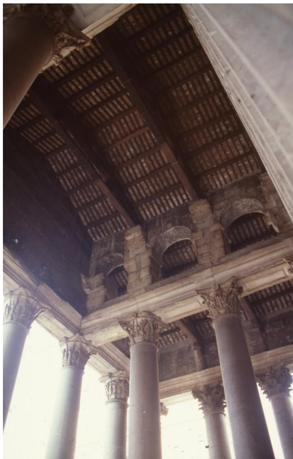
Obr. 3-8-2. Pohľad do strešnej konštrukcie portika rímskeho Pantheonu.
