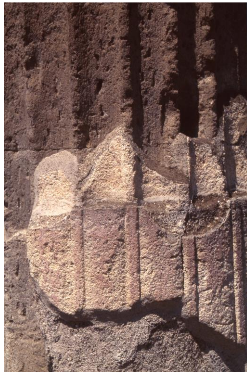
Obr. 3-3-6. Dekoratívna úprava drieku stĺpa zhotovená nanesením omietky cez pôvodné kanelúry. Dekoratívny vzor v omietke nezodpovedá žiadnemu zo známych klasických slohov.
