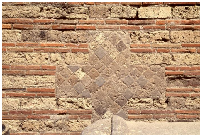
Obr. 3-2-22. Zmiešané murivo opus vittatum mixtum z tufových kameňov a dvojriadkov tehál. Murivo je dekorované krížom z tufu.
