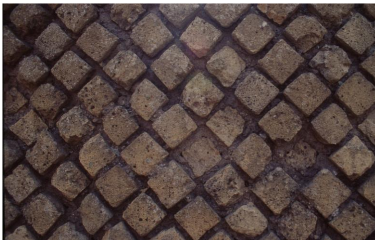
Obr. 3-2-15. Opus reticulatum z Pompejí.
