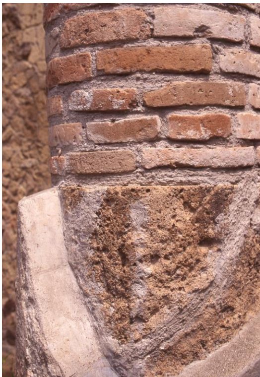
Obr. 3-3-5. Jadro drieku stĺpa zhotovené z tehál a omietnuté hrubou vrstvou omietky.
