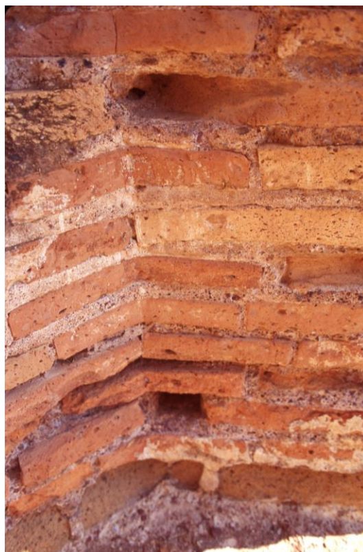
Obr. 4-3-3. Zvláštne pálené tehly tvaru otvoreného L použité na previazanie kúta jednej z miestností Hadriánovej vily v Tibure.
