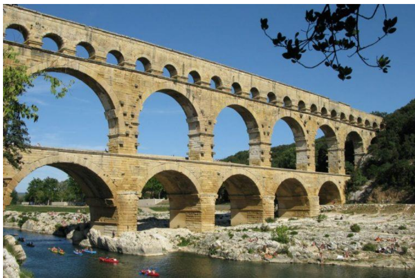
Obr. 5-2-2. Most akvaduktu Pont du Gard vo Francúzsku – na pilieroch je vidieť kamene vystupujúce z plochy stien pilierov kvôli vytvoreniu podpory na lešenie [https://www.machines4u.com.au].
