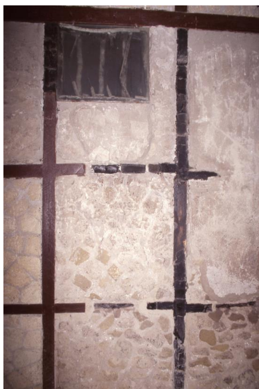
Obr. 3-2-17. Jediný zachovaný príklad Opus craticium v Herkuláneu.
