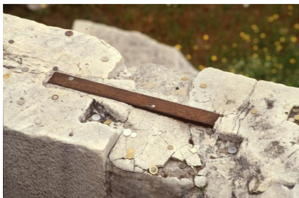
Obr. 4-1-5. Pohľad na styk dvoch kameňov prekľadu. Kamene sú spojené kovovou murárskou skobou asi v 19. storočí, avšak na ľavom kameni je vidieť miesto osadenia pôvodnej železnej spony motýlikového tvaru.
