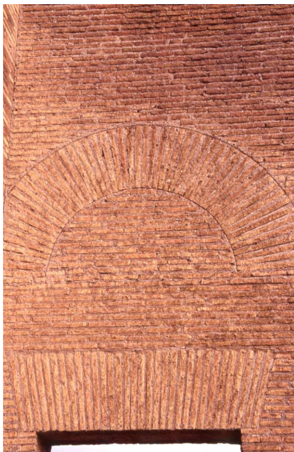
Obr. 2-3. Základná schéma rímskeho staviteľ'stva – múr a klenba.
