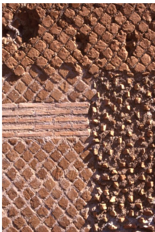
Obr. 3-2-24. Múr v Hadriánovej vile v Tibure so stopami troch rôznych konzervačných metodických prístupov. Vrchná časť je originálna rímska stena, časť vpravo je výsledkom konzervačného zásahu zo 60.tych rokov 20.teho storočia a časť vpravo je výsledkom uplatňovania novšej metodiky, ktorá vyžadovala jasné vizuálne odlíšenie moderného doplnku zatlačením líca steny. Aj tento prístup je už dnes prekonaný, pretože netreba umelo naznačovať doplnok, ale snažiť sa o čo najpresnejšie nerušivé kopírovanie originálu. Doplnok sa aj tak dá rozoznať.
