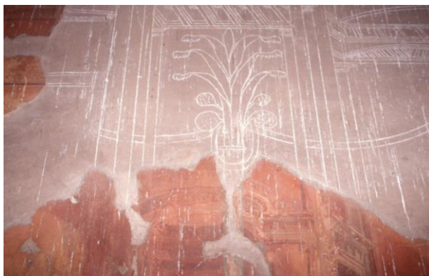
Obr. 3-14-1. Poškodená, alebo nedokončená dekoratívna omietka v Herculaneu. Pod chýbajúcou záverečnou vrstvou vidno pracovný náčrt remeselníka.
