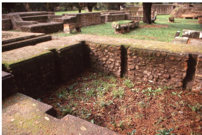
Obr. 3-2-12. Opus caementitium, použité bez obkladu na stavbu hrobky v nekropole v Ostii. Vidieť zachované miesta na stojky debnenia.
