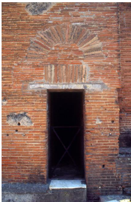
Obr. 3-4-3. Záťaž nesúci oblúk nad dverným otvorom v Pompejách.
