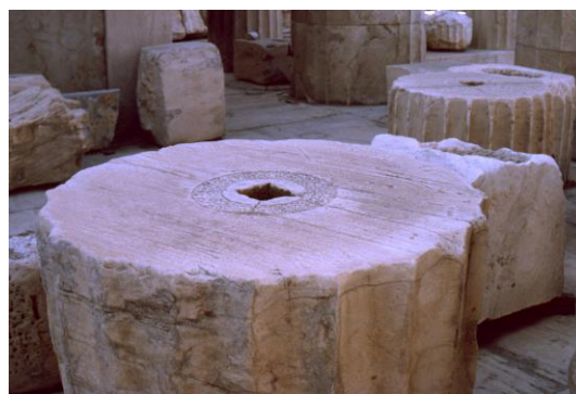
Obr. 3-3-4 Článok drieku stĺpa so stredovým otvorom na umiestnenie spojovacieho prvku.
