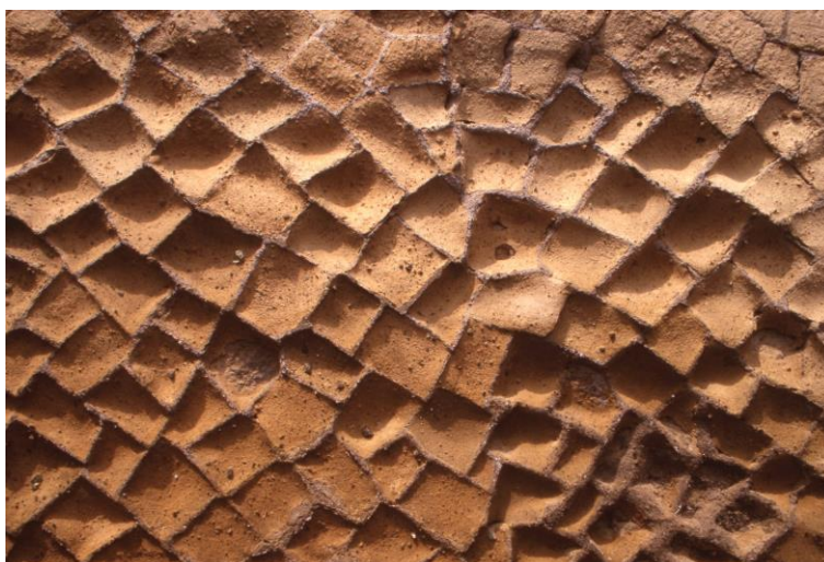
Obr. 3-2-14. Opus quasi reticulatum z Pompejí. Na dielce muriva bol vybraný mäkkší materiál, ktorý bol menej odolný erózií než spojovacia vápenná malta.
