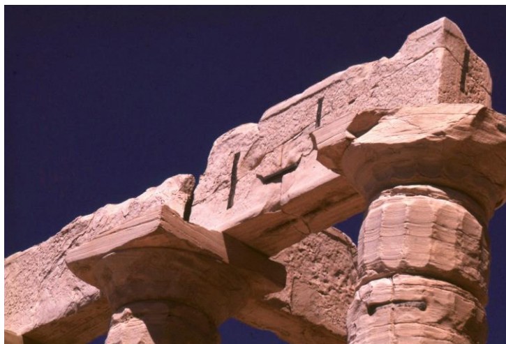
Obr. 2-2. Základ gréckeho staviteľ'stva – stĺpy a preklady.
