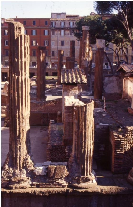
Obr. 4-1-2 Torzá stĺpov najstarších zachovaných murovaných chrámov v Ríme, zhotovené z pomerne mäkkého a málo odolného hnedého tufu.
