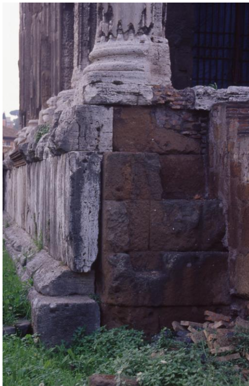
Obr. 3-15-3. Z lacnejšieho a ľahšie opracovateľného tufu zhotovená hrubá stavba Herkulovho chrámu v Ríme, obložená mramorovými platňami.
