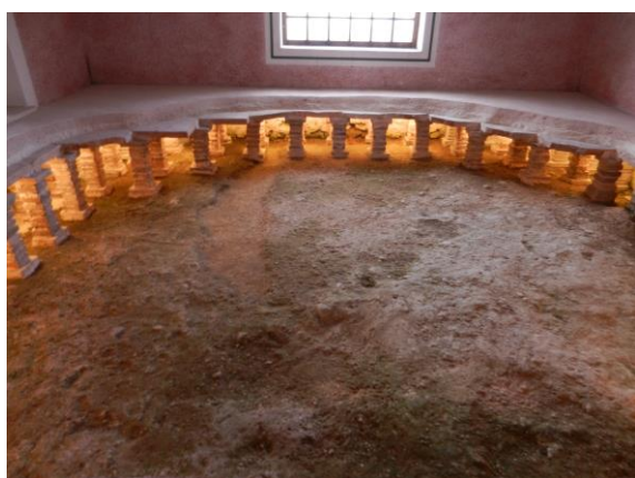
Obr. 3-16-1. Podlahové vykurovanie (hypocaustum) v didakticky rekonštruovanom reze v budove v Carnunte.
