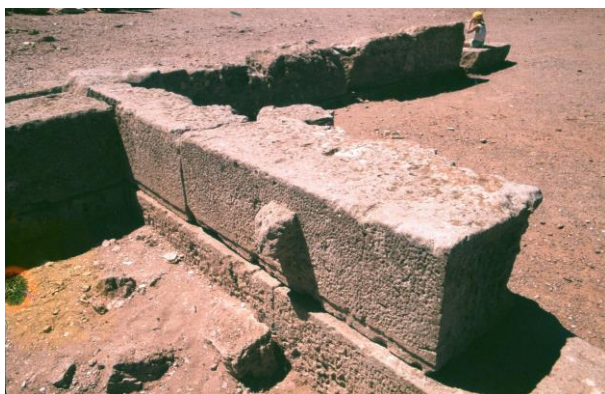
Obr. 6-5-5. Staroveký kváder s dvoma na protiľahlých stranách ponechanými montážnymi výstupkami na zachytenie montážnych klieští (mys Sounion v Grécku).
