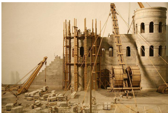
Obr. 6-0-1. Výtvarníková predstava spôsobu budovania mestskej brány mesta Castra Regina (Regensburg v Bavorsku). Zobrazený je menší derikový a väčší kolesový žeriav s mikrozdvihom ako aj stĺpové lešenie [ https://www.regensburg.de ].
