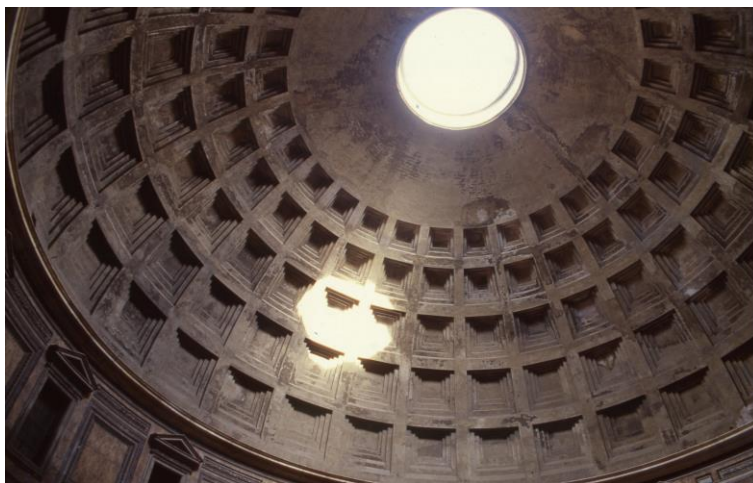
Obr. 3-7-1. Kazety v chráme Pantheon, ktoré okrem toho, že vytvorili dekoráciu podhl'adu, tak aj odľahčili masu betónu, z ktorého je zhotovená kupola.
