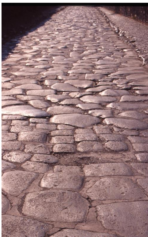
Obr. 5-3-3. Dlaždený povrch dodnes používanej rímskej diaľnice Via Appia v Ríme.
