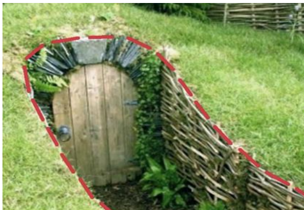
Obr. 3.15. Pivnica – prienik so zemským povrchom (vstupný portál).
