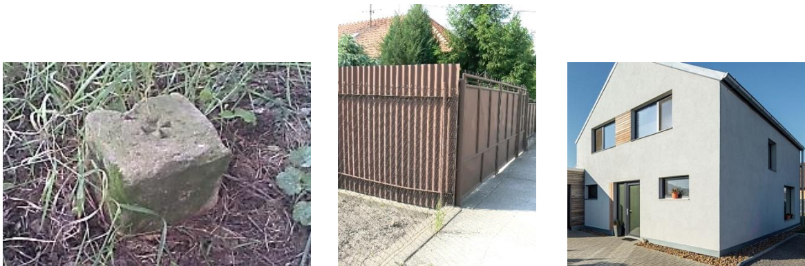
Obr. 3.9. Trvalé označenie lomových bodov hraníc.
