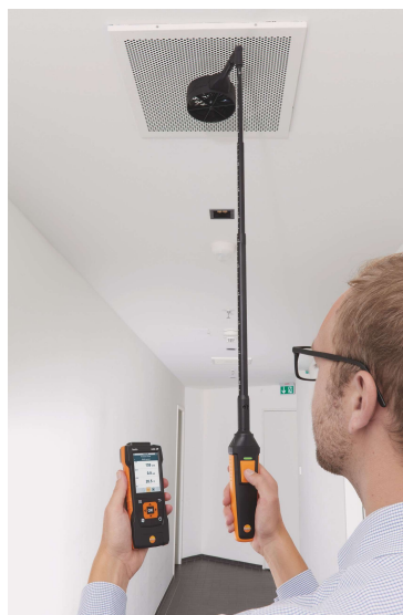
Obr. 8.9 Meranie rýchlosti prúdenia vzduchu v potrubí a na distribučnom prvku (Testo, 2021)
