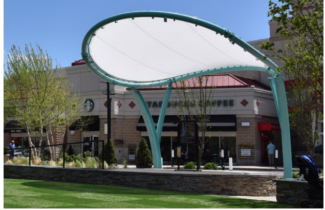
Obr. 2.8. Membránové prestrešenie pódia (Baltimore, USA).
