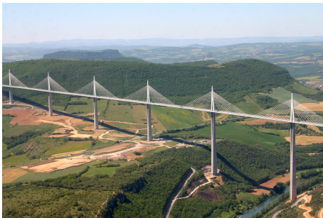
(a) Viaduc de Millau (Francúzsko [9]).
