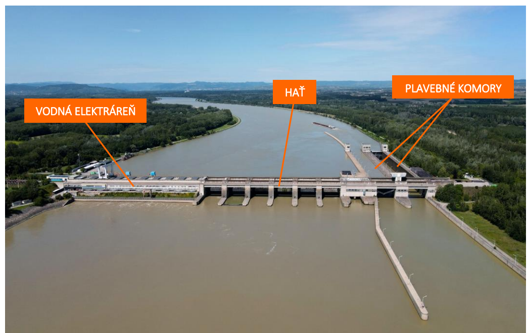
Obr. 3.8 Vodné dielo Altenwörth na Dunaji, Rakúsko (Zdroj: © C. Stadler/Bwag)
