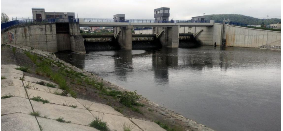
Obr. 5.55 Príklad opevnenia brehu betónovými doskami (Zdroj: rieky.sk, © Plameňák)
