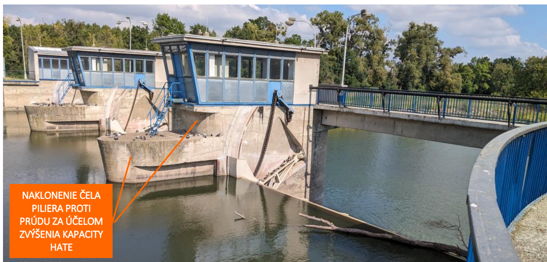
Obr. 5.63 Segmentový uzáver hate MVE Bulhary na rieke Dyje, ČR (Zdroj: archív autora)
