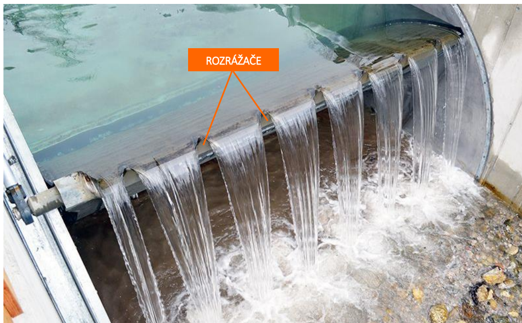
Obr. 8.38 Prepád vody ponad jednostranne zavesenú doskovú klapku s šírkou 5 m a hradiacou výškou 2 m na hati Jenbach, Rakúsko (Zdroj: wild-metal.com)
