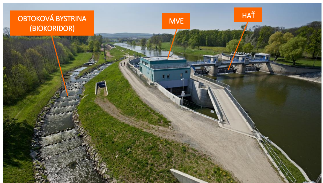
Obr. 3.18 Obtoková bystrina (biokoridor) MVE Bulhary na rieke Dyje, ČR ((Zdroj: renoenergie.cz)
