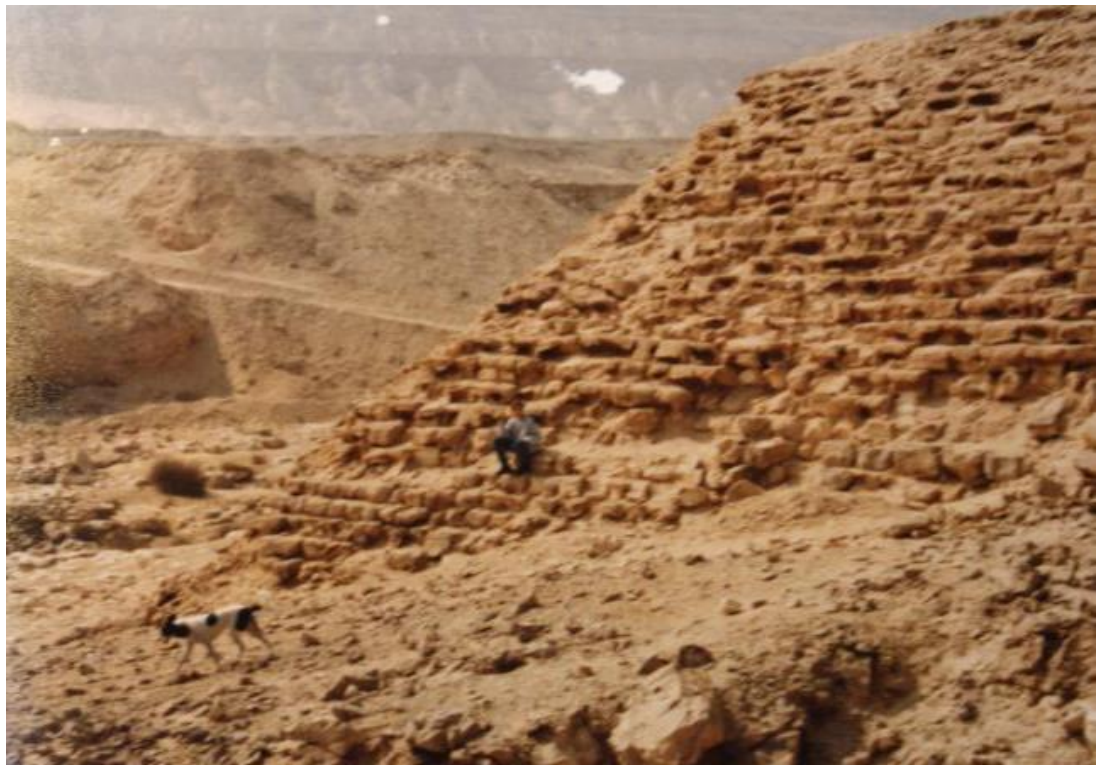
Obr. 2.1 Najstaršia známa vzdúvacia stavba Sadd el-Kafara v Egypte (Zdroj: wikimapia.org)
