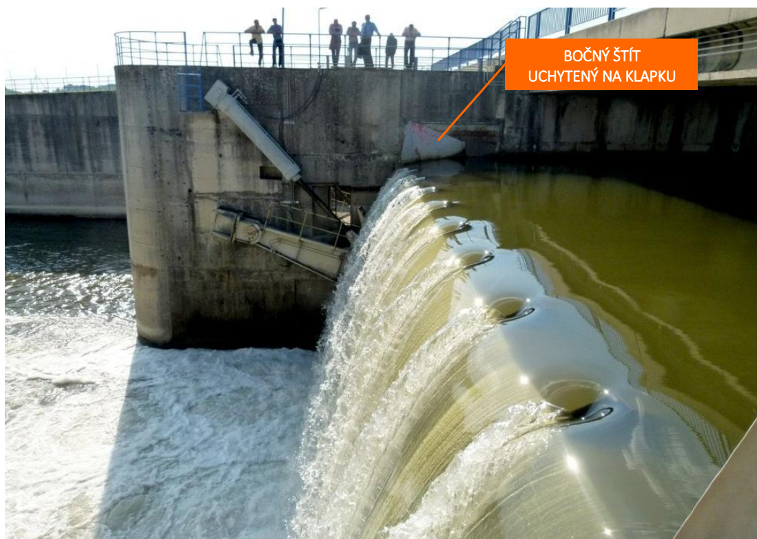
Obr. 8.85 Prepúšťanie prietoku cez nasadenú dutú klapku na segmente s celkovou hradiacou výškou 7,5 m a šírkou 21 m na hati Vodného diela Veľké Kozmálovce na Hrone (Zdroj: © Jana Némethová)
