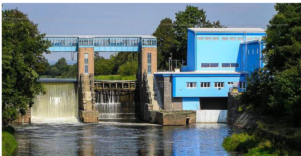
Obr. 8.35 Prepúšťanie prietoku ponad horné stavidlo dvojitého stavidla s hradiacou výškou 5,25 m na hati Vodného diela Smiřice na rieke Labe, ČR (Zdroj: czechhydro.com)
