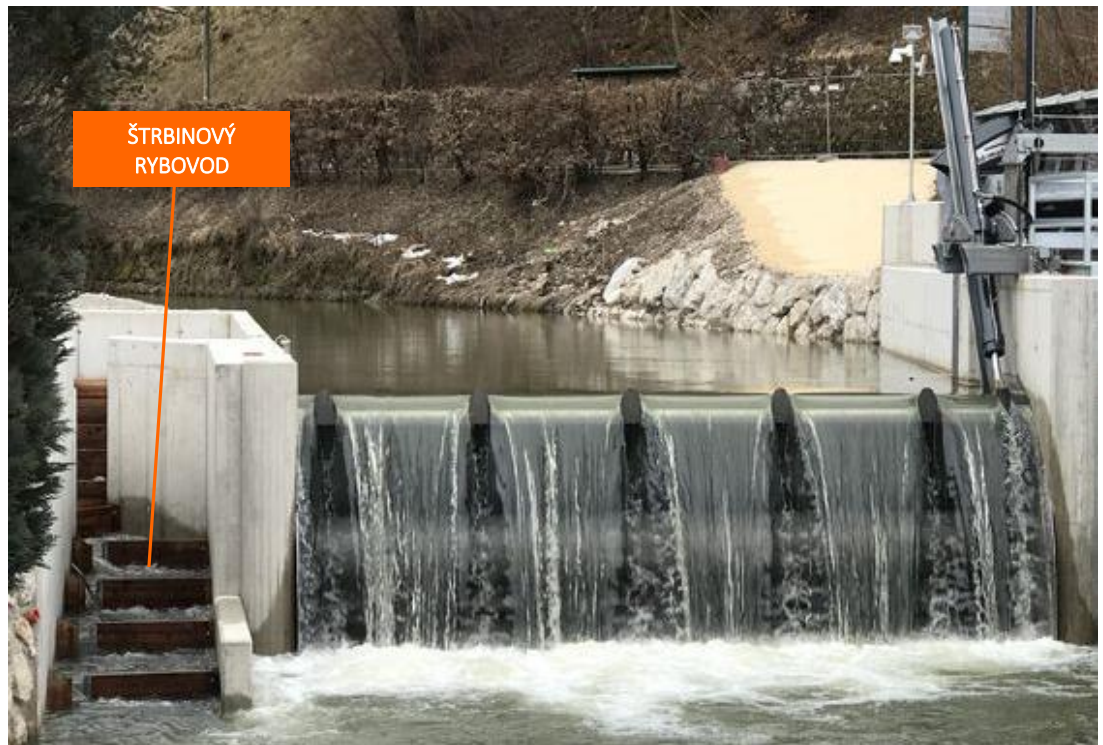
Obr. 3.20 Pohyblivá hať Windischgarsten s vnútrokorytovým štrbinovým rybovodom, Rakúsko (Zdroj: wild-metal.com)
