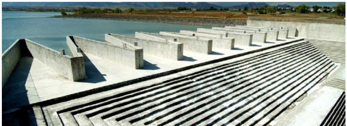
Obr. 7.3 Labyrintová hať Standley Lake, Westminister, Colorado, USA (Zdroj: researchgate.net, © K. Warren Frizell)
