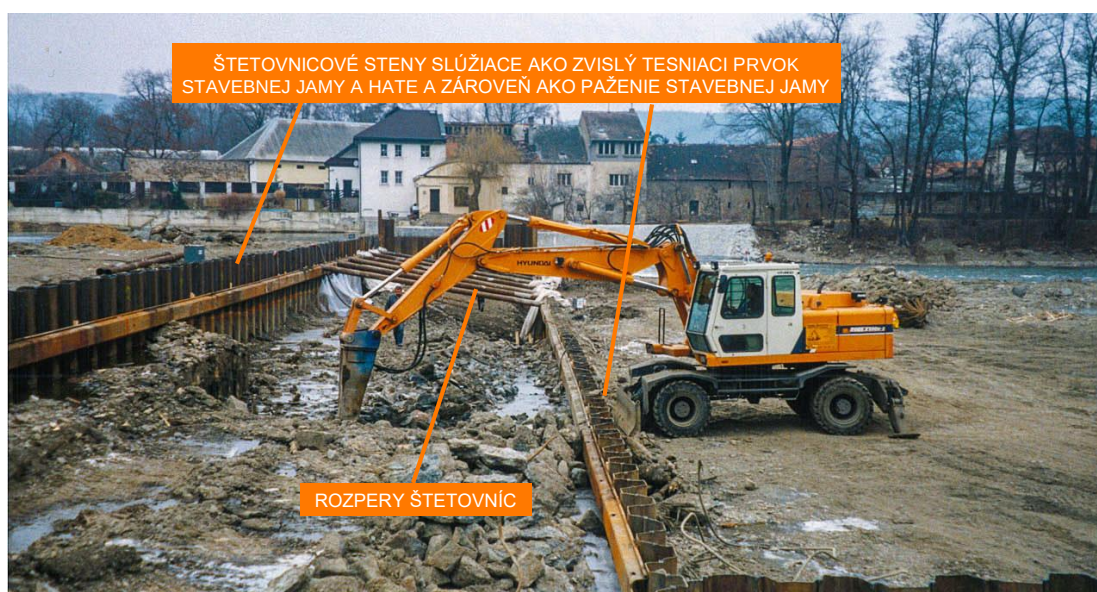
Obr. 10.8 Hĺbenie stavebnej jamy ohrádzovanej štetovnicovými stenami – etapová výstavba pevnej hate Dobřichovice na rieka Berounka, ČR (Zdroj: zakladani.cz)
