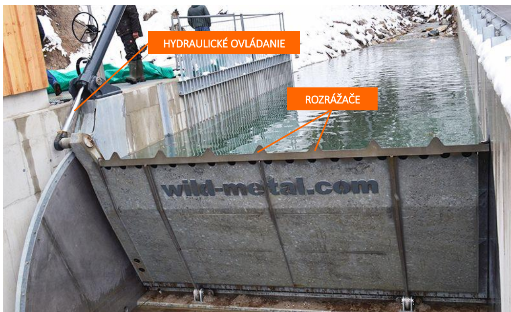
Obr. 8.37 Jednostranne ovládaná zavesená dosková klapka s šírkou 5 m a hradiacou výškou 2 m na hati Jenbach, Rakúsko (Zdroj: wild-metal.com)
