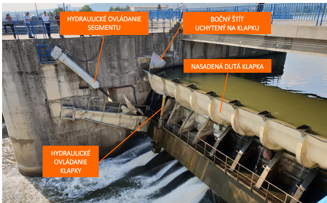
Obr. 8.84 Obojstranne hydraulicky ovládaný segment s nasadenou dutou klapkou s celkovou hradiacou výškou 7,5 m a šírkou 21 m na hati Vodného diela Veľké Kozmálovce na Hrone (Zdroj: © Martin Jurčo)
