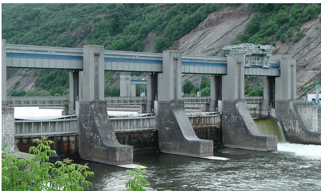
Obr. 8.34 Prepúšťanie prietoku ponad horné stavidlo dvojitého stavidla s hradiacou výškou 9,4 m krajným poľom hate na Vodnom diele Vrané nad Vltavou, ČR (Zdroj: cez.cz)
