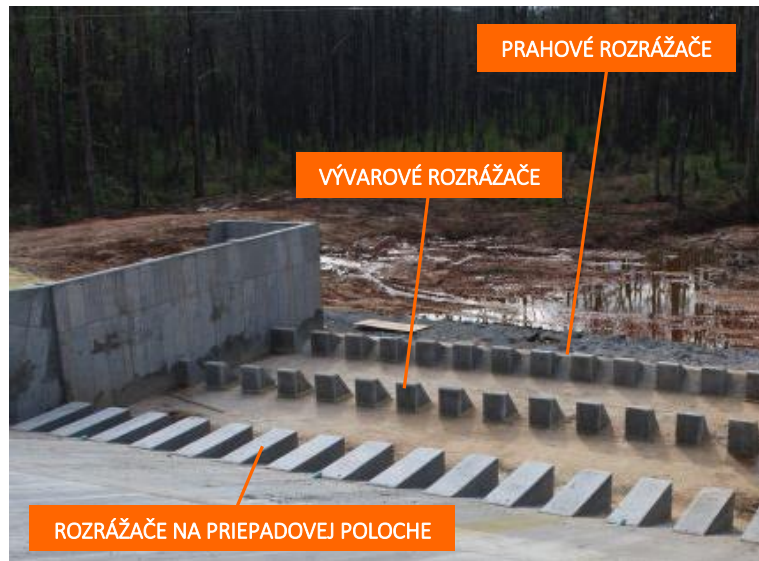
Obr. 4.31 Realizácia rozrážačov, Texas, USA (Zdroj: cadpanacea.com)
