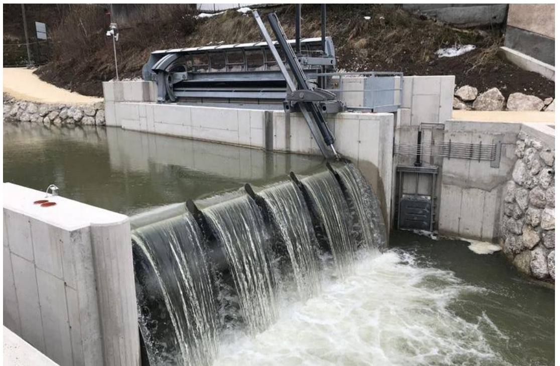
Obr. 8.43 Prepád vody ponad jednostranne zavesenú rúrovú klapku s hradiacou šírkou 7,2 m a hradiacou výškou 1,3 m na hati Windischgarsten, Rakúsko (Zdroj: wild-metal.com)
