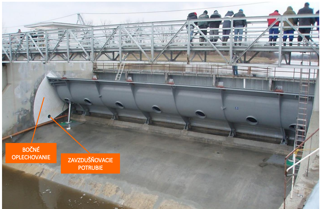
Obr. 8.58 Obojstranne podopretá klapka s hradiacou výškou 3 m a šírkou 22,5 m ovládaná hydraulickým piestom – hať České Vrbné na rieke Vltava, ČR, (Zdroj: ČVUT Praha, P. Valenta)
