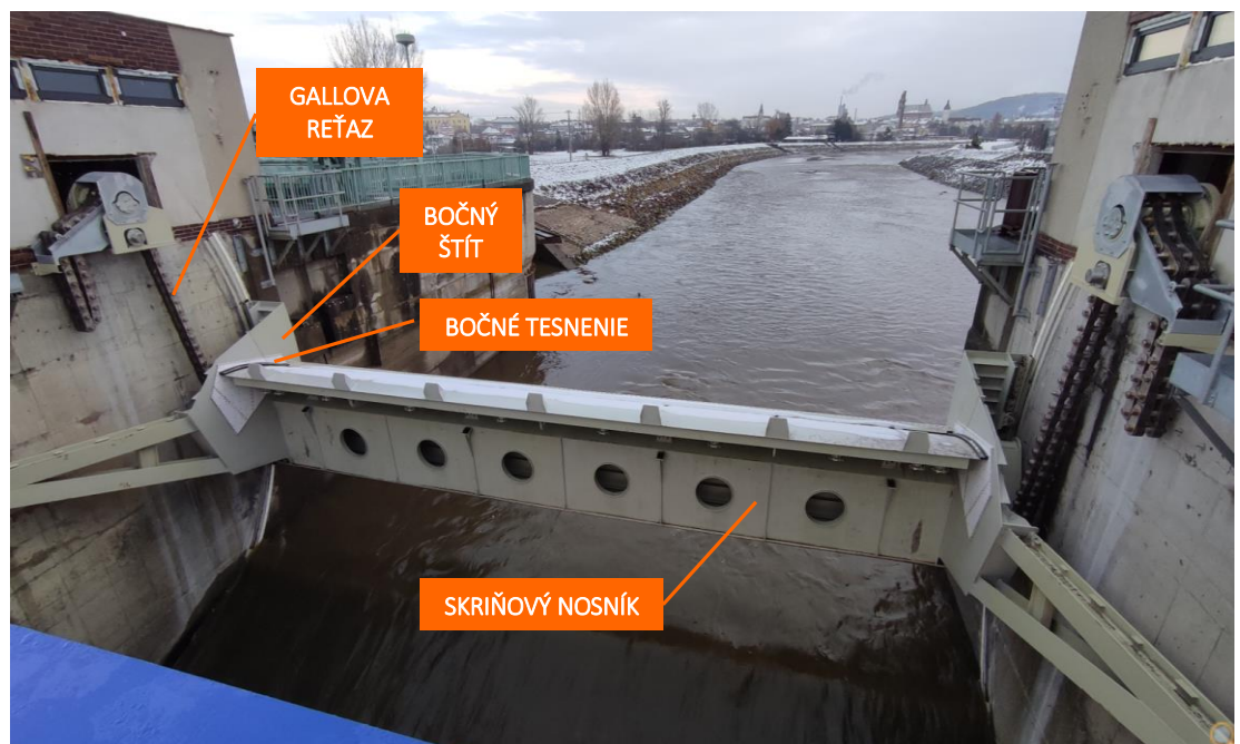
Obr. 8.88 Prepúšťanie prietoku pod obojstranne mechanicky ovládaným segmentom s nasadenou dutou klapkou s celkovou hradiacou výškou 3,2 m a šírkou 16 m na hati Hranice na Bečve, ČR (Zdroj: ČVUT Praha, © Petr Valenta)
