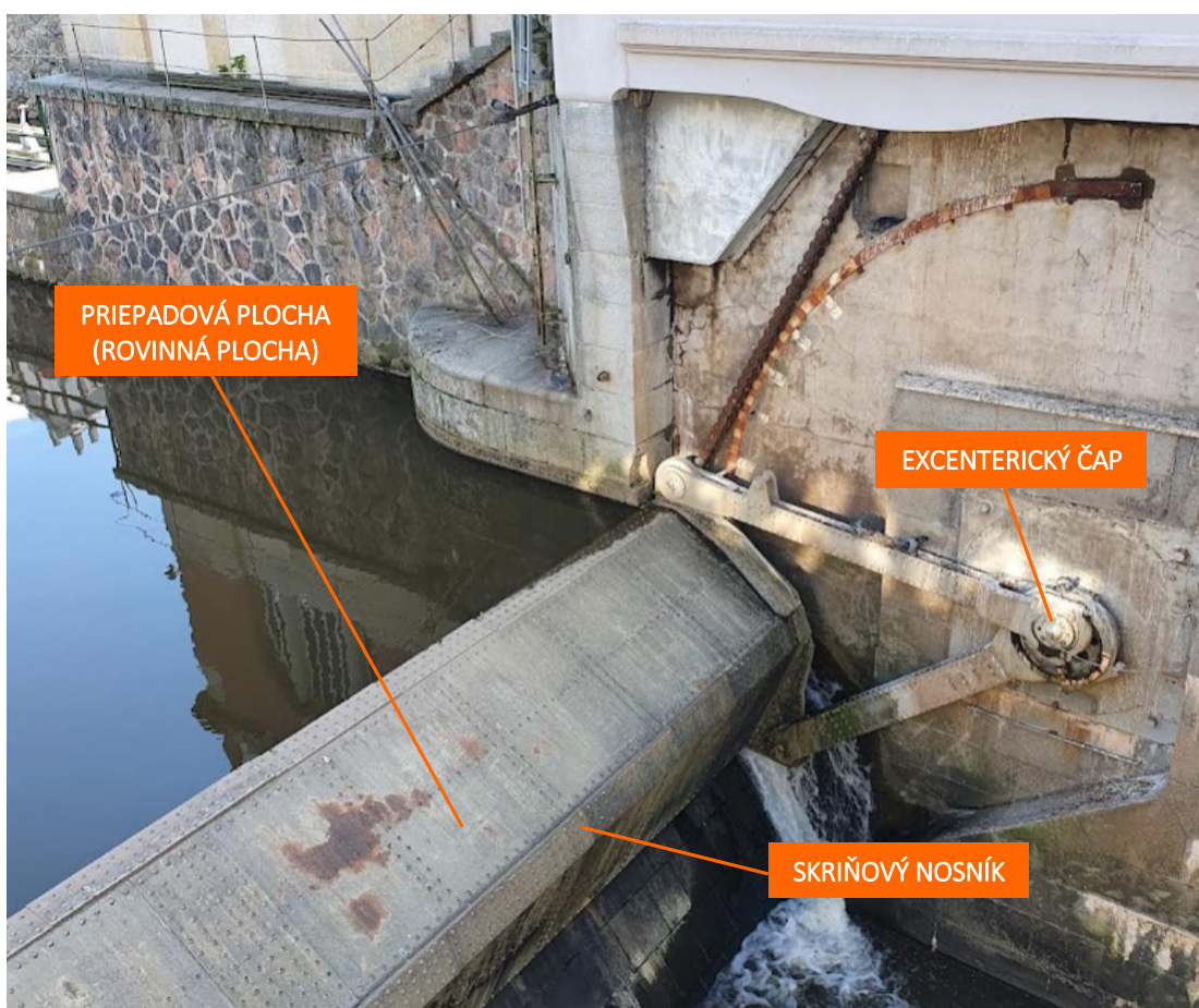
Obr. 8.82 Úplne spustný segment s tlačnými ramenami s hradiacou výškou 2,24 m a hradiacou šírkou 18,0 m – hať Labskej vodnej elektrárne v Hradci Králové na rieke Labe, ČR (Zdroj: google.com/maps, ©Lucyna Czajkowska)
