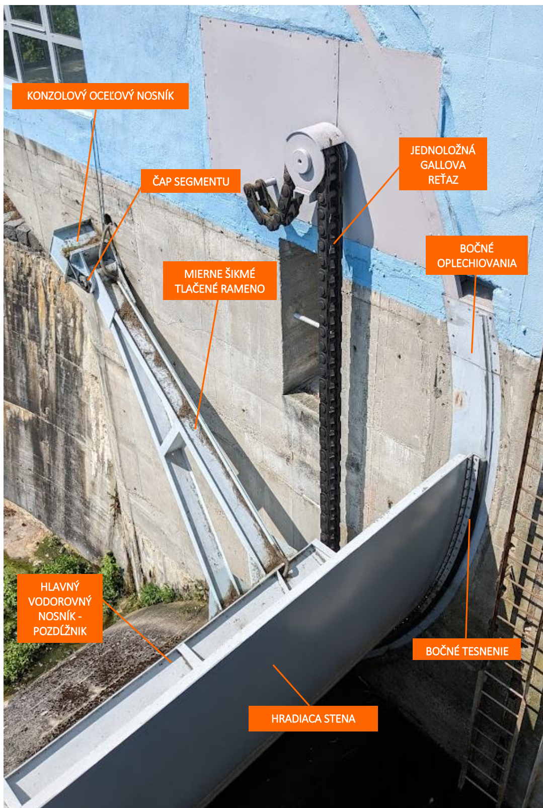
Obr. 8.65 Zdvížený segment s tlačnými ramenami – Vodné dielo Dalešice na rieke Jihlava, ČR (Zdroj: © MUDr. Tomáš Török)
