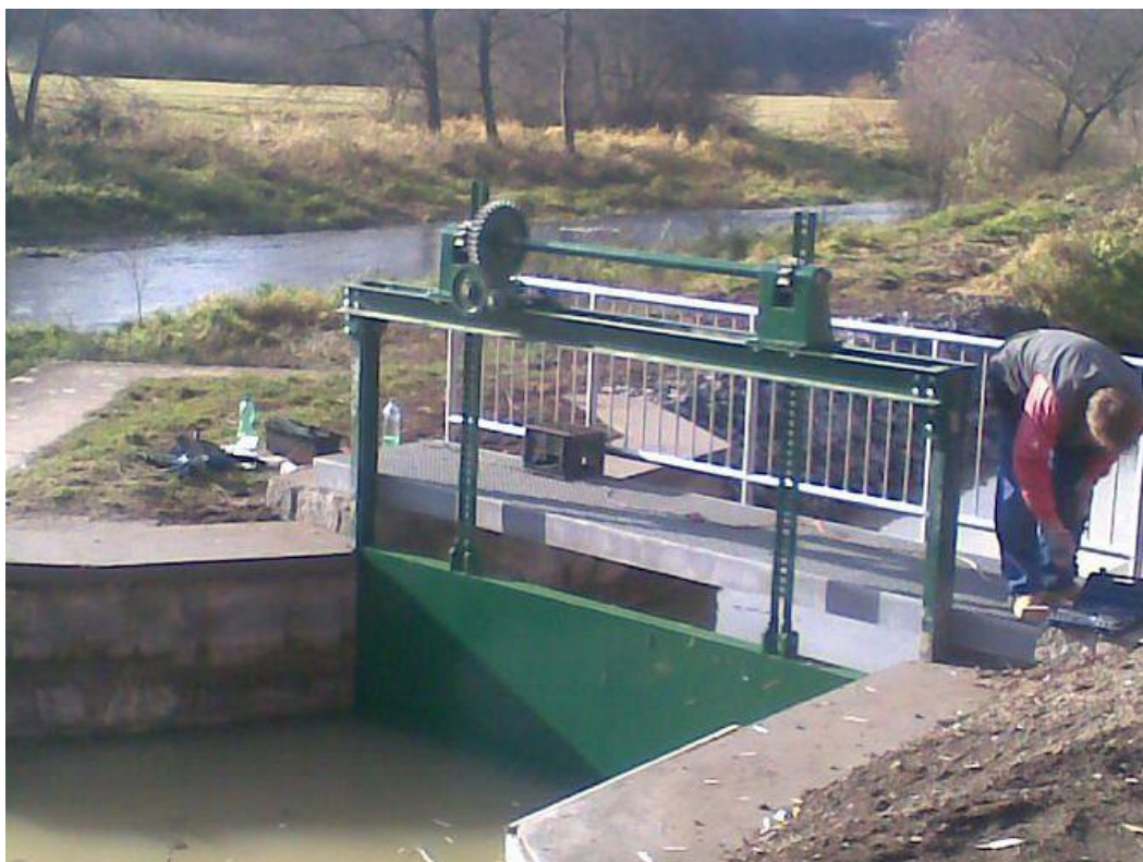
Obr. 8.13 Tabuľové (doskové) stavidlo s hradiacou tabuľou z oceleového plechu zavesenou na cievových tyčiach ovládaných pomocou ručného pohonu (Zdroj: fornax-sro.cz)
