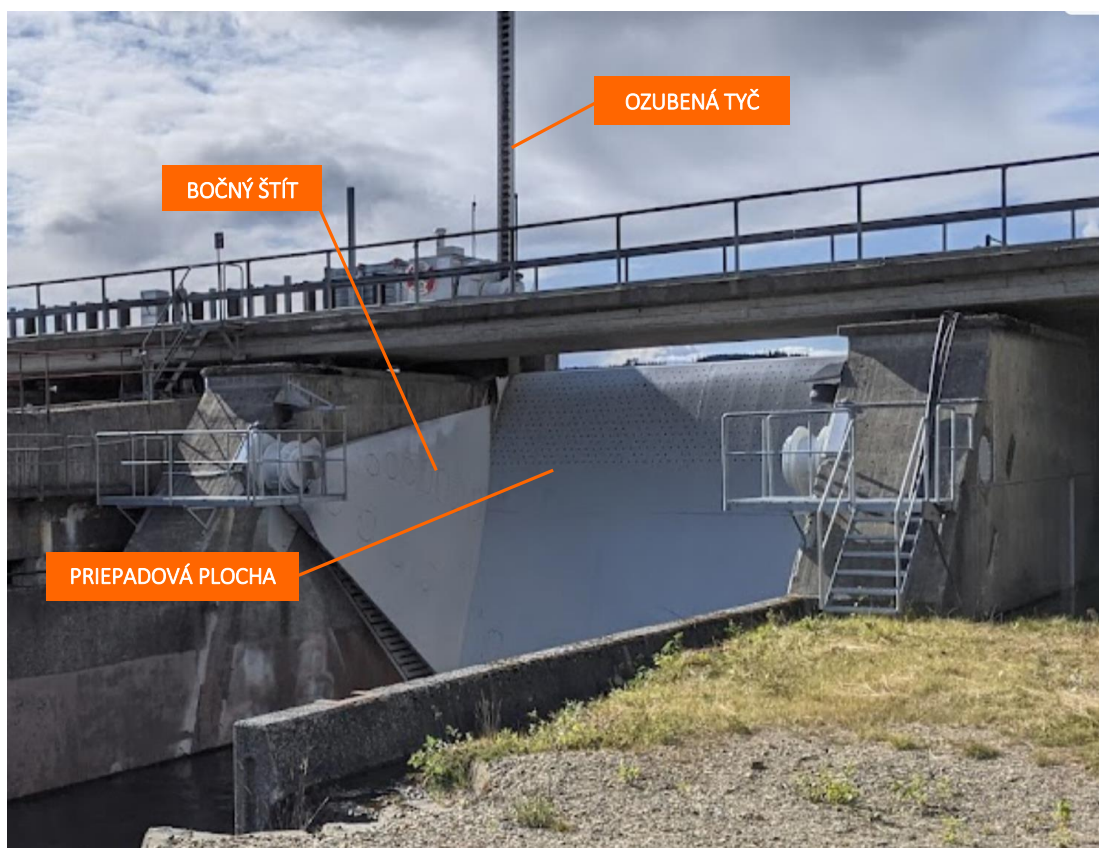
Obr. 8.83 Úplne spustný segment s tlačnými ramenami na Vodnom diele Bågede, Švédsko (Zdroj: google.com/maps, © Christoph Bauwers)
