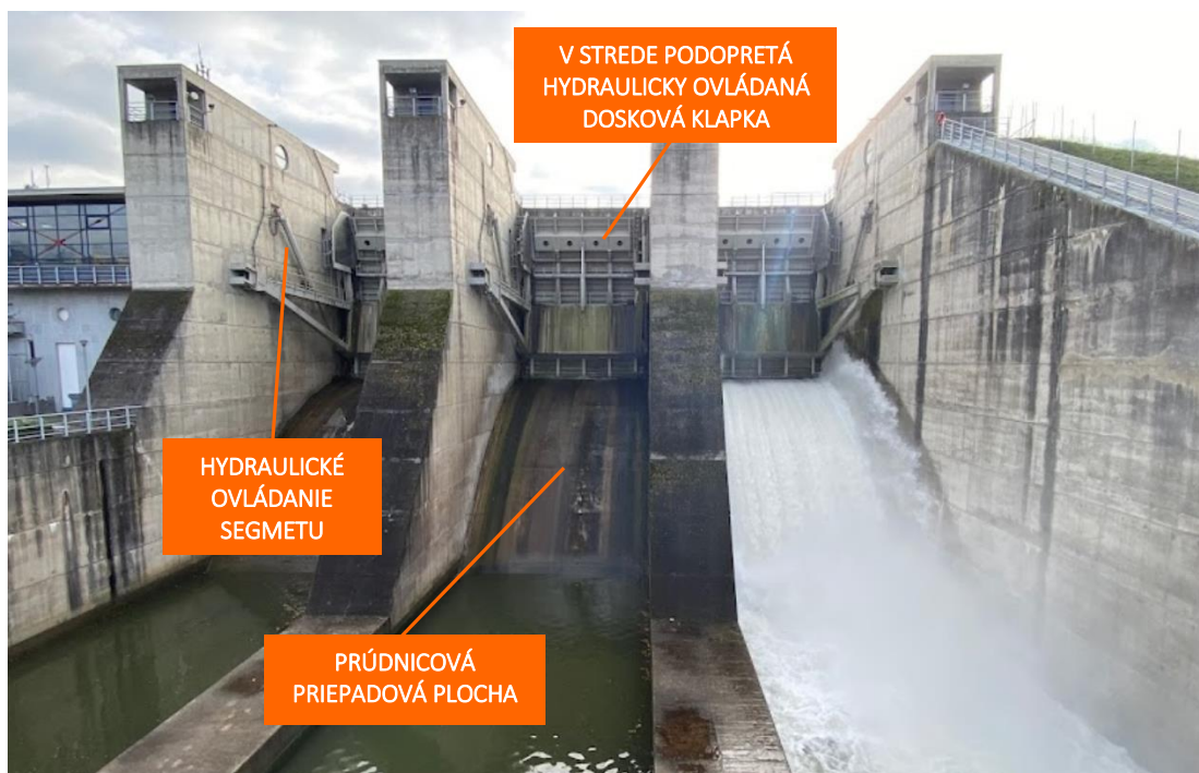
Obr. 8.90 Prepúšťanie prietoku výtokom pod segmentom s nasadenou doskovou klapkou s celkovou hradiacou výškou 14,7 m a hradiacou šírkou 12 m na hati Vodného diela Žilina na Váhu (Zdroj: google.com/maps, © Pavol Hruška)
