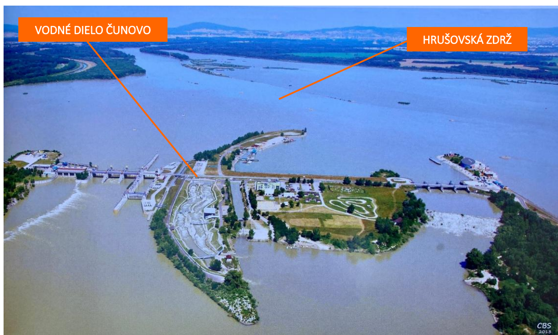
Obr. 2.33 Hrušovská zdrž vytvorená prehradením Dunaja Vodným dielom Čunovo (Zdroj: ©CBS)
