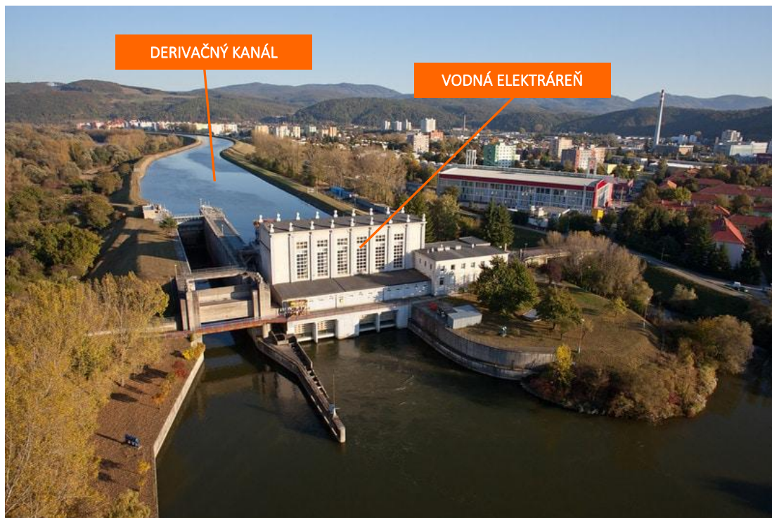
Obr. 5.18 Vodná elektrárň Trenčín – derivačná schéma beztlaková (Zdroj: seas.sk)
