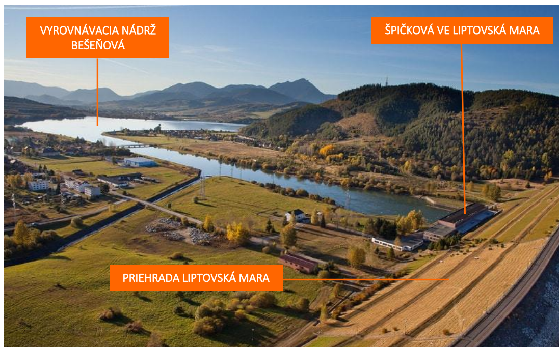
Obr. 2.28 Vyrovnávacia nádrž Bešeňová (Zdroj: seas.sk)
