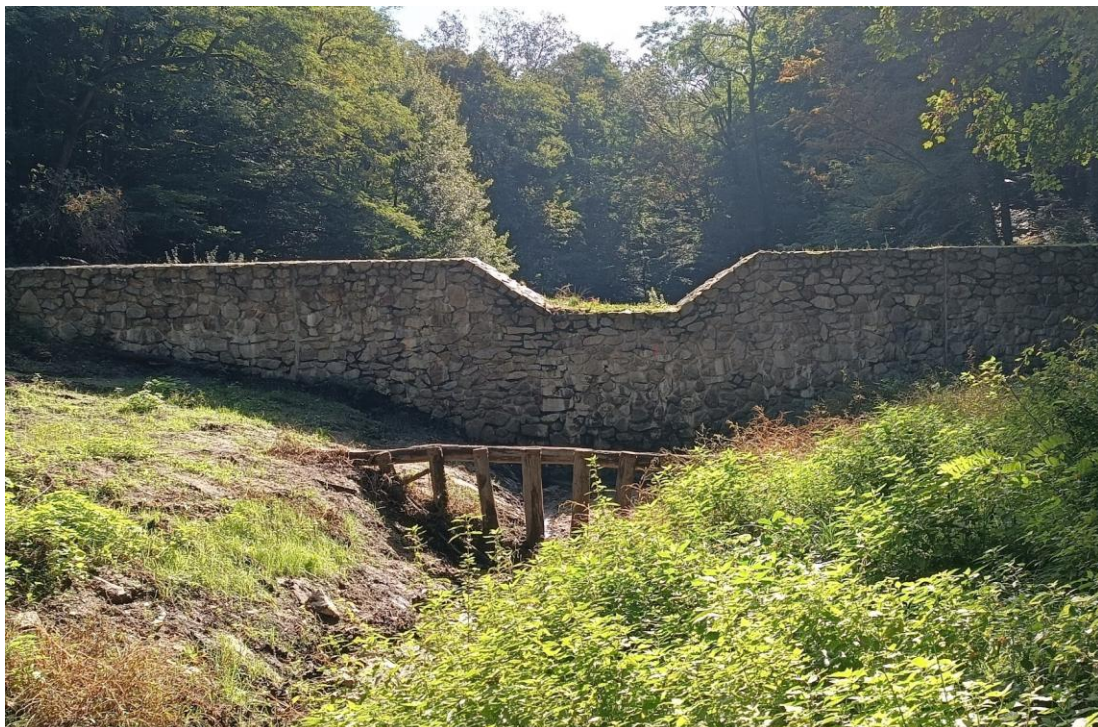
Obr. 3.12 Osadenie drevených zábran pred dnovým výpustom poldra na Banskom potoku, Rača, Bratislava – pohľad po prúde (Zdroj: archív autorov)
