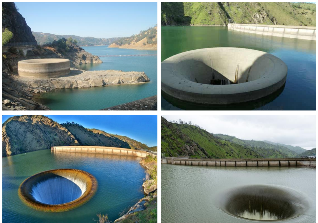
Obr. 2.60 Fázy zatopenia šachtového bezpečnostného priepadu, Berryessa, Kalifornia
