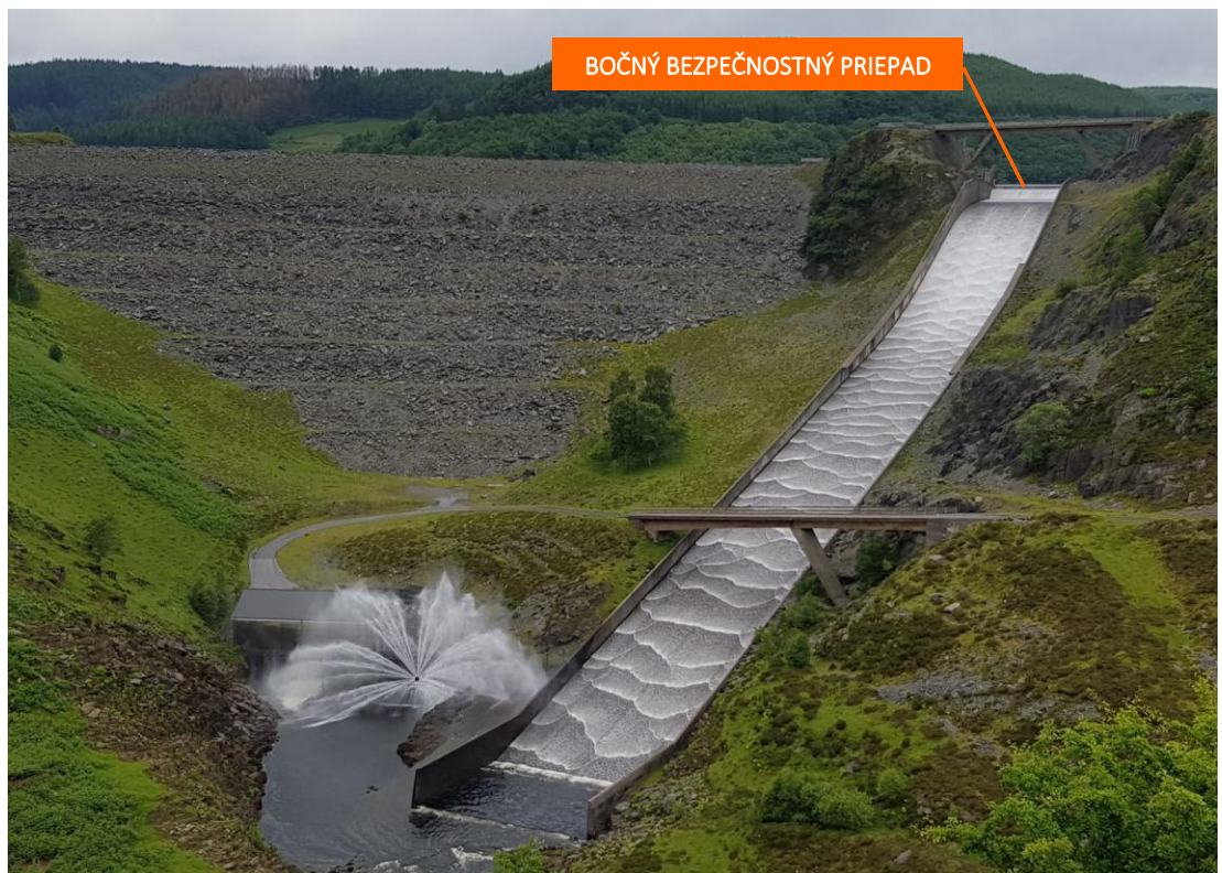
Obr. 2.57 Bočný bezpečnostný priepad priehrady Llyn Brianne, Wales (Zdroj: Wikimedia, ©J. Phillips)
