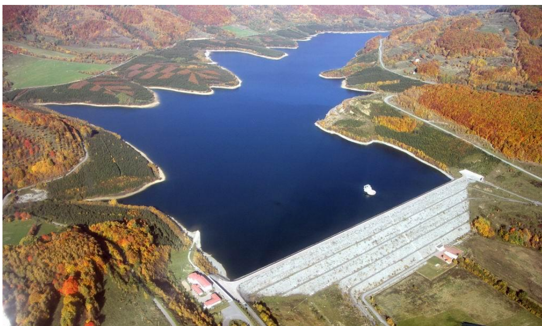
Obr. 2.45 Vodárenská nádrž Málinec (Zdroj: ©Slovenský vodohospodársky podnik)
