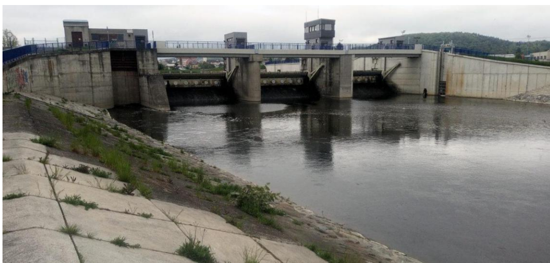
Obr. 4.49 Príklad opevnenia brehu betónovými doskami (Zdroj: rieky.sk, © Plameňák)
