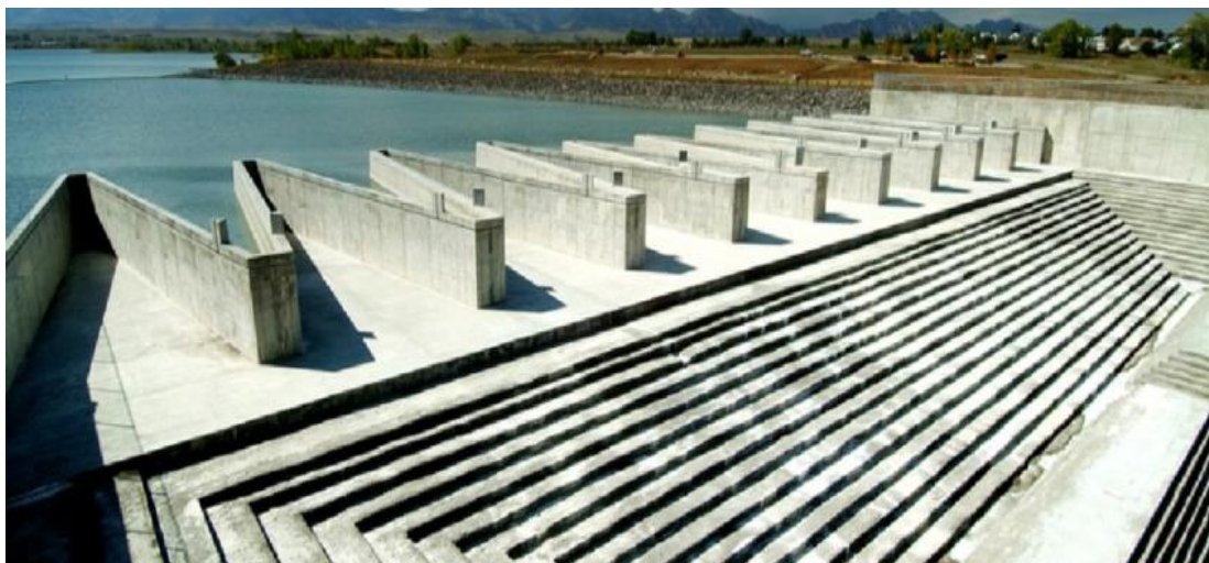
Obr. 4.19 Labyrintová hať Standley Lake, Westminster, Colorado, USA (Zdroj: researchgate.net, © K. Warren Frizell)
