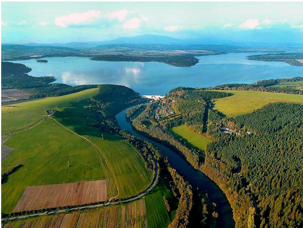
Obr. 2.18 Vodná nádrž Orava na rieke Biela Orava, SR (Zdroj: ustie-nad-oravou.webnode.sk , ©Pavel Bednarčík)
