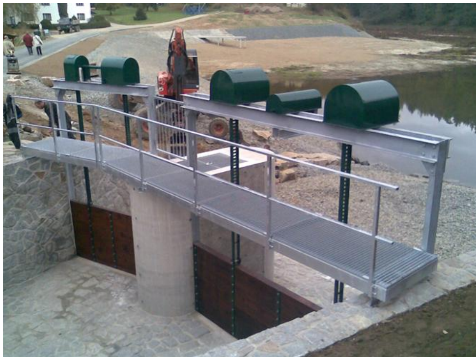
Obr. 4.28 Tabuľové (doskové) stavidlá s hradiacimi tabuľami z drevených dosák; zavesených na cievových tyčiach ovládaných elektromotorom (Zdroj: fornax-sro.cz)
