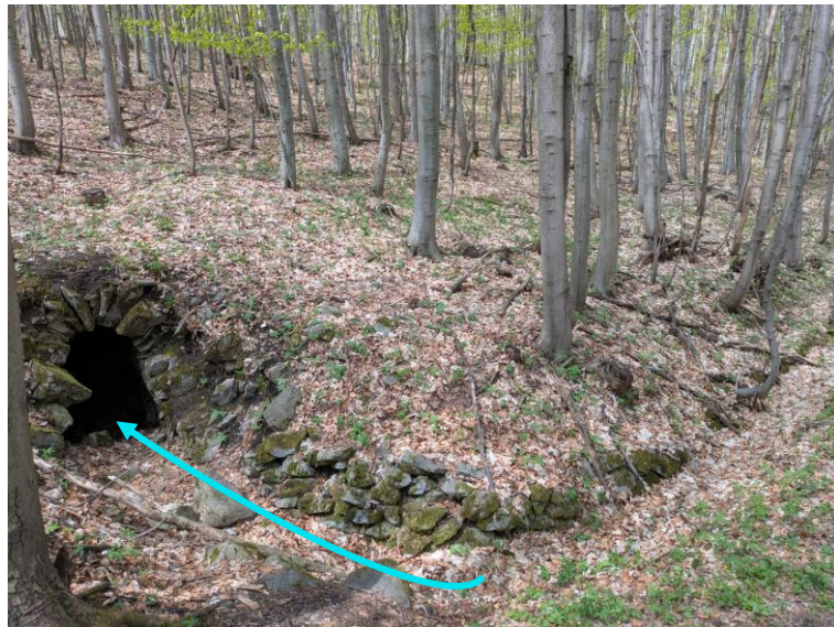
Obr. 5.15 Portál vodnej štôlne Tatárskeho zberného jarku (Zdroj: archív autorov)
