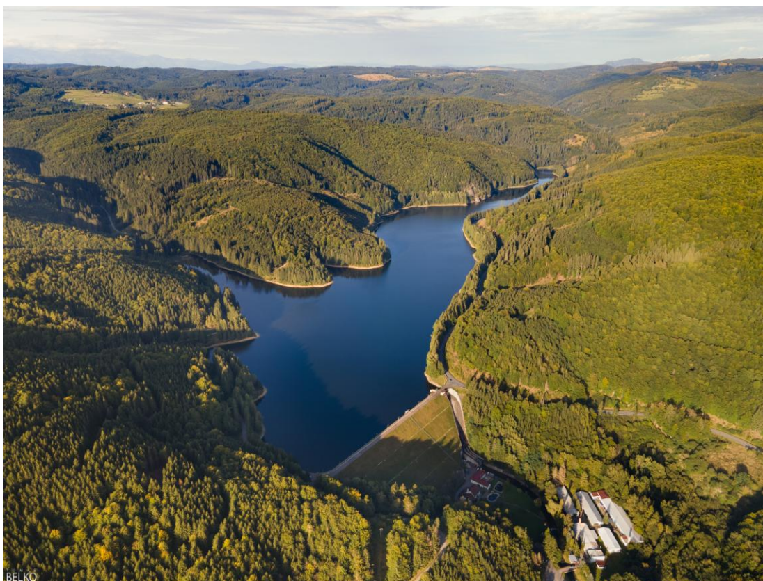
Obr. 2.46 Vodárenská nádrž Hriňová (Zdroj: ©Tomáš Belko )
