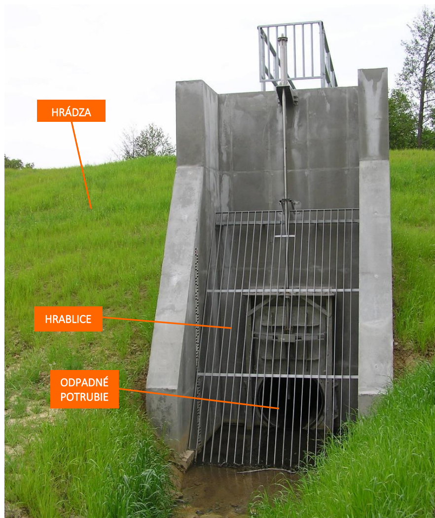
Obr. 3.11 Osadenie hrabíc pred dnovým výpustom suchého poldra na Litíčskom potoku, Trutnov, ČR (Zdroj: ČVUT)
