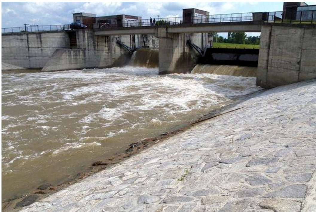
Obr. 4.48 Príklad opevnenia brehu kamennou dlažbou na cementovú maltu (Zdroj: rieky.sk)
