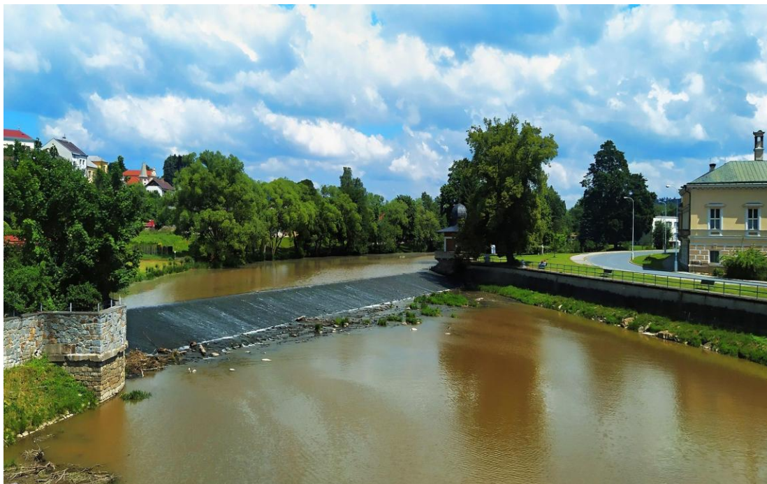
Obr. 4.25 Rekonštruovaná pevná hať Svetlá nad Sázavou, ČR (Foto: ©Jaroslav Kováč)
