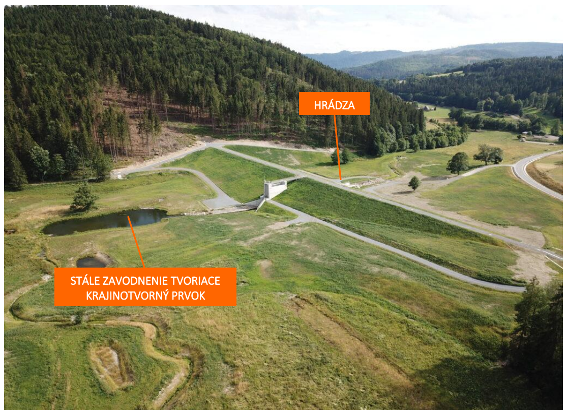
Obr. 3.19 Sypaná hrádza suchého poldra Jelení vysoká 16 m, Karlovice, ČR (Zdroj: pohl.cz)
