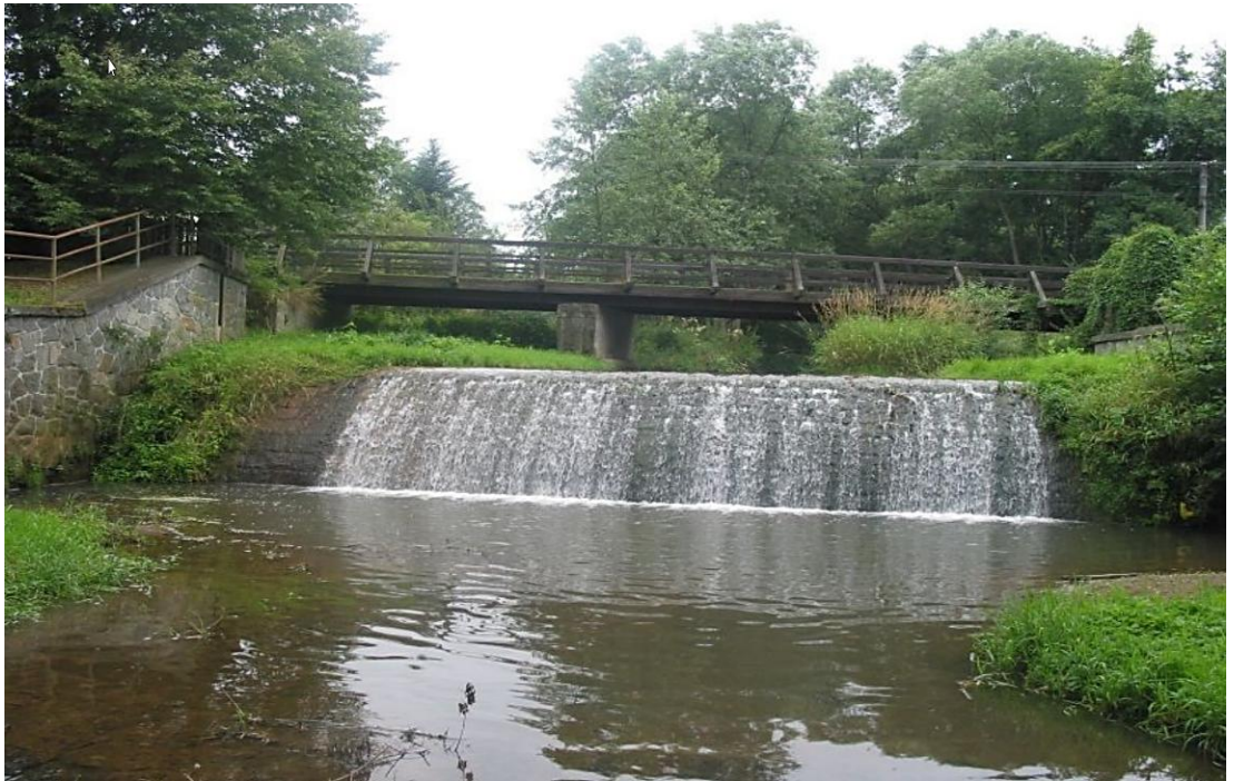
Obr. 4.40 Pevná hať s prúdnicovou priepadovou plochou (Zdroj: ČVUT Praha, © P. Valenta)
