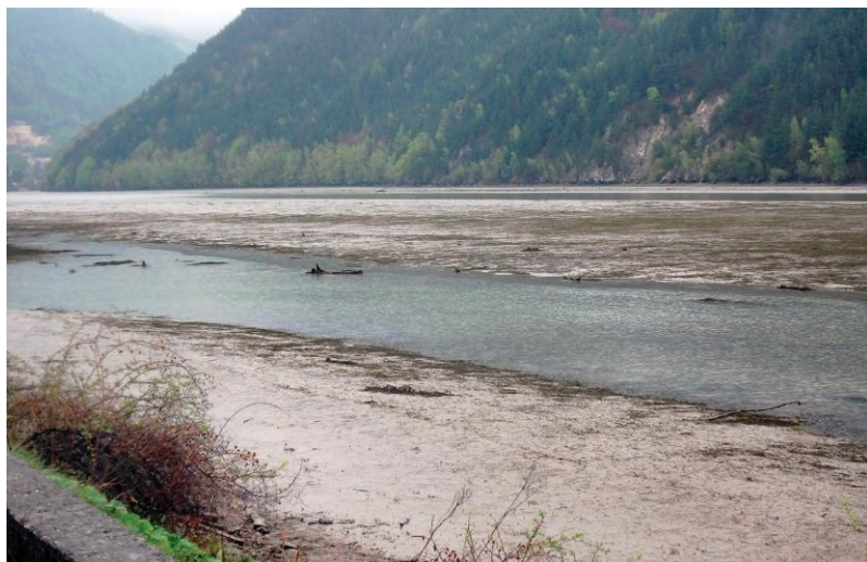
Obr. 4.10 Nánosy sedimentov v zdrži VD Krpelany (Zdroj: slovenskyrybar.sk/)
