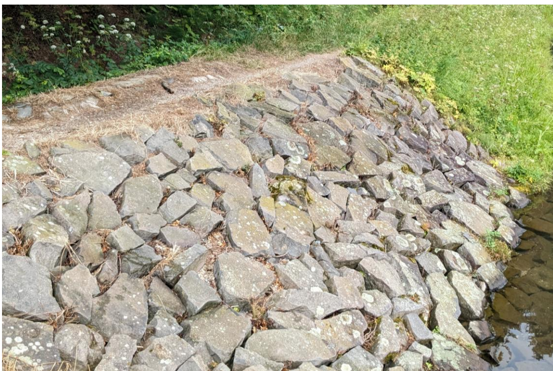
Obr. 4.47 Príklad opevnenia brehu jednoduchou kamennou dlažbou (Zdroj: archív autorov)
