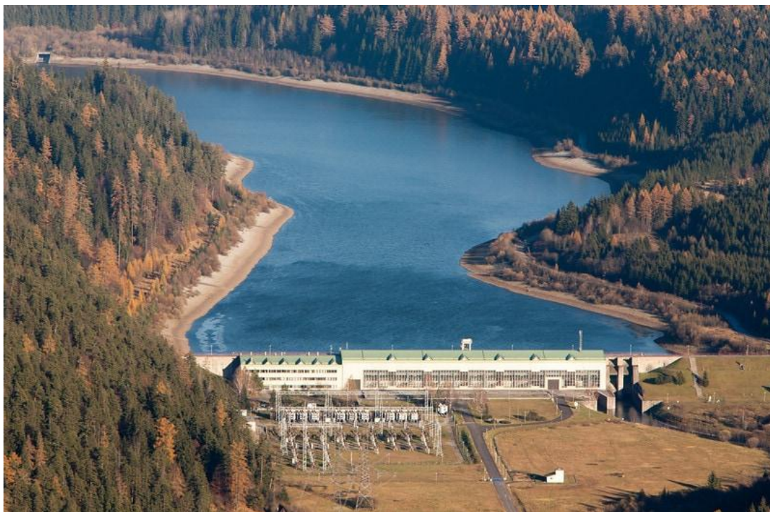
Obr. 2.38 Dolná nádrž PVE Čierny Váh (Zdroj: ©Slovenské elektrárne)
