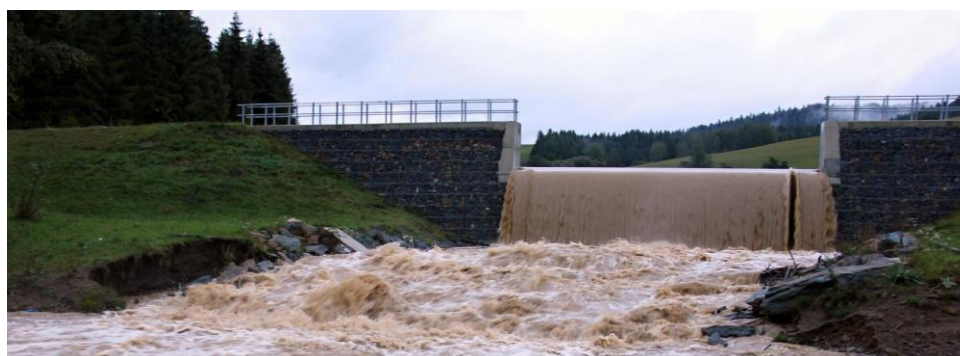
Obr. 3.4 Polder Ľubica – prepúšťanie povodňového prietoku cez bezpečnostný priepad (Zdroj: © M. Kruk)
