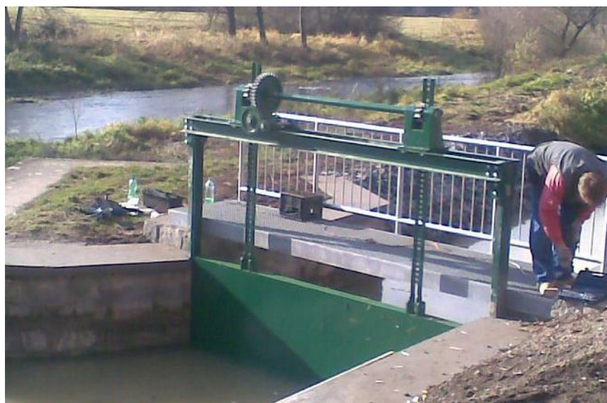
Obr. 4.29 Tabuľové (doskové) stavidlo s hradiacou tabuľou z oceleového plechu zavesenou na cievových tyčiach ovládaných pomocou ručného pohonu (Zdroj: fornax-sro.cz)
