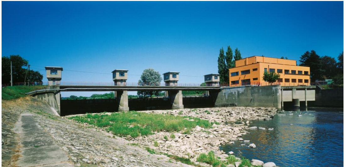
Obr. 4.44 Opevnenie dna koryta za prahom vývaru kamennou zahádzkou na hati Spytihněv na rieke Morava, ČR (Zdroj: cez.cz)
