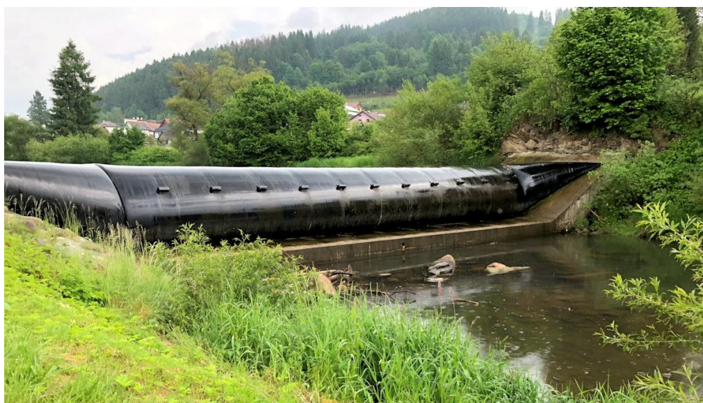
Obr. 4.37 Vakový uzáver prikotvený k spodnej stavbe a k šikmým brehovým pilierom s hradiacou výškou 3,0 m a šírkou 25,0 m – hať Filipovo na rieke Hron (Zdroj: rieky.sk, © Matej Mikluš)
