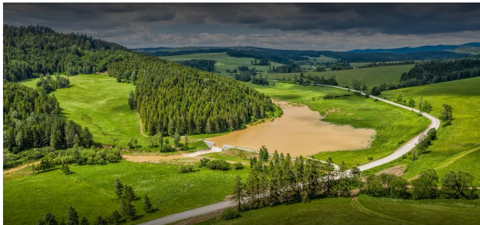
Obr. 3.3 Polder Ľubica – plnenie retenčného priestoru počas povodne (Zdroj: archív autorov)
