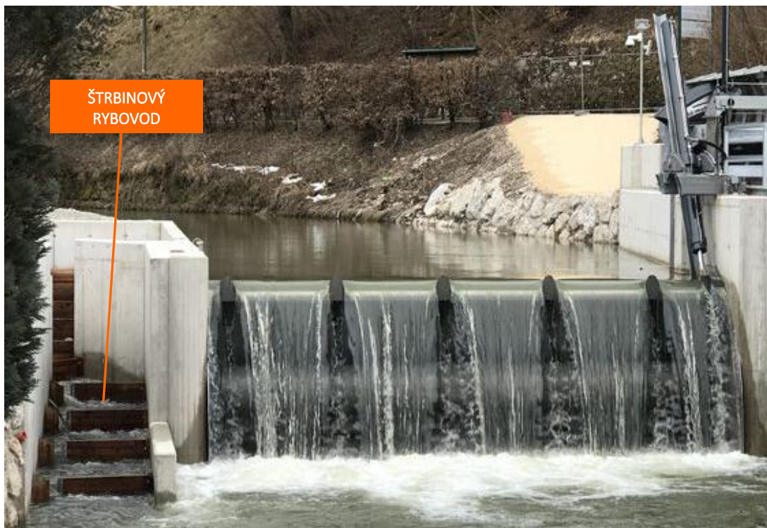
Obr. 4.14 Pohyblivá hať Windischgarsten s vnútrokorytovým štrbinovým rybovodom, Rakúsko (Zdroj: wild-metal.com)
