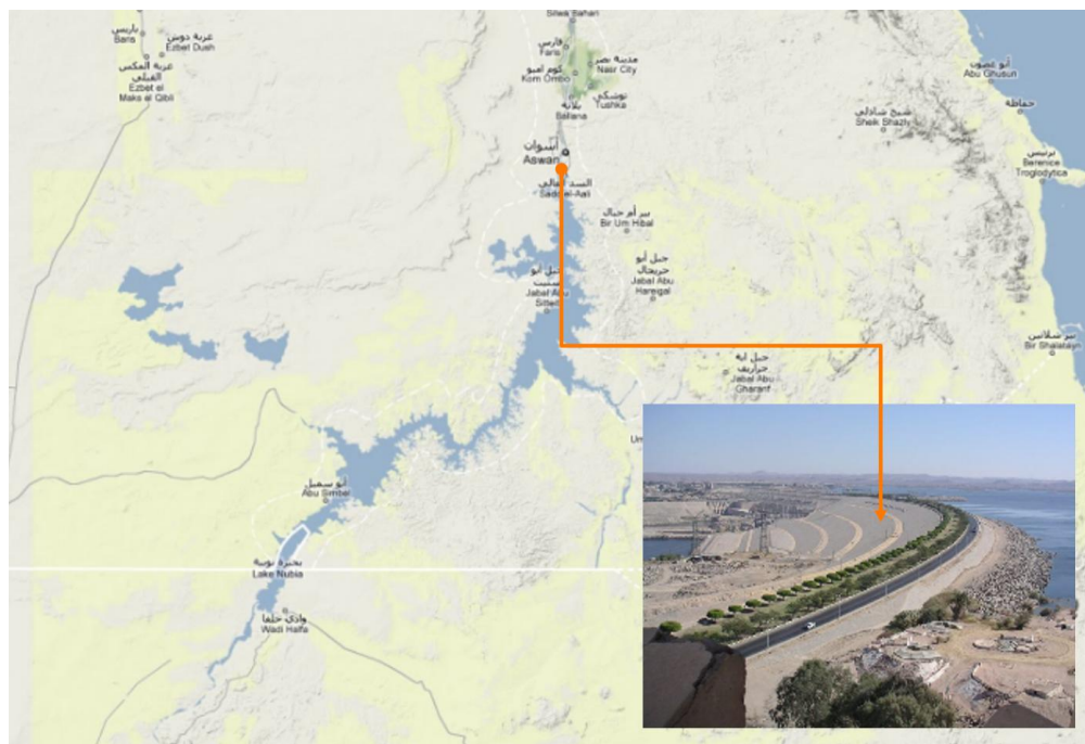
Obr. 2.14 Nádrž Nasser, Egypt (Zdroj: Google Maps)
