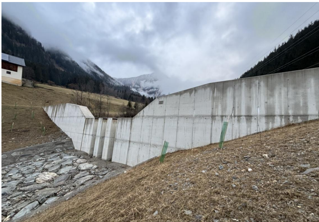
Obr. 3.17 Tzv. Alpský typ suchého poldra – pohľad proti prúdu, Rakúsko (Zdroj: ©Adam Mikulaj)
