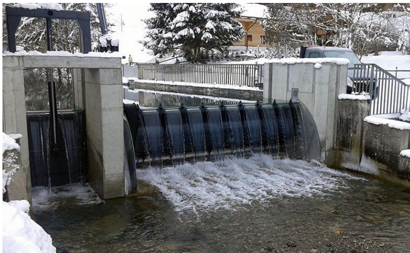
Obr. 4.32 Prepad vody ponad jednostranne dutú klapku s hradiacou šírkou 6 m a hradiacou výškou 1,4 m na hati Gsteig, Švajčiarsko (Zdroj: wild-metal.com)
