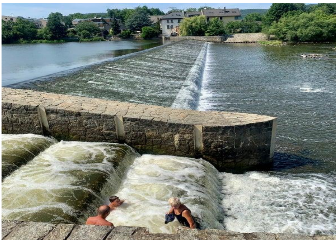
Obr. 4.26 Pevná hať Dobřichovice na rieke Berounka, ČR (Zdroj: foursquare.co, © Progressor)
