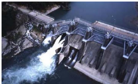
Obr. 6.20 Havária hate Shih-Kang (Thajsko) spôsobená prelomením podložia (Zdroj: ntuce-newsletter.tw) Havária hate Shih-Kang (Thajsko) spôsobená prelomením podložia
