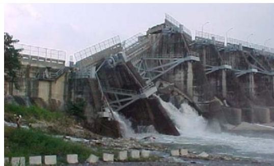
Obr. 6.20 Havária hate Shih-Kang (Thajsko) spôsobená prelomením podložia (Zdroj: ntuce-newsletter.tw) Havária hate Shih-Kang (Thajsko) spôsobená prelomením podložia
