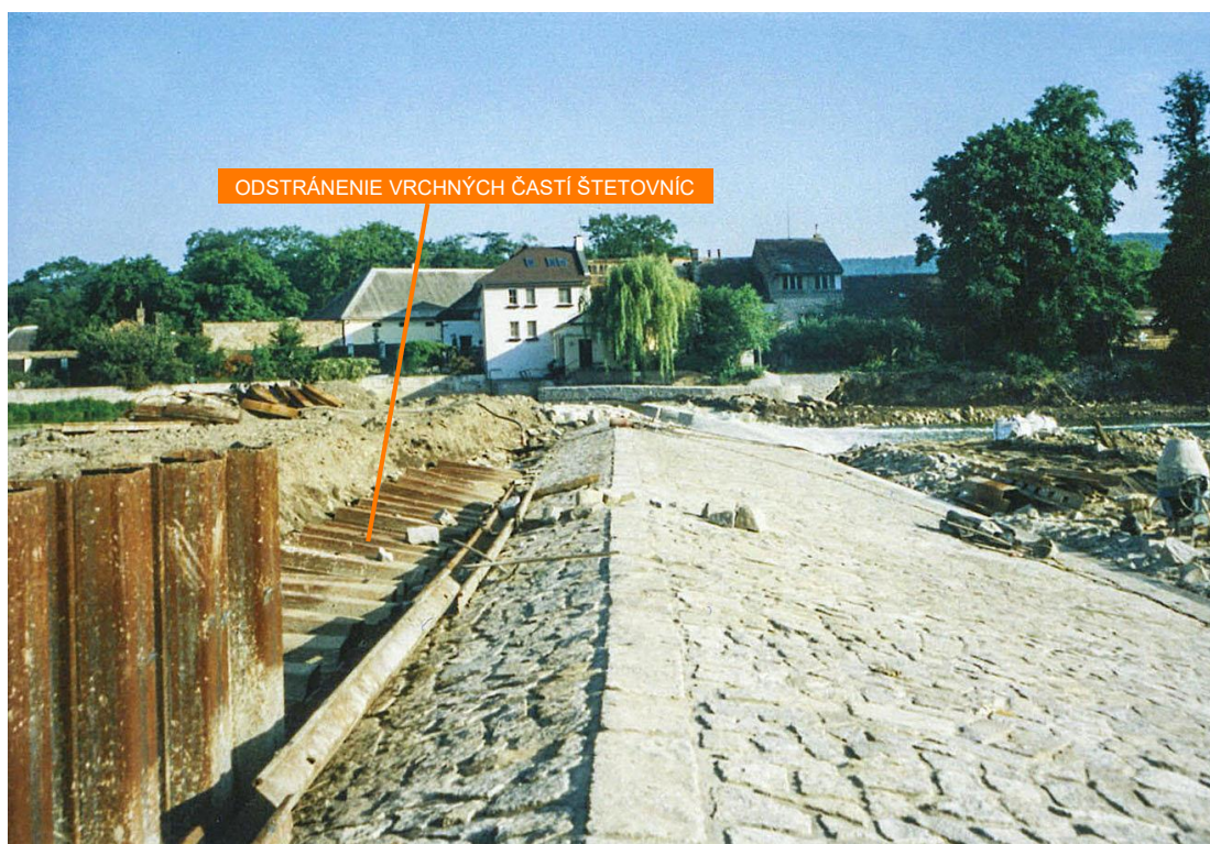
Obr. 10.10 Etapová výstavba pevnej hate Dobřichovice na Berounke, ČR v stavebnej jame ohrádzovanej štetovnicovými stenami (Zdroj: zakladani.cz)
