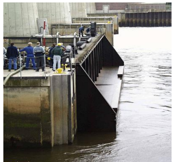
Obr. 9.8 Fázy priplavovania celistvého provizórneho hradenia opretého o ústupky v pilieri
