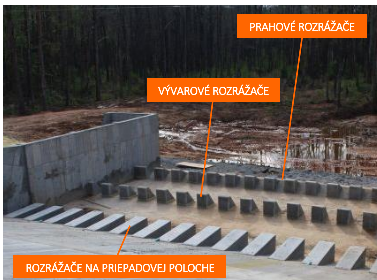
Obr. 4.31 Realizácia rozrážачov, Texas, USA (Zdroj: cadpanacea.com)
