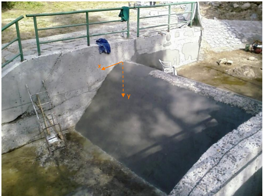
Obr. 4.6 Sanácie prúdnicovej priepadovej plochy v roku 2008 na pevnej hati Šindelová, ČR (Zdroj: ČVUT Praha, © Petr Valenta)
