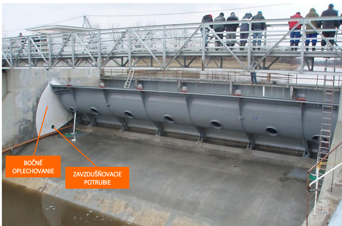
Obr. 8.58 Obojstranne podopretá klapka s hradiacou výškou 3 m a šírkou 22,5 m ovládaná hydraulickým piestom – hať České Vrbné na rieke Vltava, ČR, (Zdroj: ČVUT Praha, P. Valenta)
