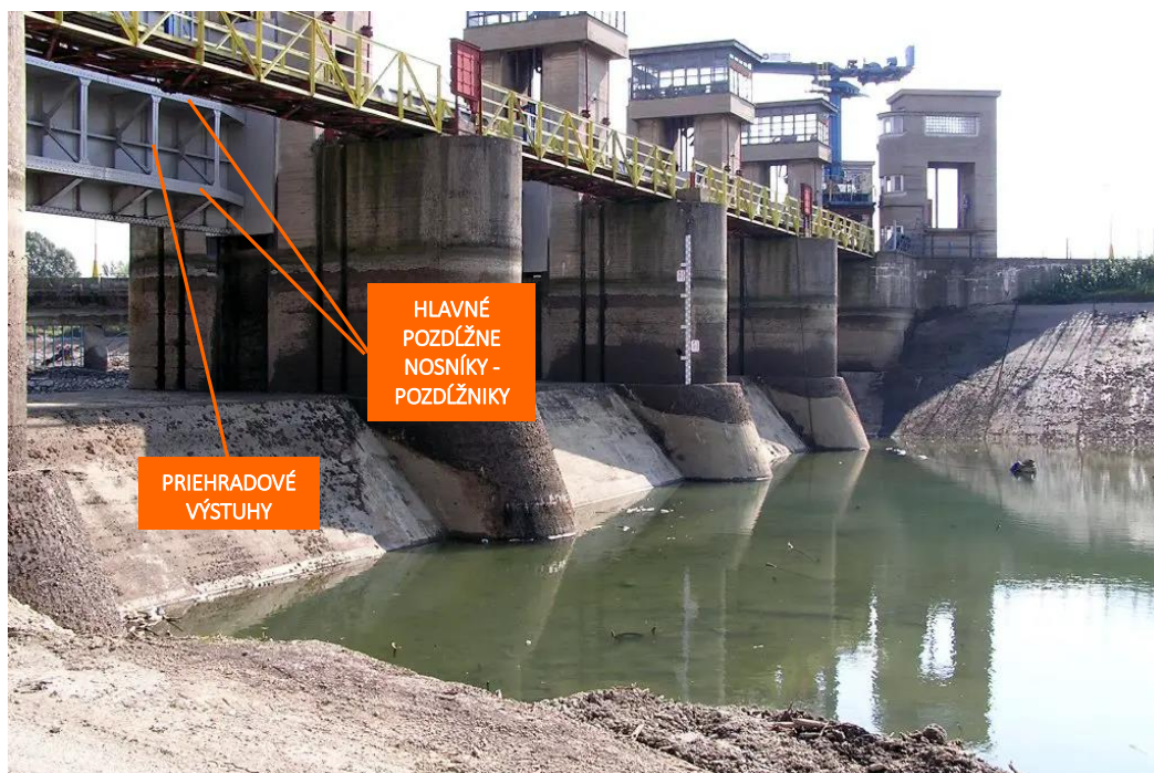
Obr. 8.8 Stavidlový uzáver s dvoma hlavnými pozdĺžnymi nosníkmi s piehradovým vystužením – regulačný objekt Trenčianske Biskupice na Váhu (Zdroj: mapio.net, © Petr Havlík)
