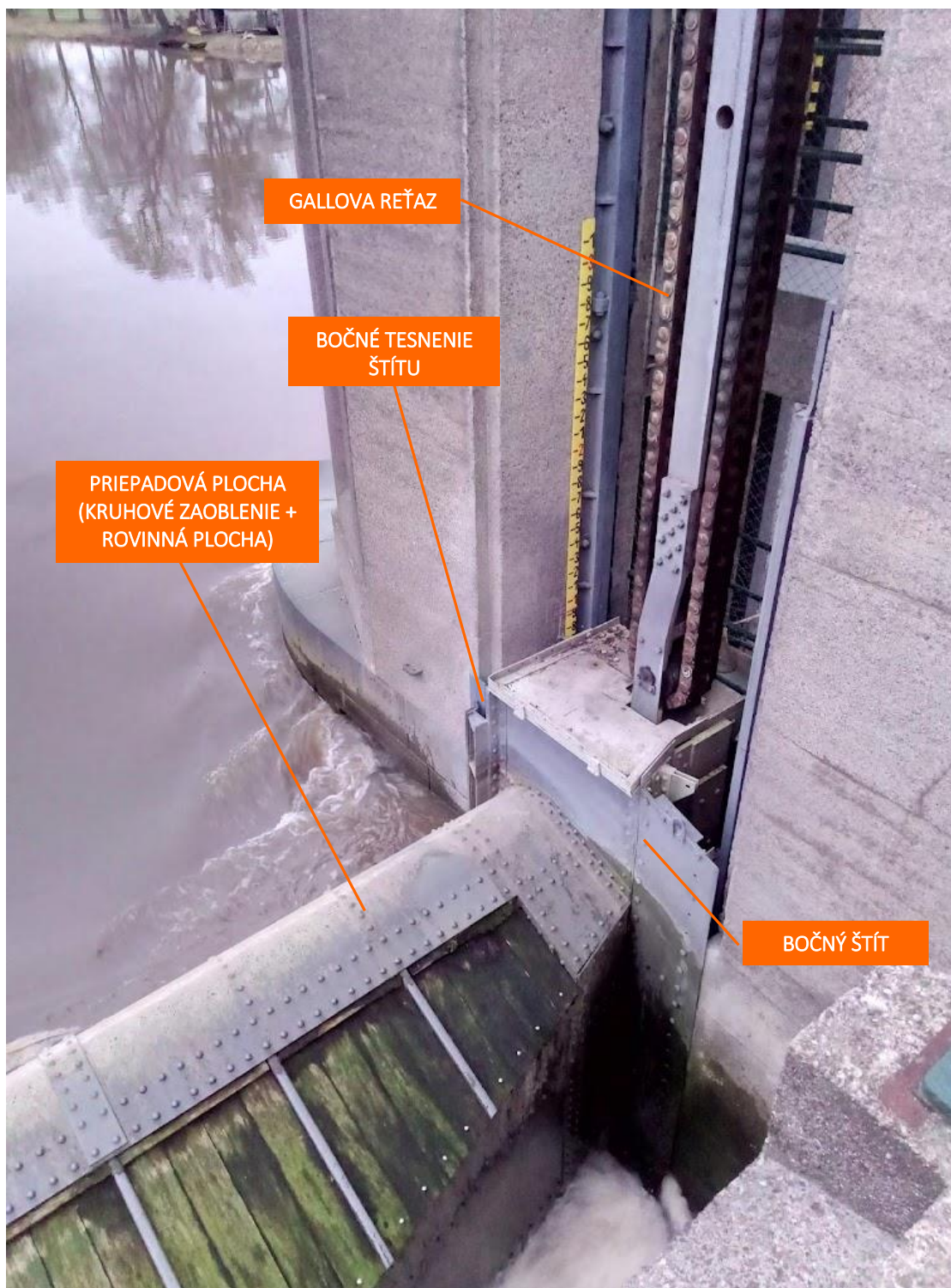
Obr. 8.23 Spustné stavidlo s hradiacou výškou 2,91 m na hati Poděbrady na Labe, ČR (Zdroj: © Josef Janíček)
