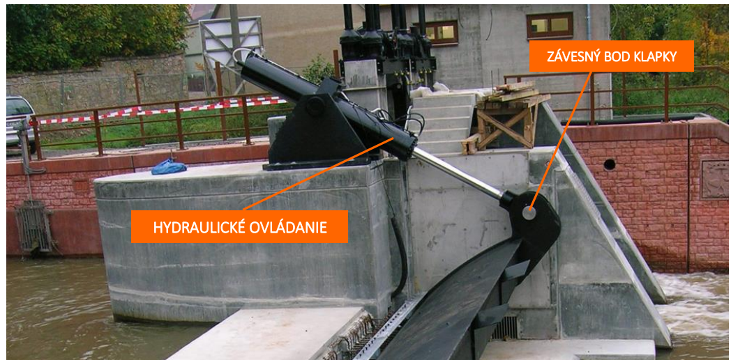
Obr. 8.56 Zavesená klapka zasunutá spolu s ovládaním do ústupku v pilieri (Zdroj: zs-zyylinder.de)
