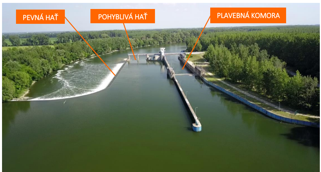
Obr. 3. 17 Vodné dielo Selice na rieke Váh (Zdroj: trnovecnadvahom.sk)
