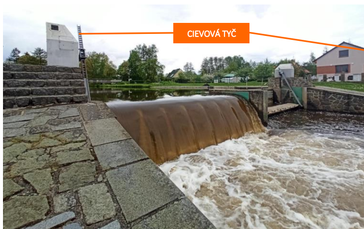
Obr. 8.51 Hať Vodňany na rieke Blanice, ČR (Zdroj: jcted.cz)
