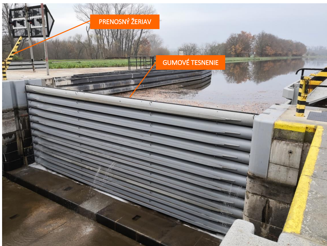
Obr. 9.4 Kovové (oceľové) priplavované hradidlové provizórne hradenie (Zdroj: rvccr.cz)
