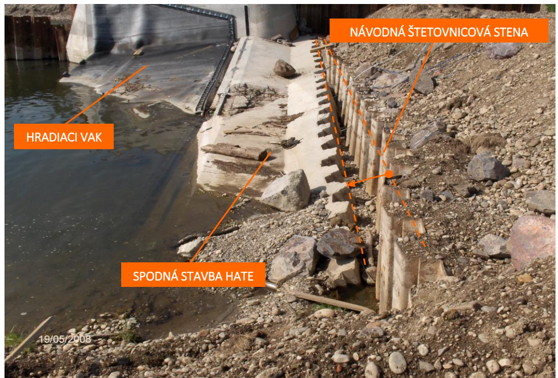
Obr. 5.30 Havária hate Šárovce na Hrone spôsobená prelomením podložia (Zdroj: archív autora)
