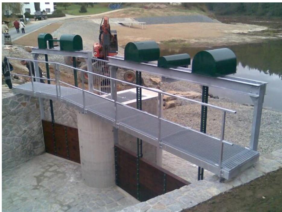
Obr. 8.12 Tabuľové (doskové) stavidlá s hradiacimi tabuľami z drevených dosák; zavesených na cievových tyčiach ovládaných elektromotorom (Zdroj: fornax-sro.cz)
