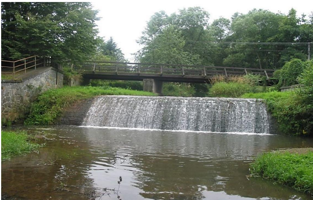
Obr. 5.2 Pevná hať s prúdnicovou priepadovou plochou (Zdroj: ČVUT Praha, © P. Valenta)
