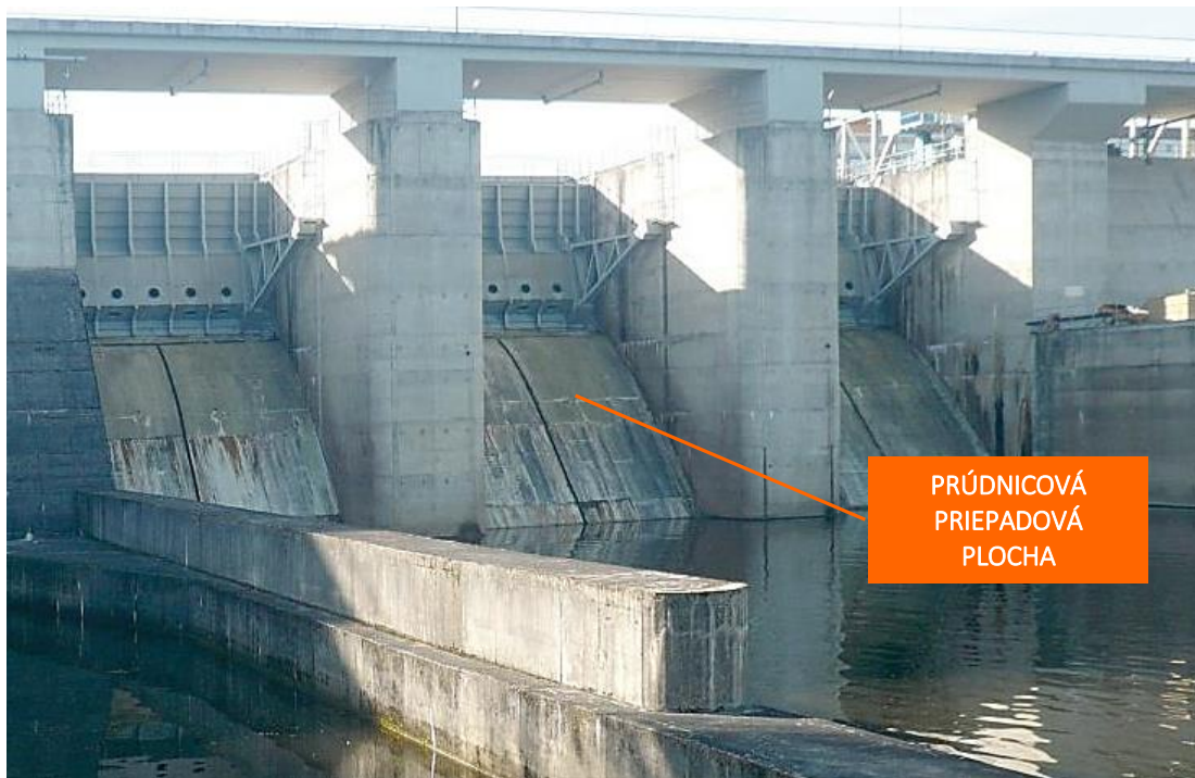
Obr. 5.11 Vodné dielo Hněvkovice na Vltave (ČR): vysoký stupeň s prúdnicovou priepadovou plochou za segmentovým uzáverom (Zdroj: konstrukce.cz)
