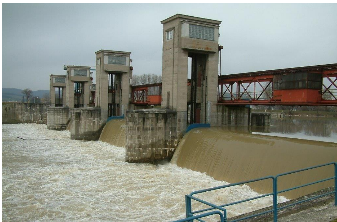
Obr. 8.31 Prepúšťanie prietoku cez klapky nasadená na stavidlách hate Trenčianske Biskupice na rieke Váh (Zdroj: mapion.net ©Marián Hubinský)
