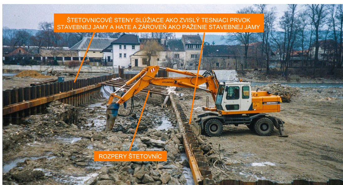
Obr. 10.8 Hĺbenie stavebnej jamy ohrádzovanej štetovnicovými stenami – etapová výstavba pevnej hate Dobřichovice na rieku Berounka, ČR (Zdroj: zakladani.cz)
