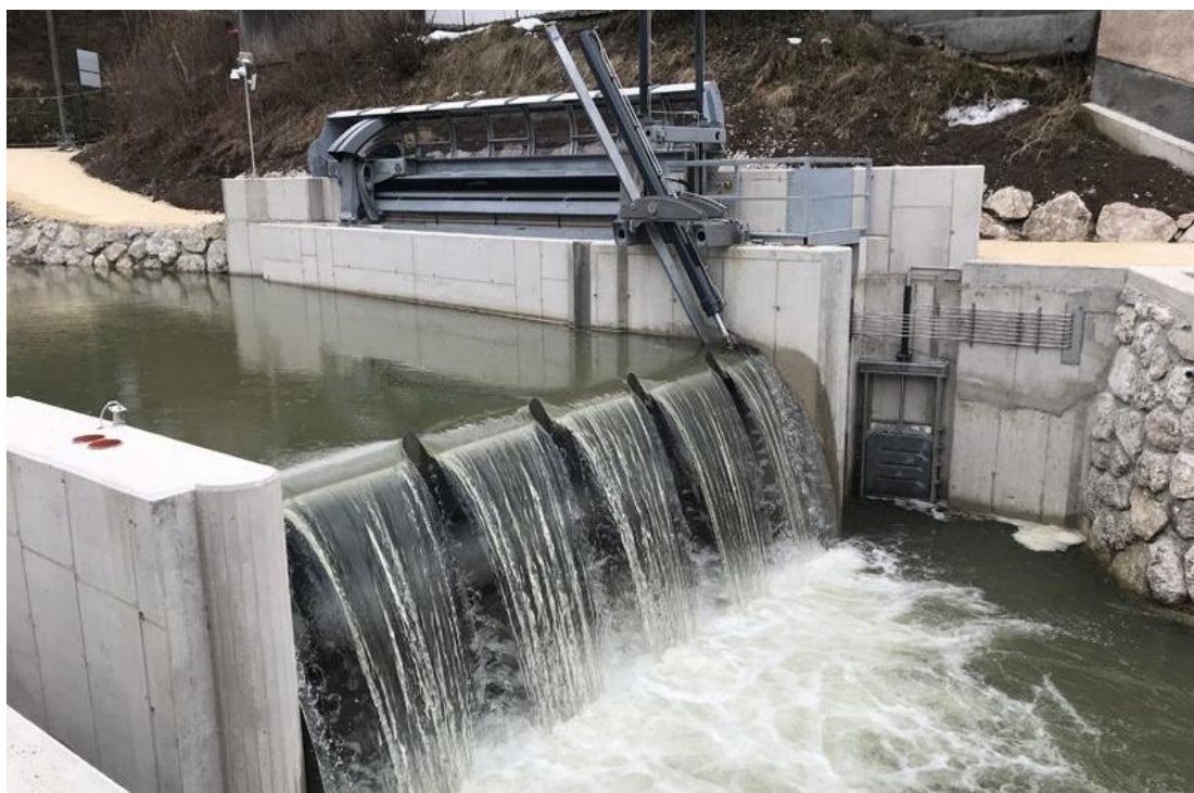
Obr. 8.43 Prepád vody ponad jednostranne zavesenú rúrovú klapku s hradiacou šírkou 7,2 m a hradiacou výškou 1,3 m na hati Windischgarsten, Rakúsko (Zdroj: wild-metal.com)
