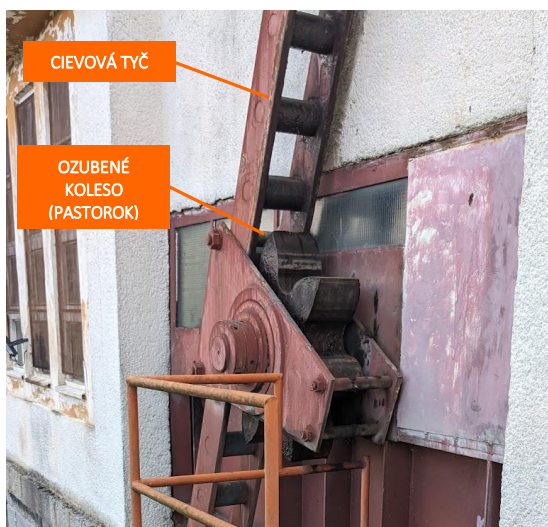
Obr. 8.53 Ovládanie dutej klapky na hati Piešťany na Váhu, (Zdroj: archív autora)
