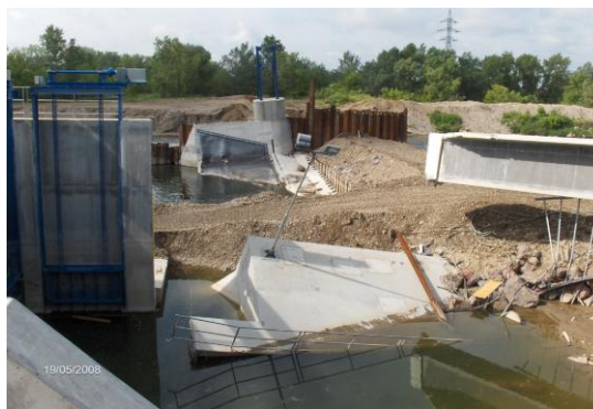
Obr. 6.21 Havária hate Šárovce na rieke Hron spôsobená prelomením podložia (Zdroj: SvF STU Bratislava, © Jozef Hulla)
