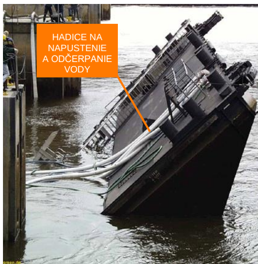
Obr. 9.8 Fázy priplavovania celistvého provizórneho hradenia opretého o ústupky v pilieri
