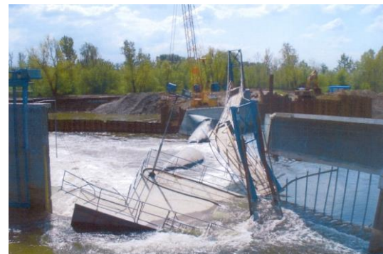
Obr. 6.20 Havária hate Shih-Kang (Thajsko) spôsobená prelomením podložia (Zdroj: ntuce-newsletter.tw) Havária hate Shih-Kang (Thajsko) spôsobená prelomením podložia
