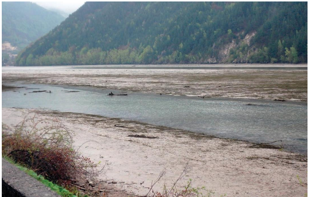
Obr. 3.15 Nánosy sedimentov v zdrži VD Krpeľany (Zdroj: slovenskyyrbar.sk/)
