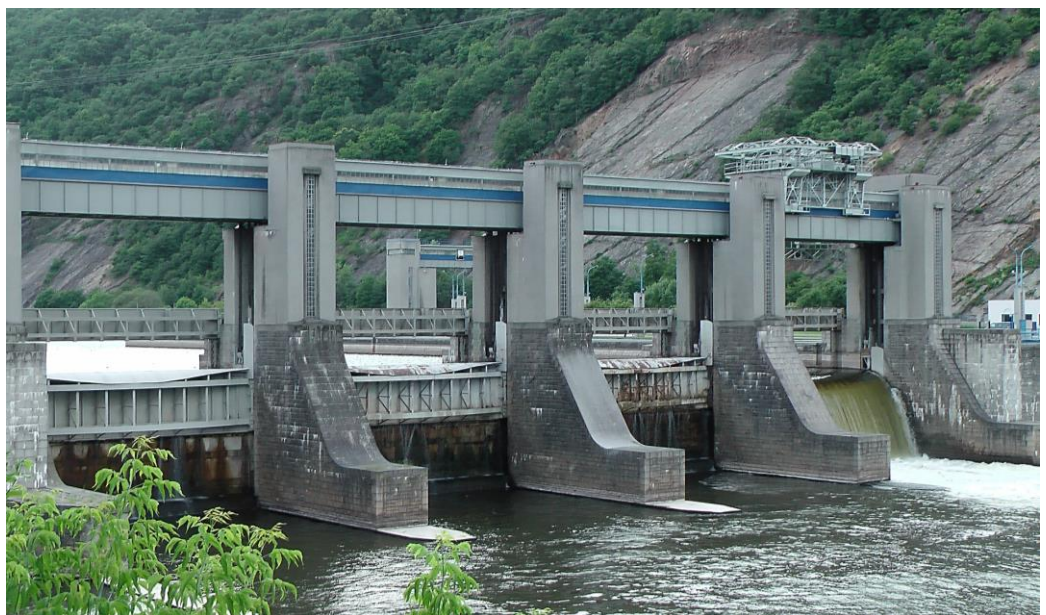
Obr. 8.34 Prepúšťanie prietoku ponad horné stavidlo dvojitého stavidla s hradiacou výškou 9,4 m krajným poľom hate na Vodnom diele Vrané nad Vltavou, ČR (Zdroj: cez.cz)
