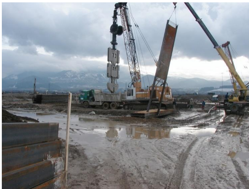
Obr. 5.39 Výstavba podzemnej tesniacej steny vyplnením ryhy vyhlúbenej rýpadlom (Zdroj: solhydro.sk)
