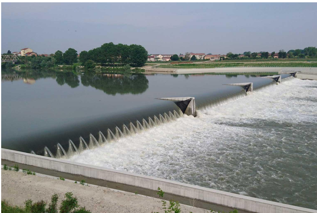
Obr. 8.101 Prepad vody cez vakový uzáver s hradiacou výškou 4,3 m a šírkou 50 m na hati Casale Monferrato na rieke Pád, Taliansko (Zdroj: hydroconstuct.at)
