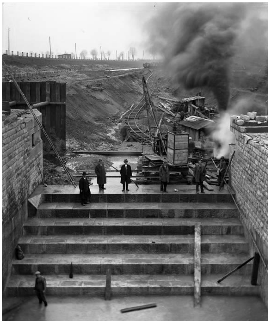
Obr. 5.16 Stupňovitý prah vývaru hate Smiřice na rieke Labe, ČR (Zdroj: smirice.eu, © Ing. Plška)
