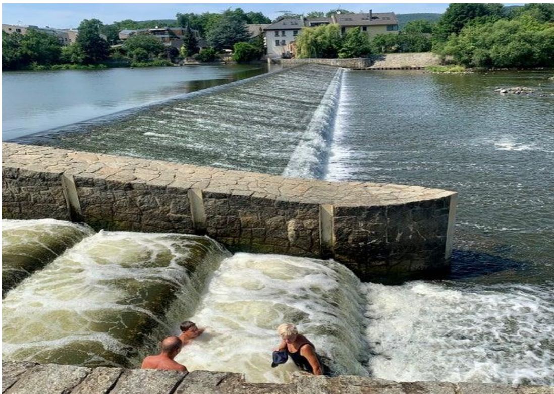
Obr. 10.11 Pevná hať Dobřichovice na rieke Berounka, ČR (Zdroj: foursquare.co, © Progtressor)
