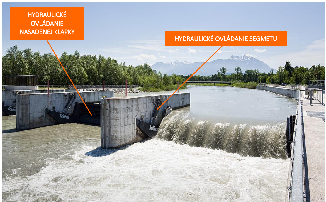
Obr. 8.89 Prepúšťanie prietoku cez klapku nasadenú na segmente ovládaným hydraulickým piestom s celkovou hradiacou výškou 4,6 m a hradiacou šírkou 15 m na Vodnom diele Illspitz na rieke Rýn, Rakúsko (Zdroj: stadtwerke-feldkirch.at)
