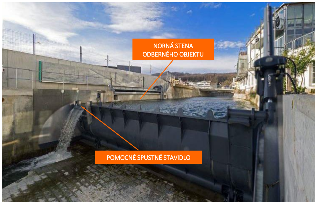
Obr. 8.50 Prepúšťanie plavenín zachytených na odbernom objekte cez pomocné spustné stavidlo jednostranne zavesenej dutej klapky hate Liestal, Švajčiarsko (Zdroj: wild-metal.com)
