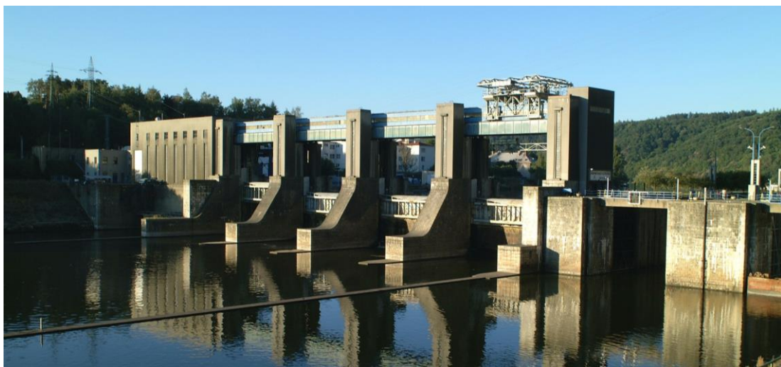
Obr. 5.61 Stavidlový (dvojitý) uzáver hate Vodné diela Vrané nad Vltavou, ČR (Zdroj: cez.cz)
