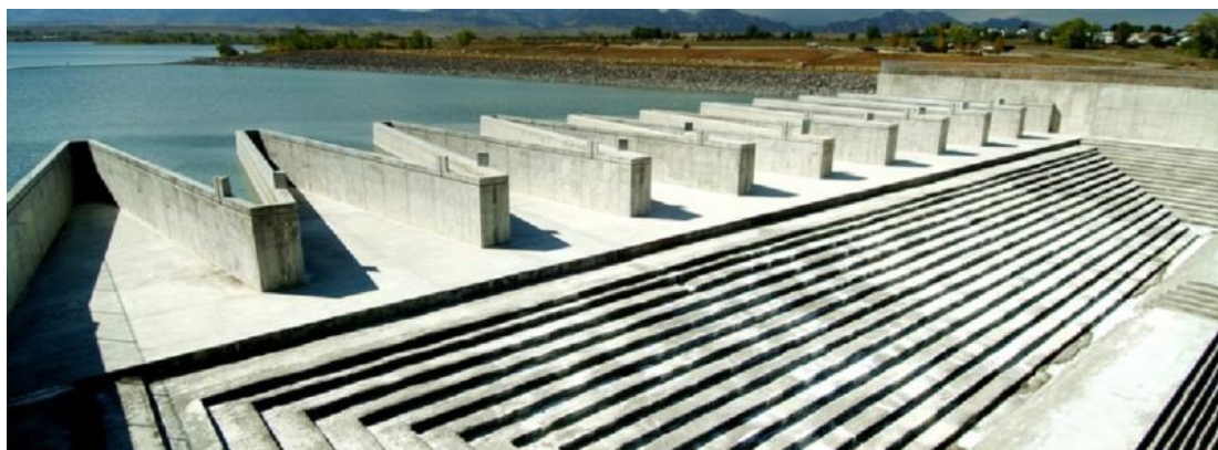
Obr. 7.3 Labyrintová hať Standley Lake, Westminster, Colorado, USA (Zdroj: researchgate.net, © K. Warren Frizell)
