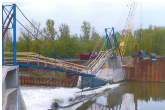
Obr. 6.20 Havária hate Shih-Kang (Thajsko) spôsobená prelomením podložia (Zdroj: ntuce-newsletter.tw) Havária hate Shih-Kang (Thajsko) spôsobená prelomením podložia
