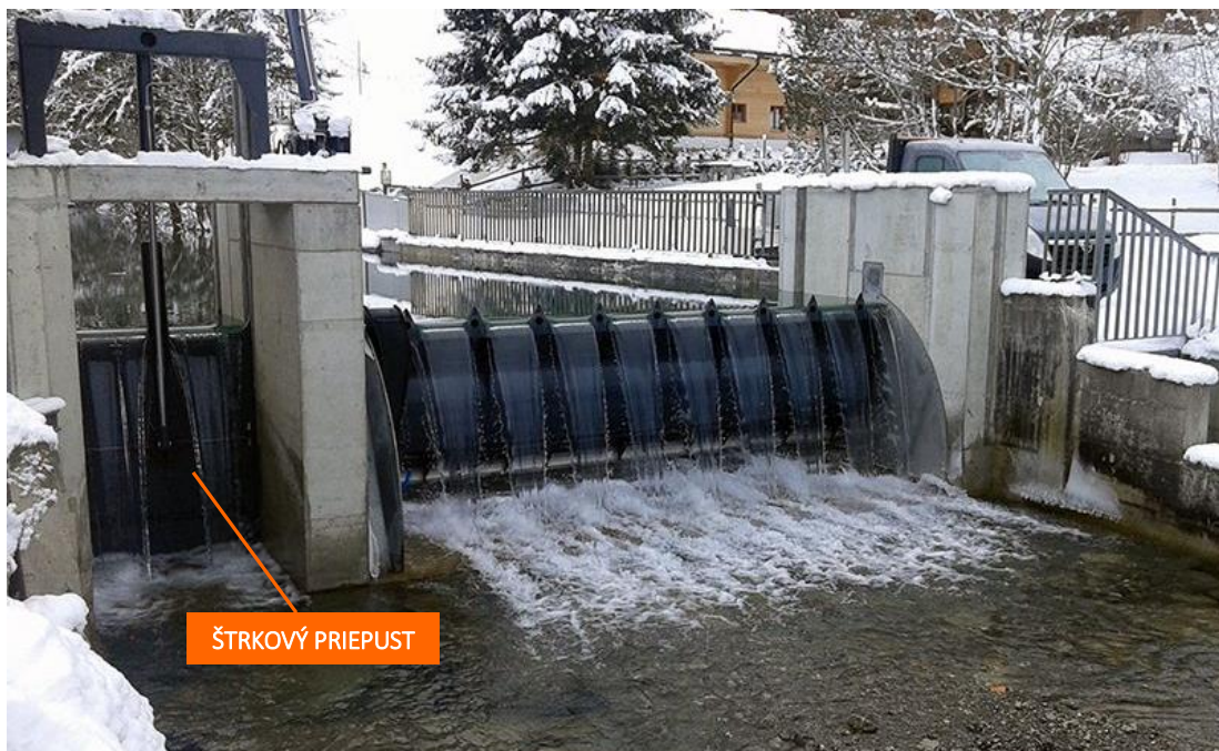
Obr. 8.48 Prepad vody ponad jednostranne zavesenú dutú klapku s hradiacou šírkou 6 m a hradiacou výškou 1,4 m na hati Gsteig, Švajčiarsko (Zdroj: wild-metal.com)
