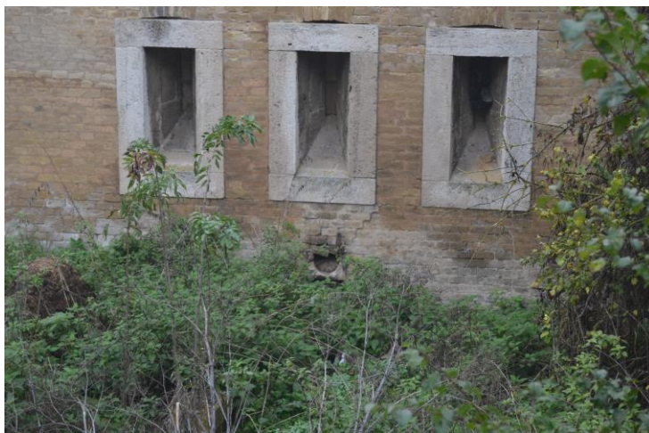
Obr. 5.21. Zostava troch puškových strieľní – pohľad z vonkajšej strany
