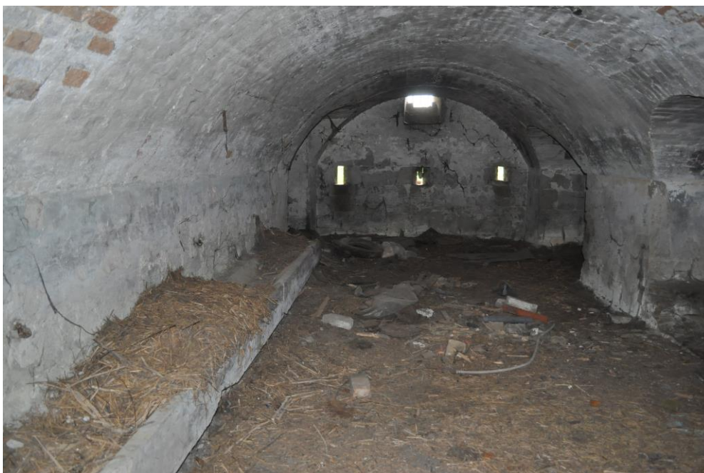
Obr. 5.14. Kazemata s troma puškovými strieľňami v čelnom múre
