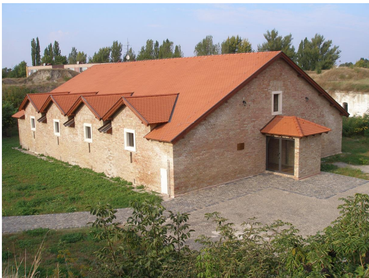
Obr. 5.52. Skutočne postavený sklad strelného prachu v komárňanskej Novej pevnosti
