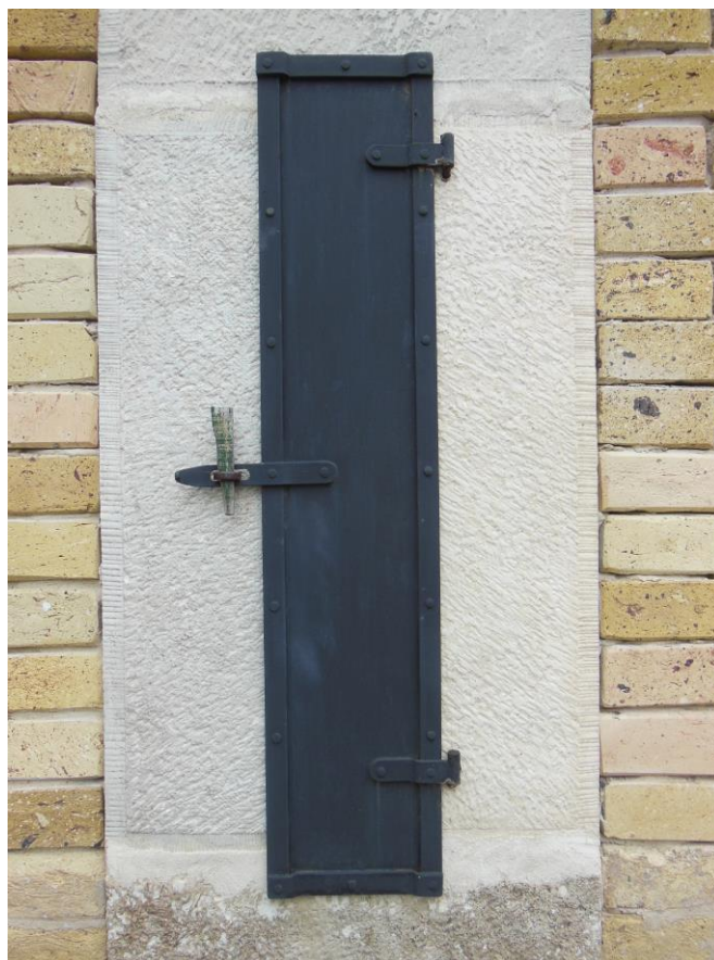
Obr. 5.30. Plechová (dobovo) nepriestrelná okenica ako krytie strieľne z vonkajšej strany
