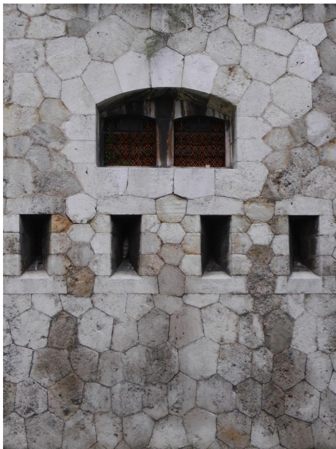
Obr. 5.28. Zostava štyroch puškových striel'ní s vetracím oknom
