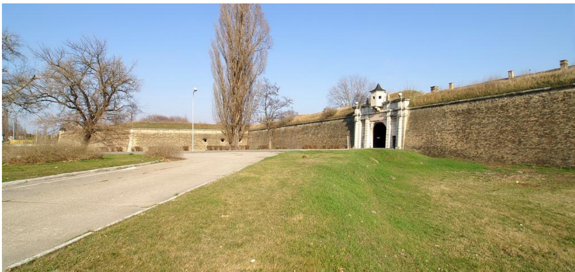
Obr. 5.33. Predpolie komárňanskej Novej pevnosti, kde sa pôvodne nachádzala močaristá priekopa. Dnes je zasypaná a zatrávnená.
