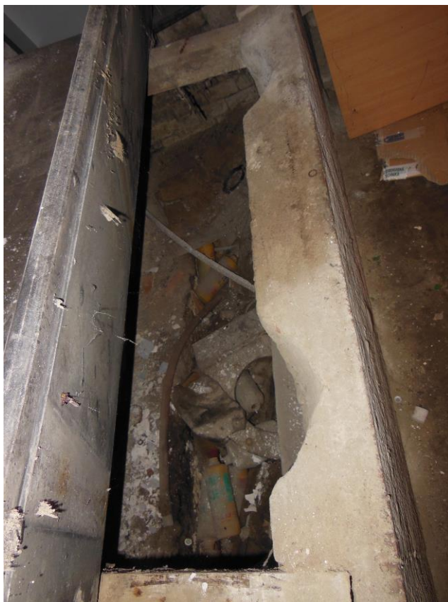
Obr. 5.35. Zachovaná pôvodná toaleta (suchý záchod) v Batérii X komárňanskej pevnosti
