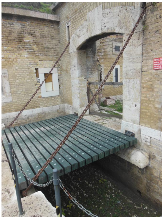
Obr. 5.45. Rekonštruovaný náznak zdvíhacieho mosta VII. bastiónu Vážskej línie v Komárne
