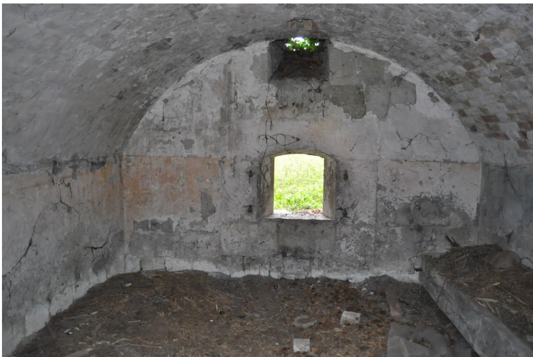
Obr. 5.15. Kazemata s jednou delovou strieľňou v čelnom múre
