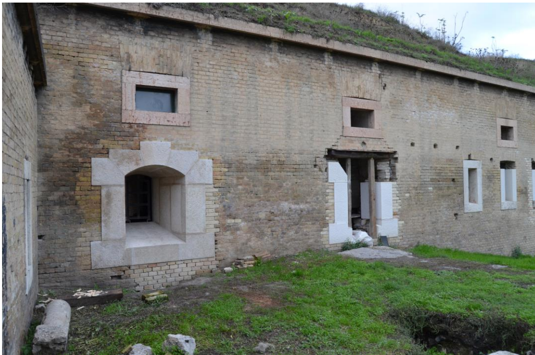
Obr. 5.24. Perfektne realizovaná obnova delostreleckých strieľní a ich vetracích okien pánom Kubíkom na Bastióne č. VII v Komárne
