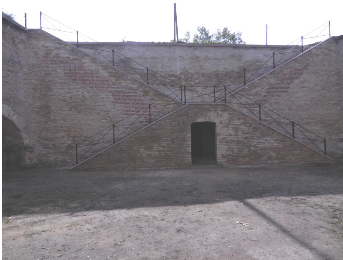
Obr. 5.47. Tzv. „Myšie schody“ v Starej pevnosti v Komárne. Zábradlie je moderný doplnok.
