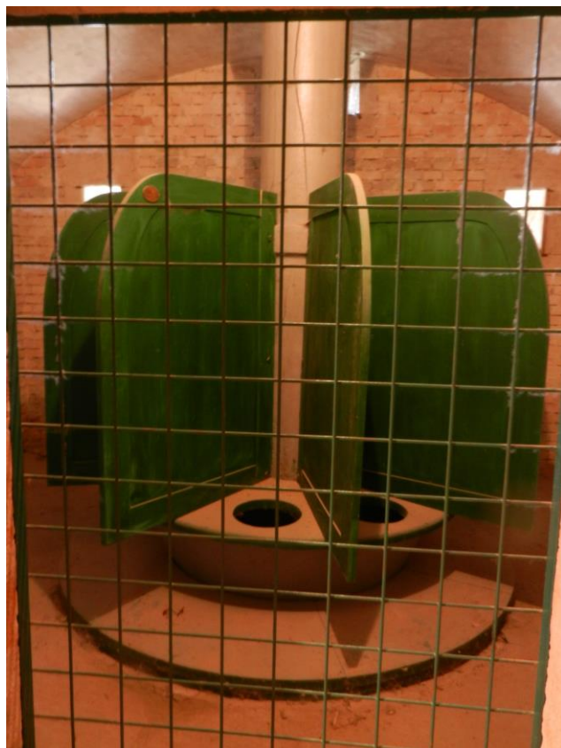
Obr. 5.36. Obnovená spoločná toaleta v pevnosti Sandberg v Komárome
