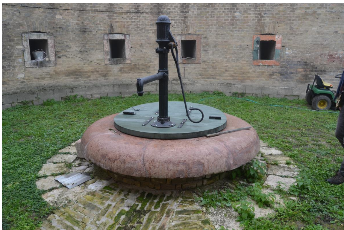
Obr. 5.57. Rekonštruovaná pumpa nad studňou v bastióne VII. Vážskej línie komárňanskej pevnosti
