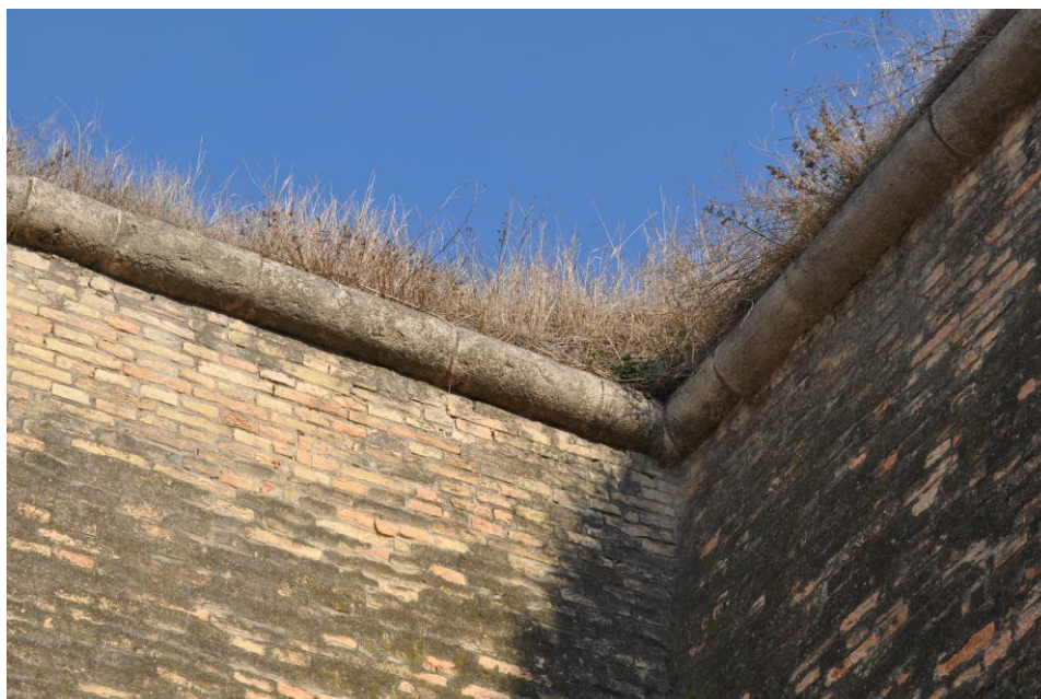
Obr. 5.7. Typ zaobleného kordónu na komárňanskej Starej pevnosti
