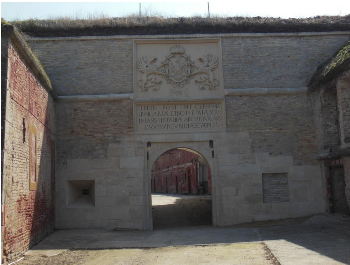
Obr. 5.37. Vzhľad Ferdinandovej brány do Starej pevnosti v Komárne po reštaurátorskom zásahu. Erb a nápis nad bránou by ale mali byť vyfarbené.
