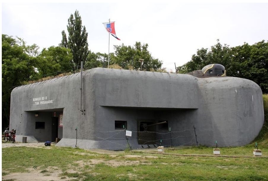
Obr. 1.17. Pechotný zrub BS-8 Hřbitov bratislavského medzivojnového opevnenia [ https://www.napaleta.sk ]
