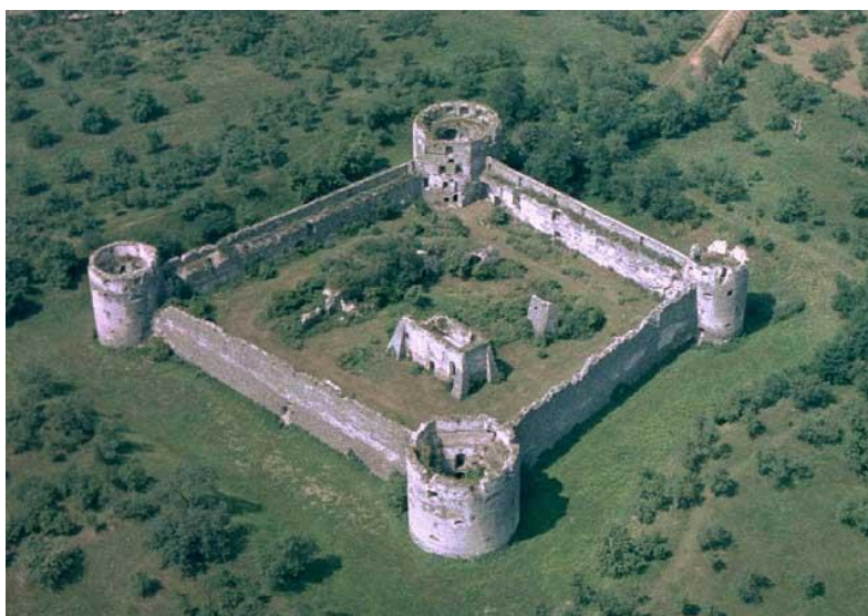
Obr. 1.6. Opevnenie kláštora Bzovík rohovými vežami, ktorých využitie sa približuje funkcii rondelov [ https://forum.index.hu ]
