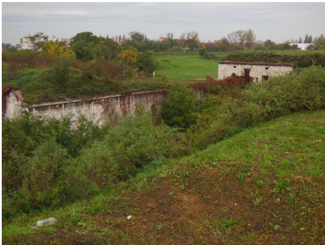
Obr. 5.3. Kontreskarpa (vľavo) a zarastená priekopa Palatínskej línie v pevnosti Komárno
