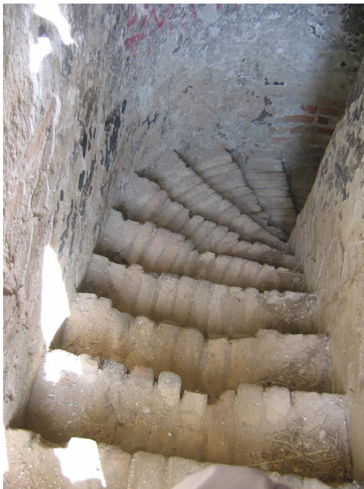
Obr. 5.48. Murované tehlové schody na valy Starej pevnosti v Komárne
