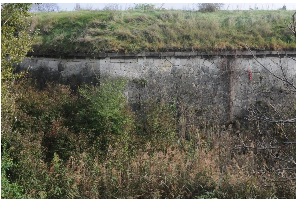
Obr. 5.2. Eskarpa (a zarastená priekopa) Palatínskej línie v pevnosti Komárno
