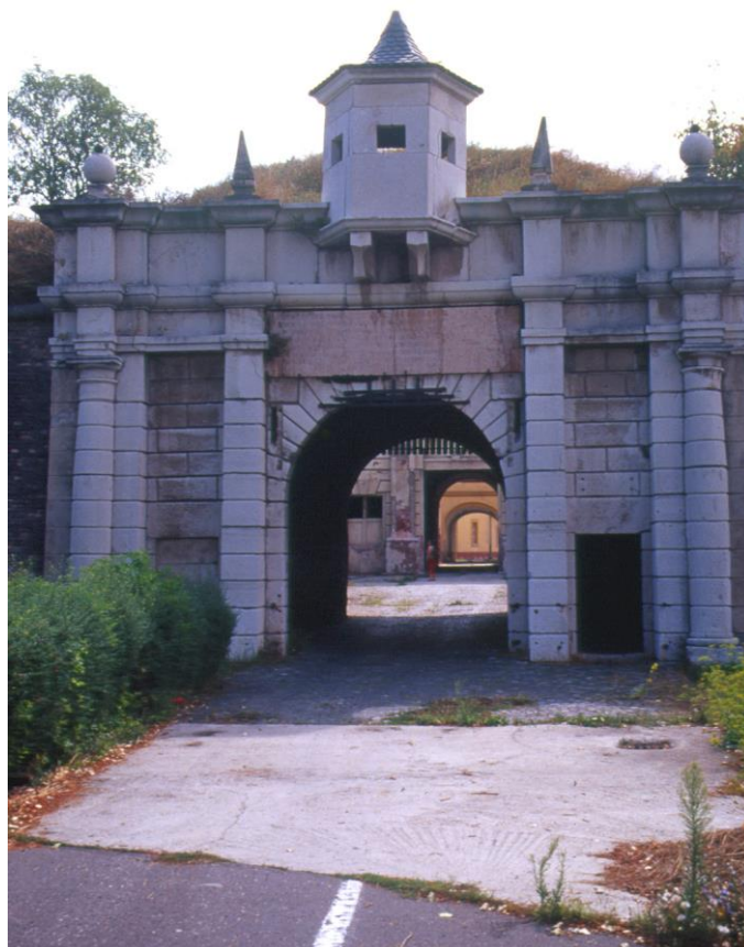
Obr. 5.39. Vonkajšia fasáda Leopoldovej brány Novej pevnosti v Komárne aj so strážnou vežičkou
