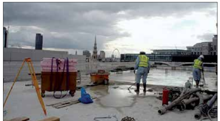
Na streche 20 Farringdon, počas betonáže strechy.
