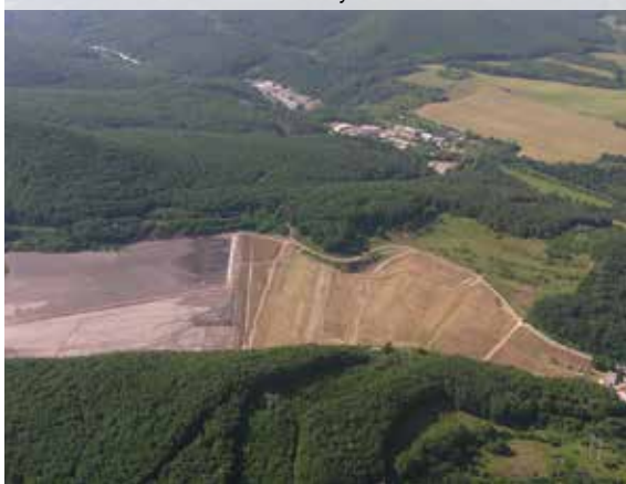
Odkalisko Zemianske Kostoľany – Pôvodné
