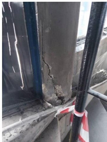
Obr. č.3 Lokálne porušenie prierezu
