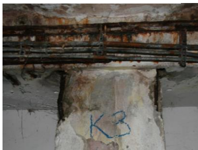
Obr. 6: Uloženie prievlakov na a) oceľové stĺpy, b) betónové stĺpy
