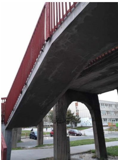
Obr. 5 Pohľad na schodiskové rameno po rekonštrukcii
