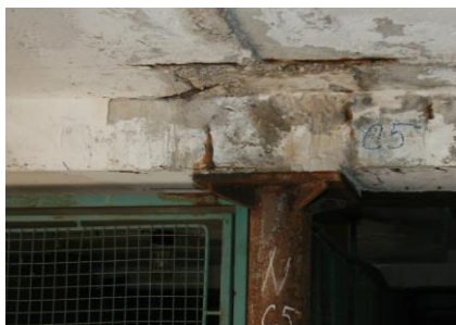
Obr. 6: Uloženie prievlakov na a) oceľové stĺpy, b) betónové stĺpy
