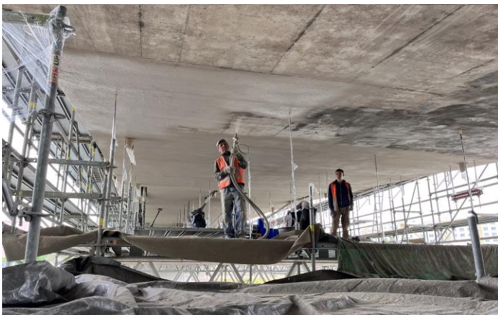
Obrázok 2 Pred a počas aplikácie Mapelastic Guard (most Hlohovec II/513)
