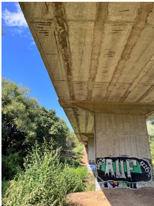
Obrázok 1 Most na ceste II/581 z prefabrikovaných nosníkov
