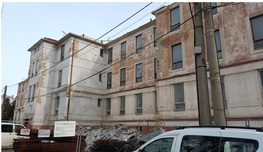
Obr. 1 Pohľad na budovu po odstránení krovu
