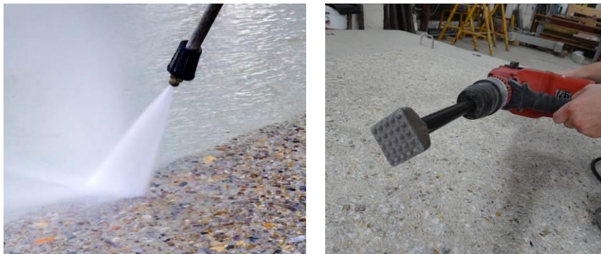
Obr. 1 Zdrsňovanie betónového povrchu pomocou vodného lúča (vľavo) [2] a pomocou sekacieho kladiva so štokovacou hlavicom Hilti TE-YX-BT (vpravo)
