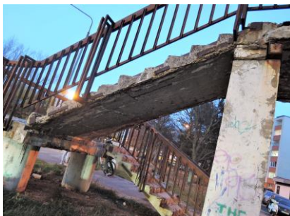
Obr. 2 Degradácia nosných prvkov: a) obvodového nosníka, b) schodiska
