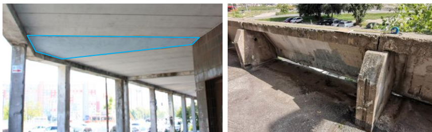
Obr. 1 Monolitickú časť stropu v rohových dilatačných celkoch vľavo a betónové zábradlie vpravo
