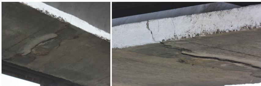
Obrázok 10 Trhliny medzi segmentami
