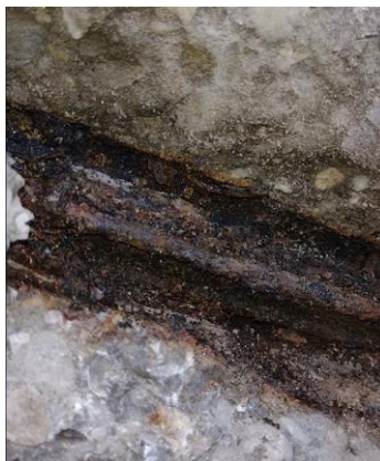
Obrázok 2 Korózia predpínacích drôtov
