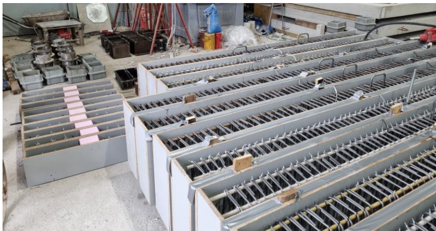
Obr. 2 Vystuženie nosníkov pred betonážou
