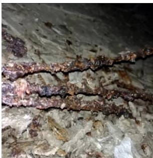
Obrázok 6 Korózia predpínacej výstuže
