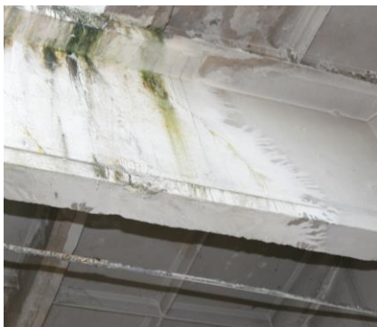
Obr. 5: Poškodenie prvkov: a) strešného panela, b) šikmá trhlina v strešnom väzníku
