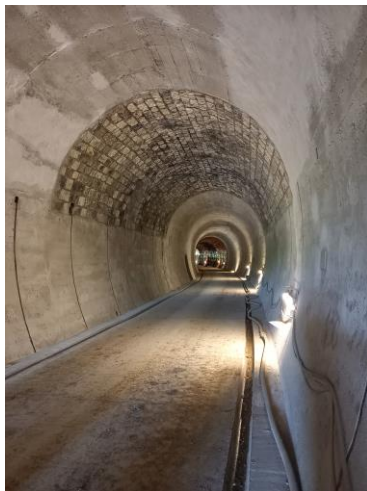
Obr. 4 - Ostenie tunela po aplikovaní XYPEX
