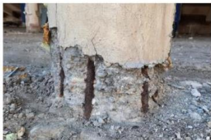
Obr. č.4 Obnažená výstuž v päte fasádneho stĺpa
