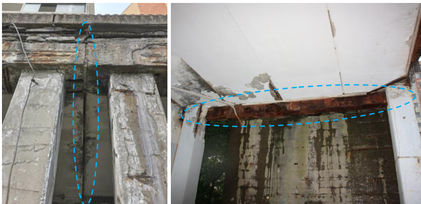
Obr. 2 Stredná a krajná dilatačná škára
