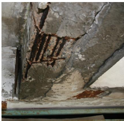
Obr. 6: a) korózia výstuže stužidla, b) degradácia pórobetónového atikového panela
