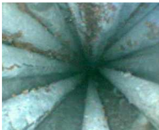
Obr. 2.4 Endoskopická vizuální kontrolu prostoru za kotvami předpínacího systému
