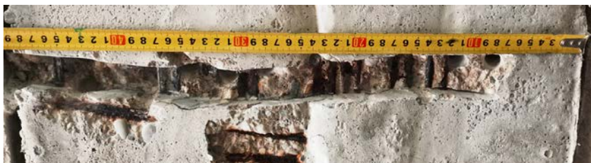
Obrázok 3.2: Vystuženie prefabrikátov Hájek
