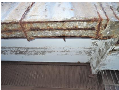
Obr. 2 Degradácia nosných prvkov: a) obvodového nosníka, b) schodiska
