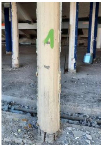
Obr. č.4 Obnažená výstuž v päte fasádneho stĺpa
