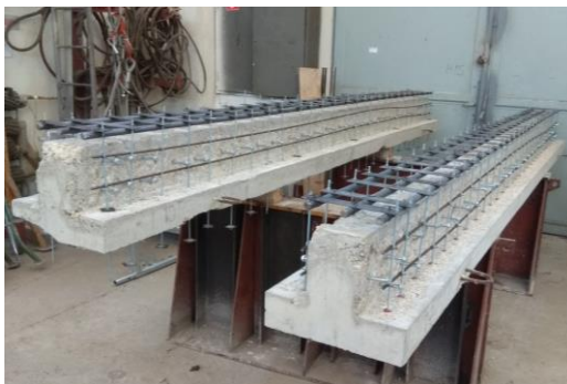
a) Nosník C a B - príprava výstuže
