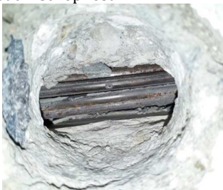
Obr. 2.3 Vizuální zhodnocení předpínací výztuže
