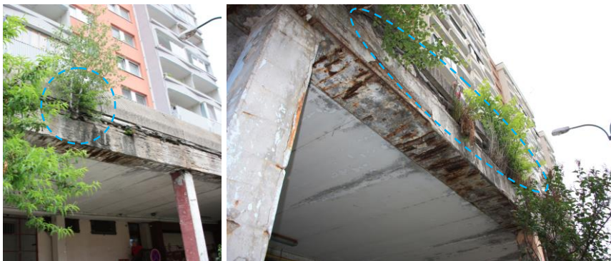
Obr. 4 Nežiadúca vegetácia vyrastajúca z voľnej strany terasy
