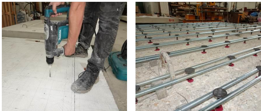
Obr. 2 Aplikácia spriahovacej výstuže
