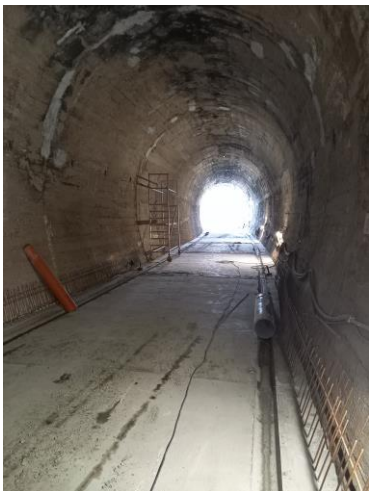
Obr. 3 - Ostenie tunela pred aplikovaním XYPEX
