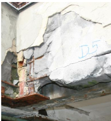
Obr. 6: a) korózia výstuže stužidla, b) degradácia pórobetónového atikového panela
