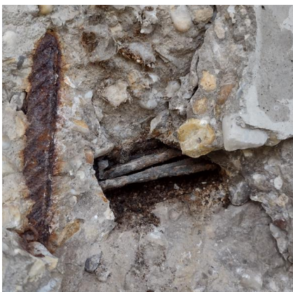
Obrázok 2 Korózia predpínacích drôtov
