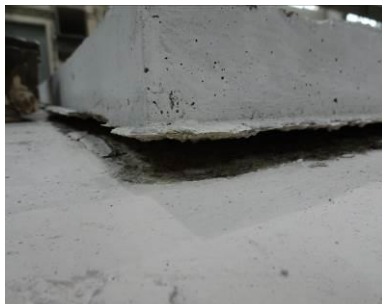
Obr. 4 Odlepenie nadbetonávky od pôvodnej dosky
