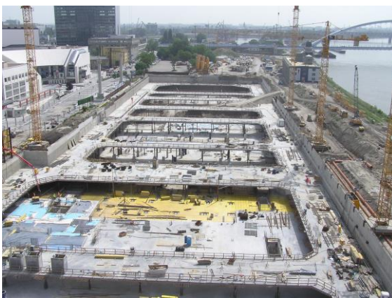
Obr. 1 Biela vaňa s horizontálnym rozperným rámom
