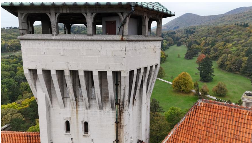
Obr. 2 Rozšírenie veže pod vyhliadkou
