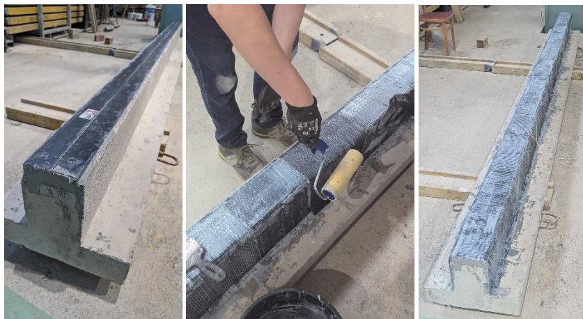
Obr. 3 Zosilňovanie nosníka D
