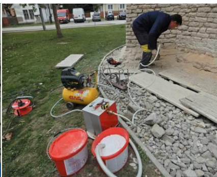
Obr. 4 a 5. Vľavo je stroj režúci murivo s pomocou „diamantového“ lana a vpravo injektážna súprava v akcii.
