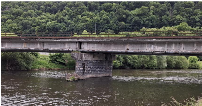
Obr. 1 Pohľad na mostný objekt preklenujúci rieku Hron
