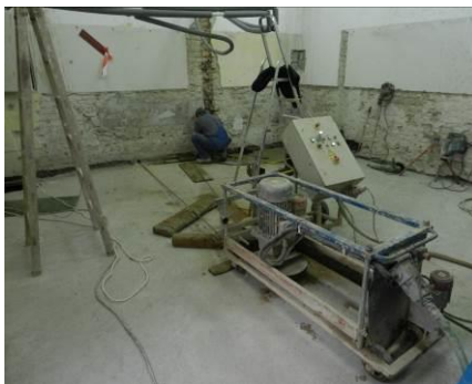
Obr. 4 a 5. Vľavo je stroj režúci murivo s pomocou „diamantového“ lana a vpravo injektážna súprava v akcii.
