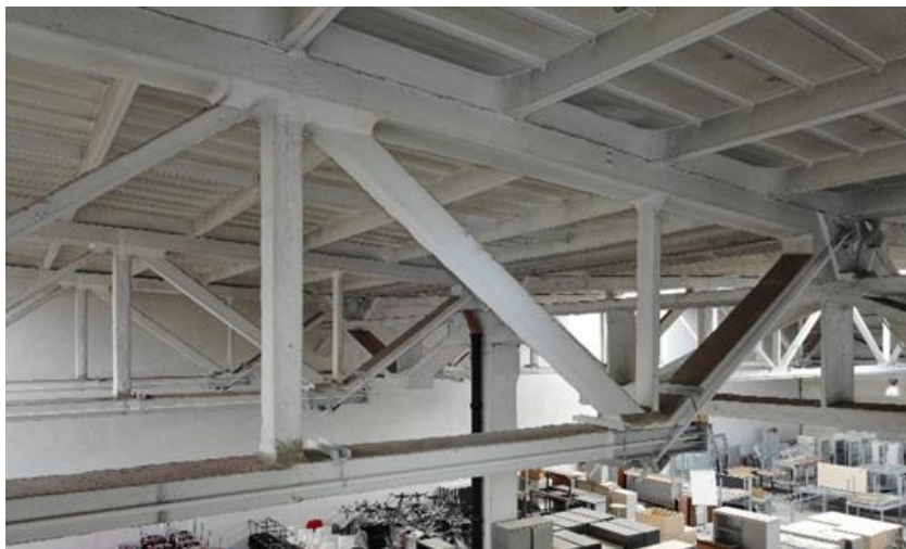
Obr. 11 – Realizované sanácie na 18m väzníkoch
