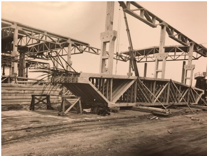
Obr. 2: Predpínanie na stavbe SPP 9 24-6 – unikátna historická fotografia
