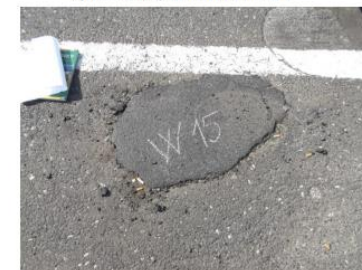
Oprava vozovky označená ako W 15
