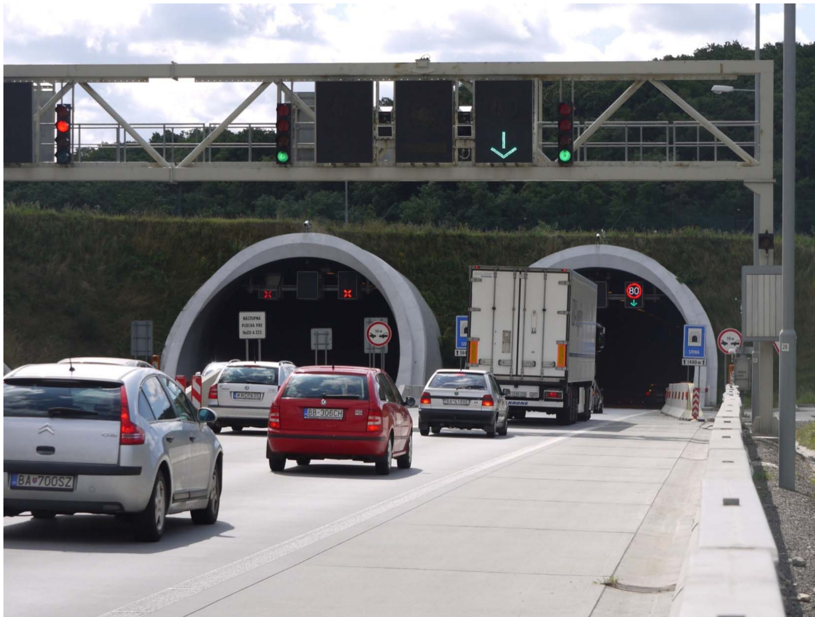
Tunel Sitina (1440 m) – prvý tunel s dvomi rúrami, otvorený v r. 2007
