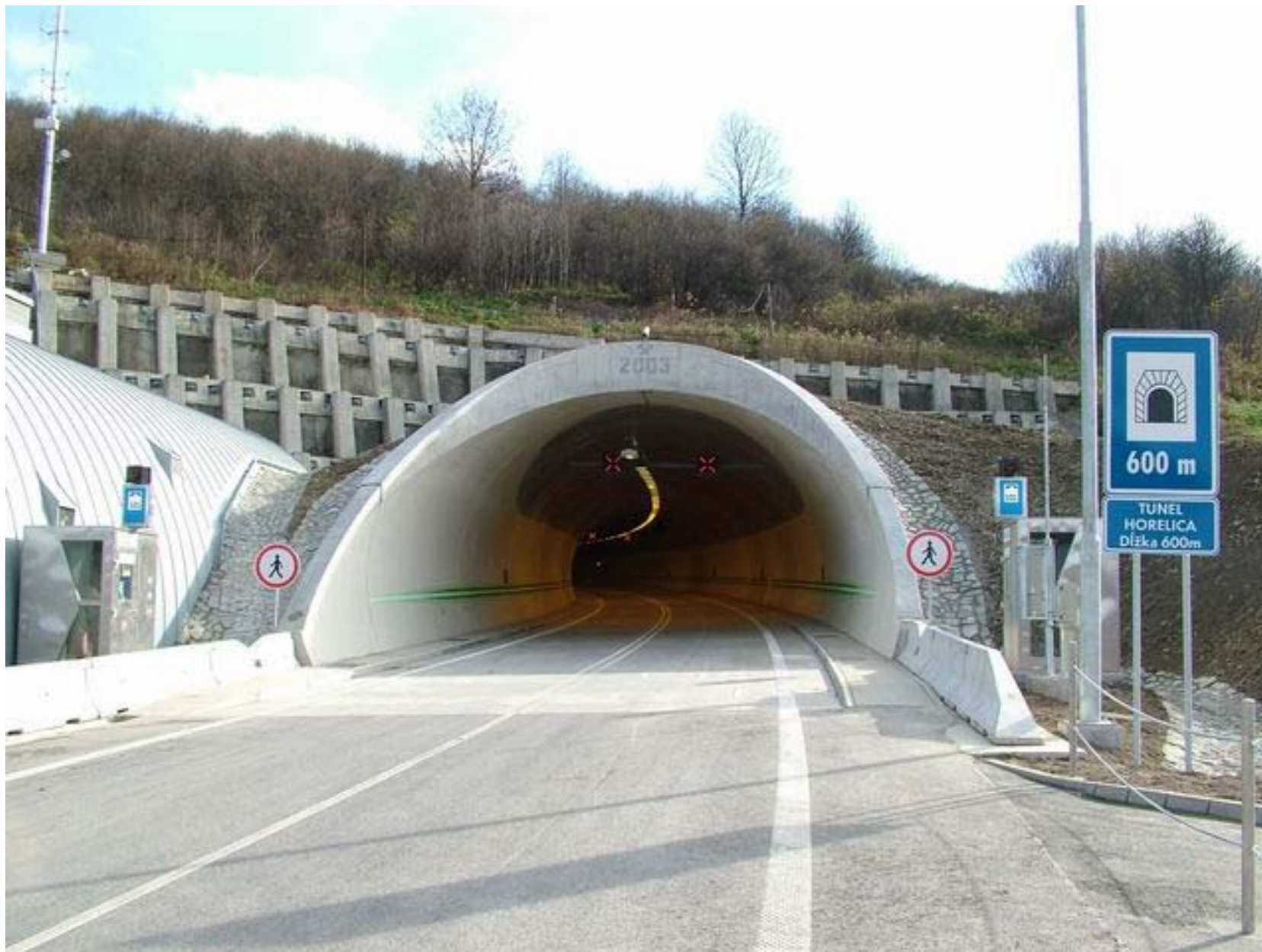
Tunel Horelica (600 m) otvorený v r. 2004
