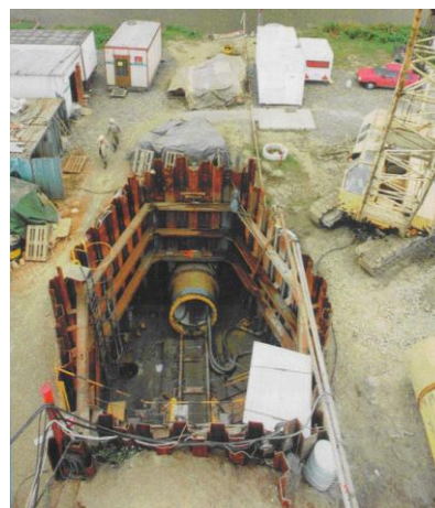
VYHOTOVENIE PODCHODU Ø 1650 mm PRE PLYNOVOD DN 500 mm PRETLÁČANÍM CHRÁNIČKY IZX 21/10 V POD RIEKU MORAVU V K.Ú. VYSOKÁ PRI MORAVE
