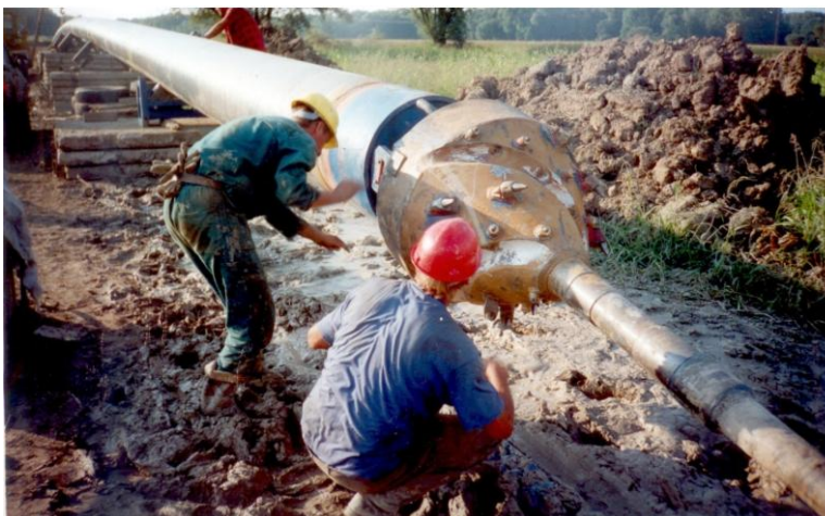
Zaťahovanie ocelového potrubia VTL plynovodu \varnothing 711 x 11 mm dlhé 300 m pod riekou Moravu
