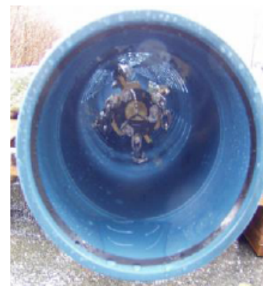
Bild 7: ins Rohr eingebrachte Kettenschleuder
