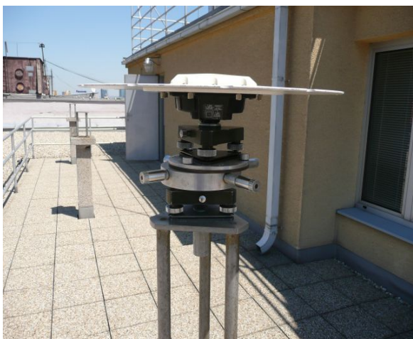
Obr. 7.1 Osadenie antény na posuvnom zariadení
