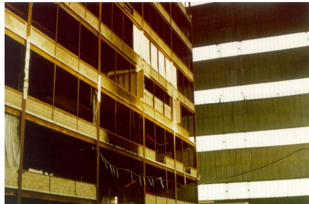
Obr. 3 Osem-podlažná ocelobetónová budova s požiarnym úsekom
