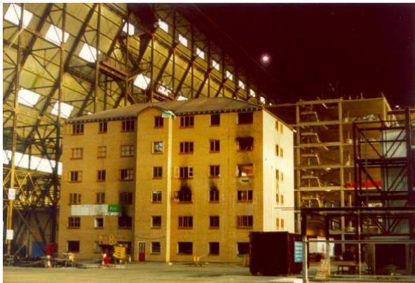
Obr. 2 Šesťpodlažná drevená (v popredí) a sedempodlažná železobetónová budova
