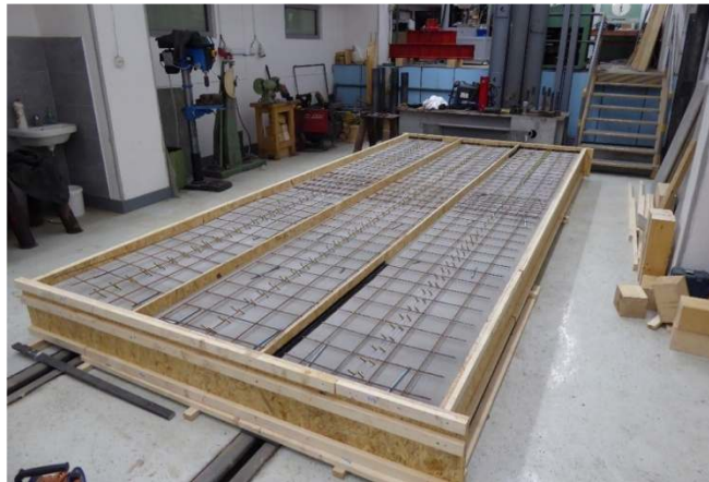
Obr. 4 - Debnenie betónovej časti vzoriek pred betonážou – 1. etapa nosníkov
