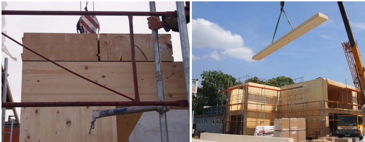
Obr. 2 - Montáž stropu a strechy
