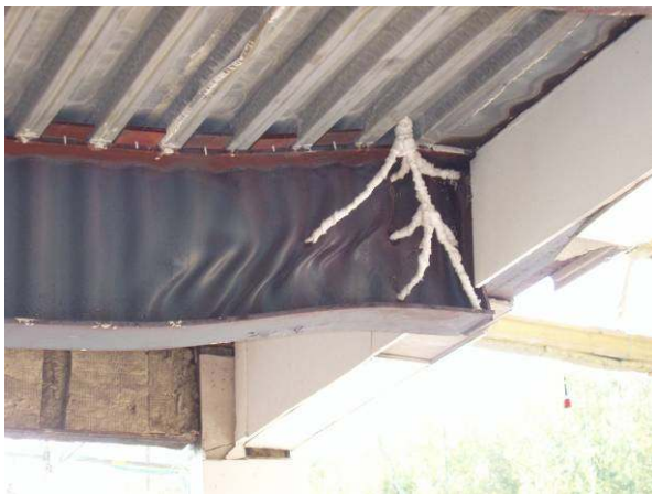
Obr. 7 Šmykové pole nosníka s vlnitou stenou
