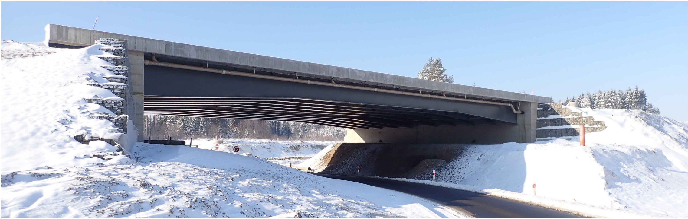
MOSTNÝ OBJEKT NA DIALNICI D3 ÚSEKU TŘEBONÍN - KAPLICE
