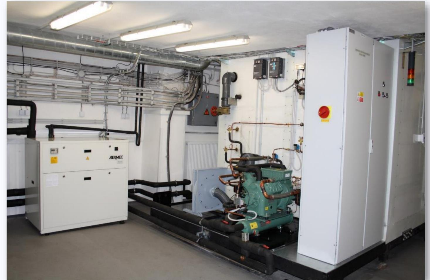
Blick auf den technologischen Teil der großen Klimakammer für die Simulation von synergistischen Vorgängen der Wärmeübertragung, Wasserdampfdiffusion und Luftfiltration.
