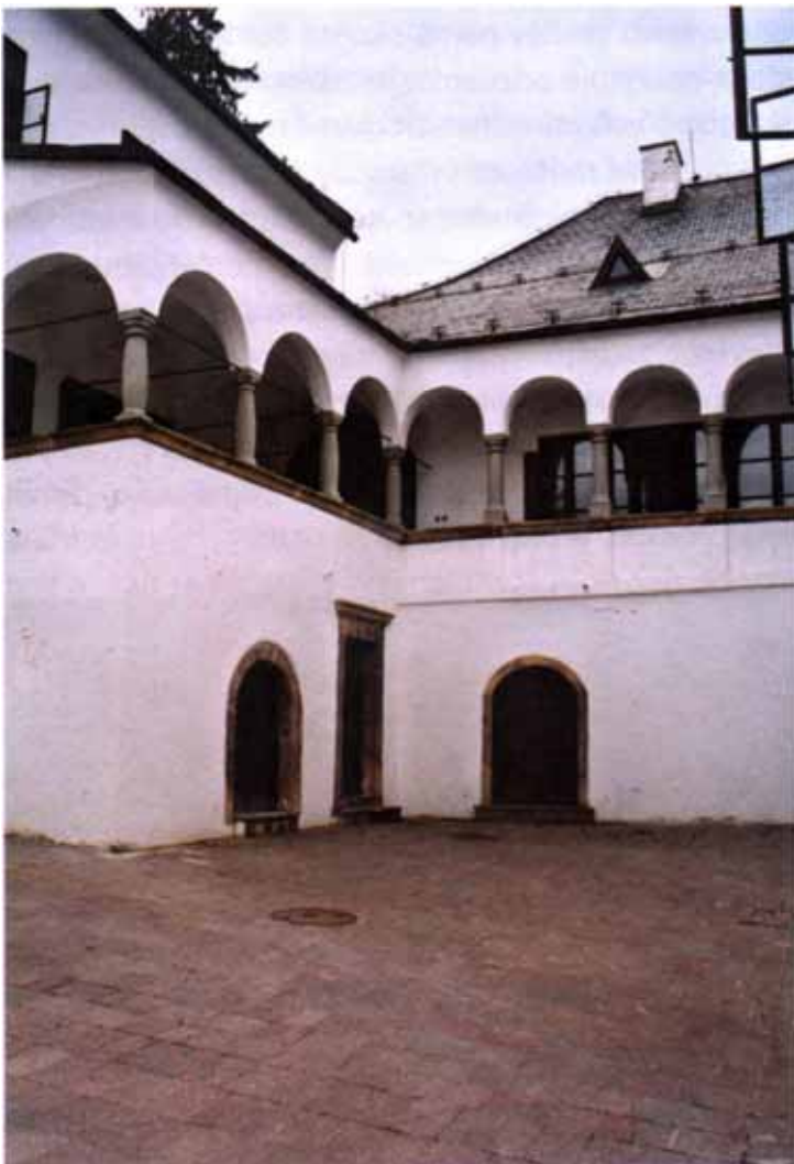
Kombinovaný systém prelínajúceho sa stenového a skeletového princípu stavby
