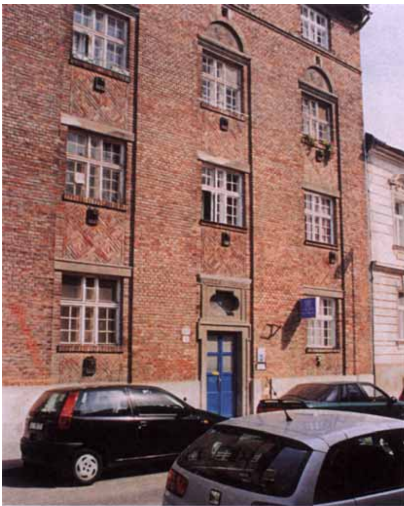
Obvodový plášť stavby z tehál
