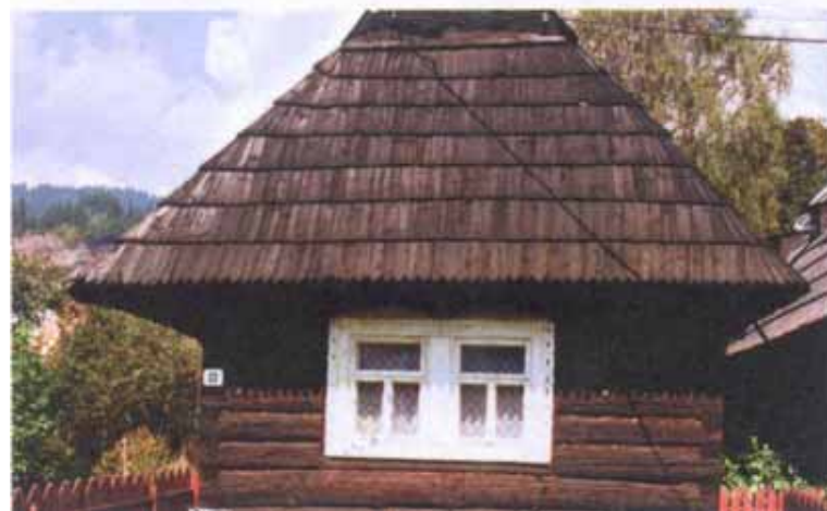
Obvodový plášť objektu z dreva - drevená zástavba obce Podbieľ
