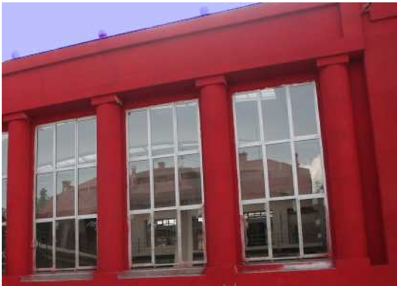
Ľahký obvodový plášť – vsúvaný medzi stĺpy
