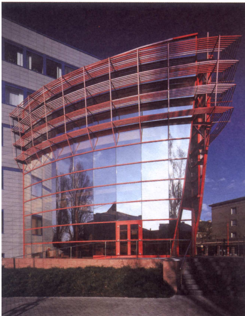
Pološtruktúrovaná fasáda s priznaným horizontálnym rastrom
